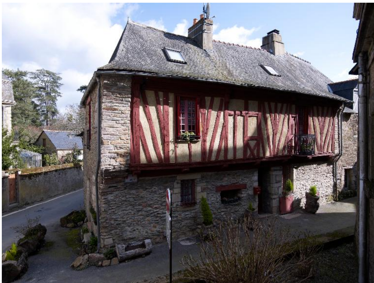
Maison : élévation donnant sur la rue du Lion d'Or (état en 1988)
