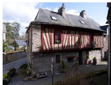
Maison : élévation donnant sur la rue du Lion d'Or (état en 1988) Phot. Bernard Bègne IVR53_20125601445NUCA
