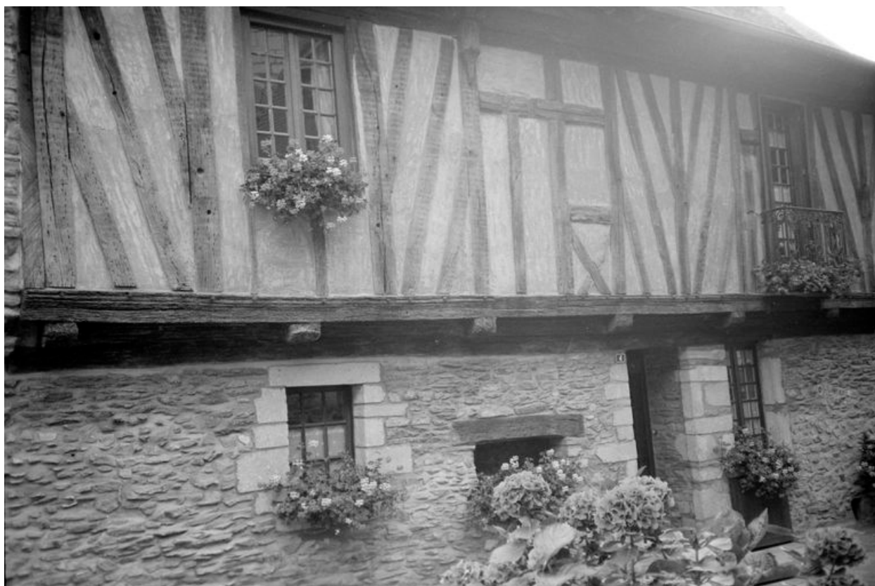
Maison : élévation donnant sur la rue du Lion d'Or vue du nord-ouest (état en 1988)
