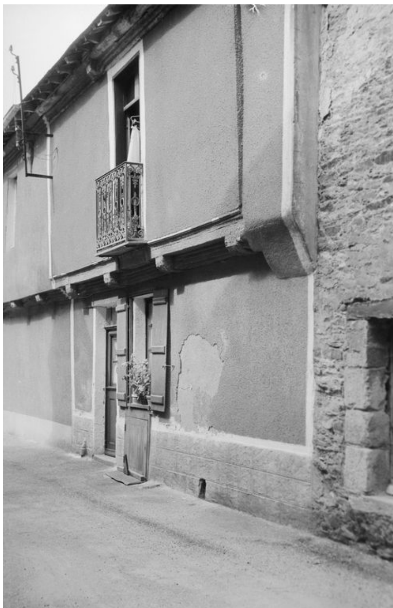
Maison : élévation donnant sur la rue du Lion d'Or vue du sud-ouest (état en 1988) (état en 1969)
