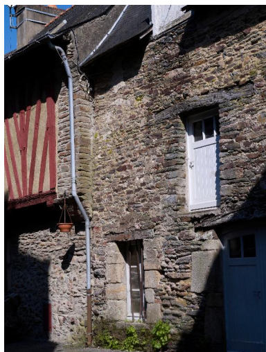
Maison : mur latéral formant un léger renflement à partir du 1er étage, pour contenir le pan de bois qui avance (état en 2012) Phot. Bernard Bègne IVR53_20115600441NUCA
