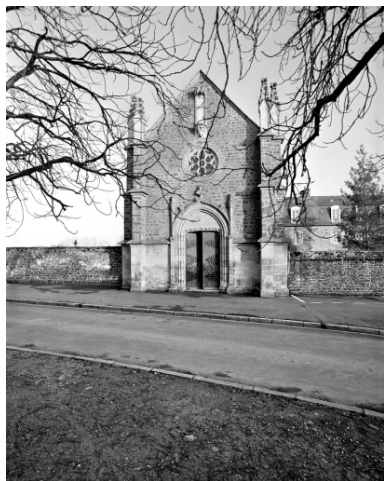
Elévation ouest : vue générale Phot. Guy Artur, Phot. Norbert Lambart IVR53_19923500997X
