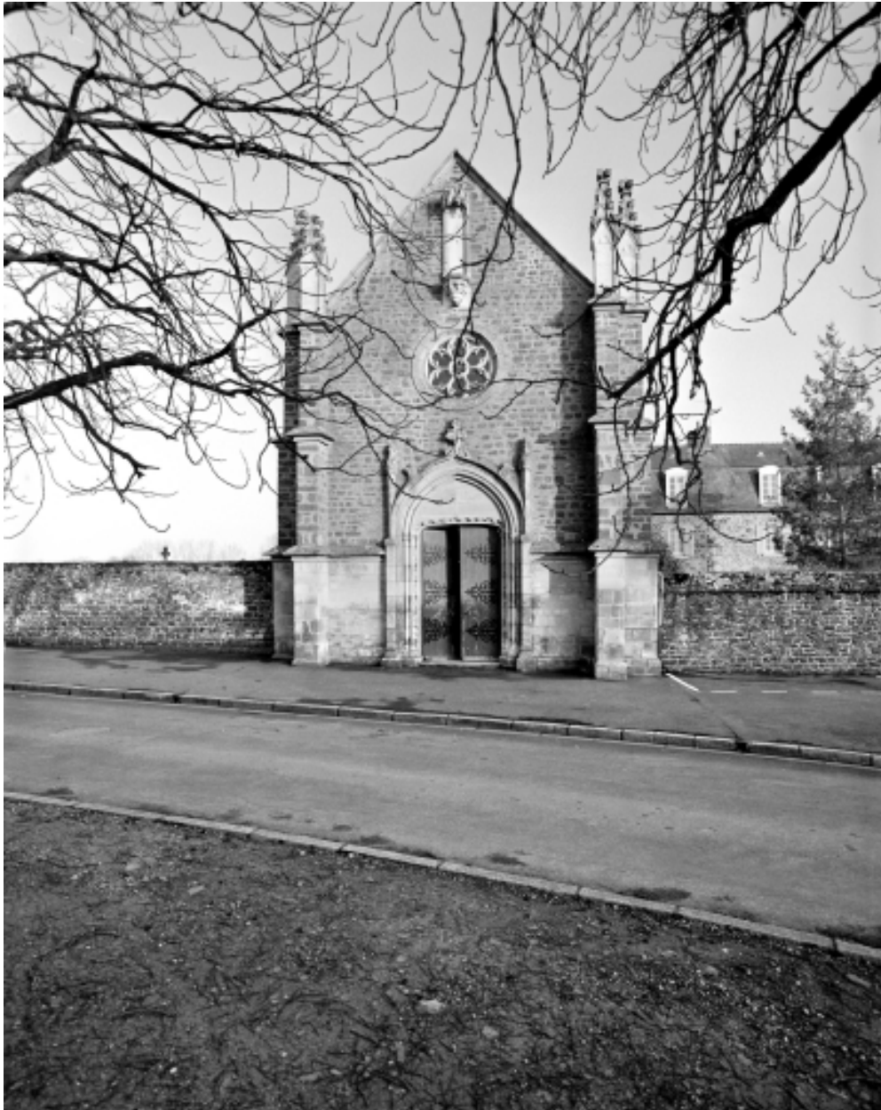
Elévation ouest : vue générale
