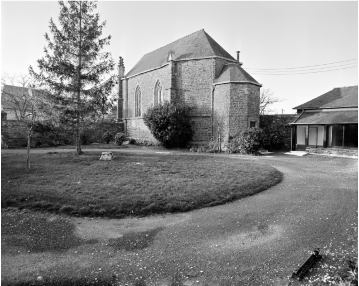
Elévation sud-est, chevet : vue générale
