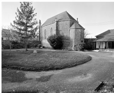
Elévation sud-est, chevet : vue générale Phot. Guy Artur, Phot. Norbert Lambart IVR53_19923500998X
