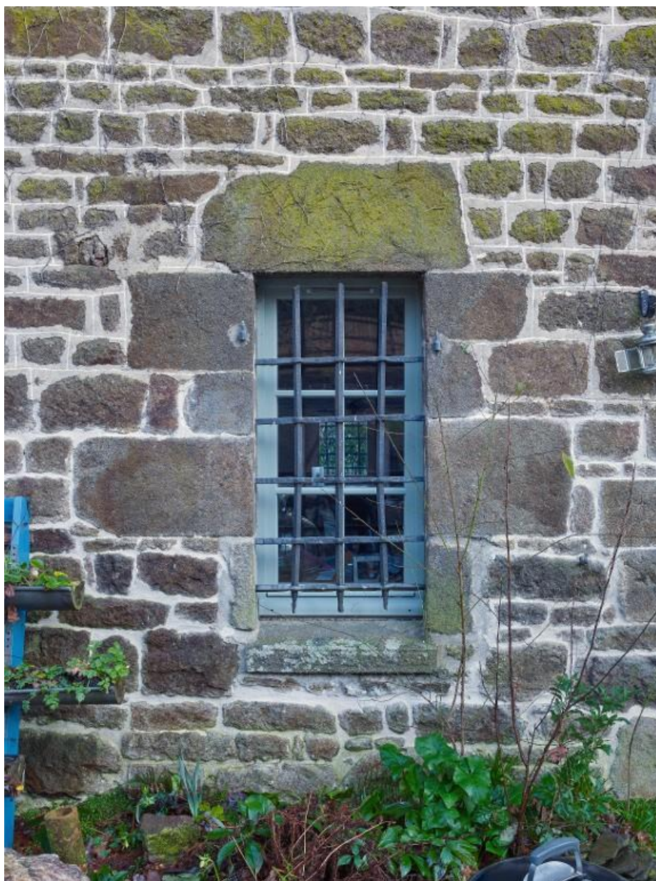
Façade sud. Fenêtre de la salle ouest agrandie au 20e siècle
