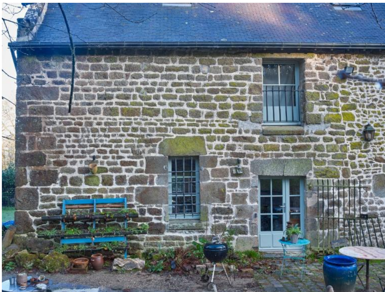
Façade sud. Partie ouest avec salle surmontée d'un surcroît
