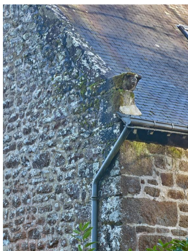
Pignon découvert ouest. Détail de la pierre d'assise du rampant, ornée d'une tête Phot. Bernard Bègne IVR53_20253500096NUCA
