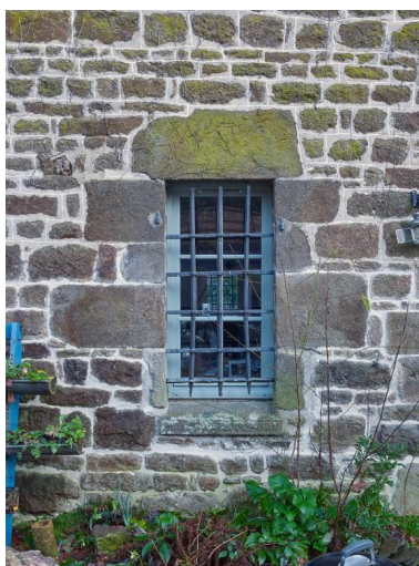
Façade sud. Fenêtre de la salle ouest agrandie au 20e siècle Phot. Bernard Bègne IVR53_20253500088NUCA
