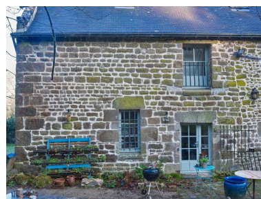
Façade sud. Partie ouest avec salle surmontée d'un surcroît Phot. Bernard Bègne IVR53_20253500083NUCA
