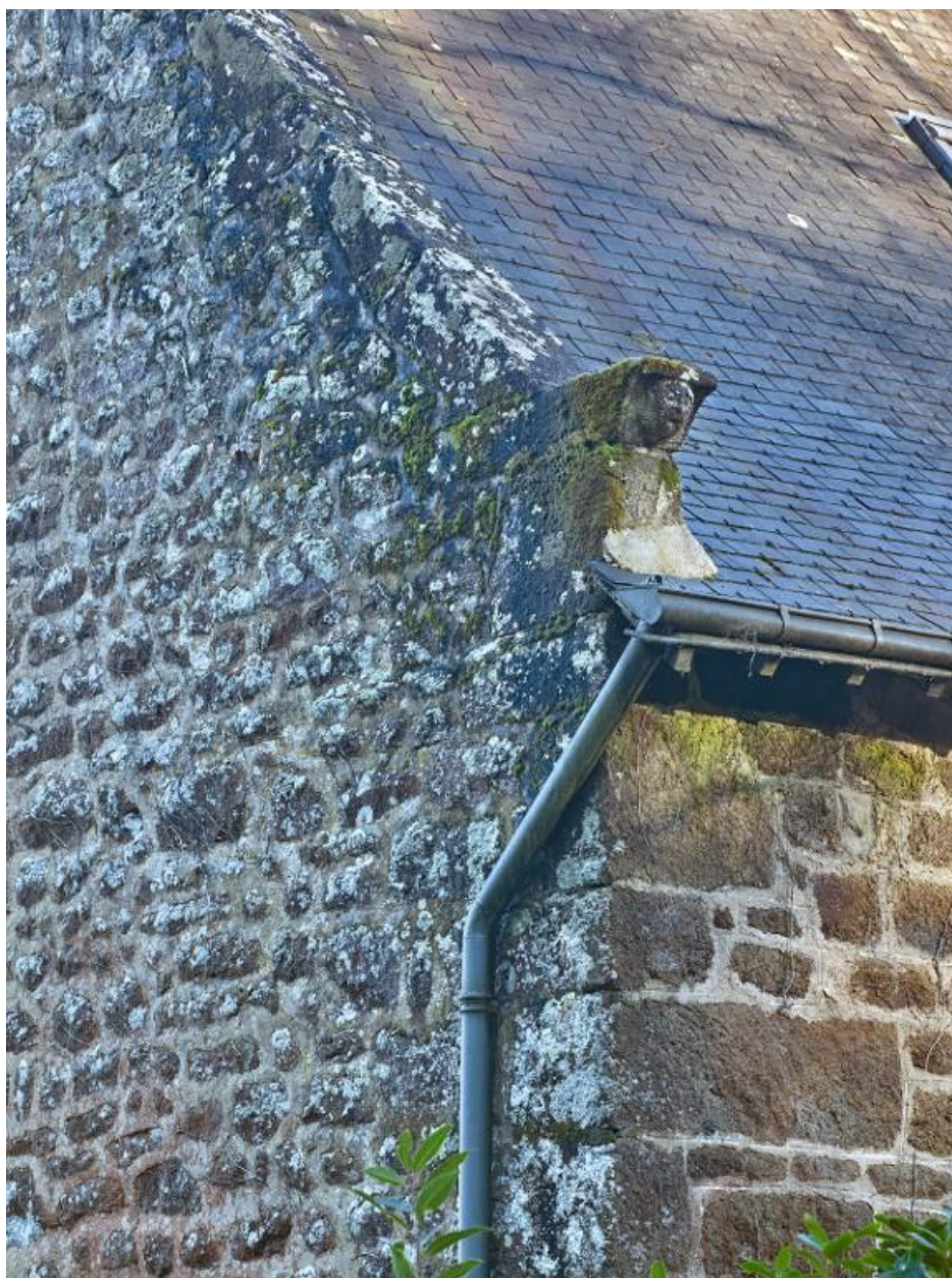
Pignon découvert ouest. Détail de la pierre d'assise du rampant, ornée d'une tête
