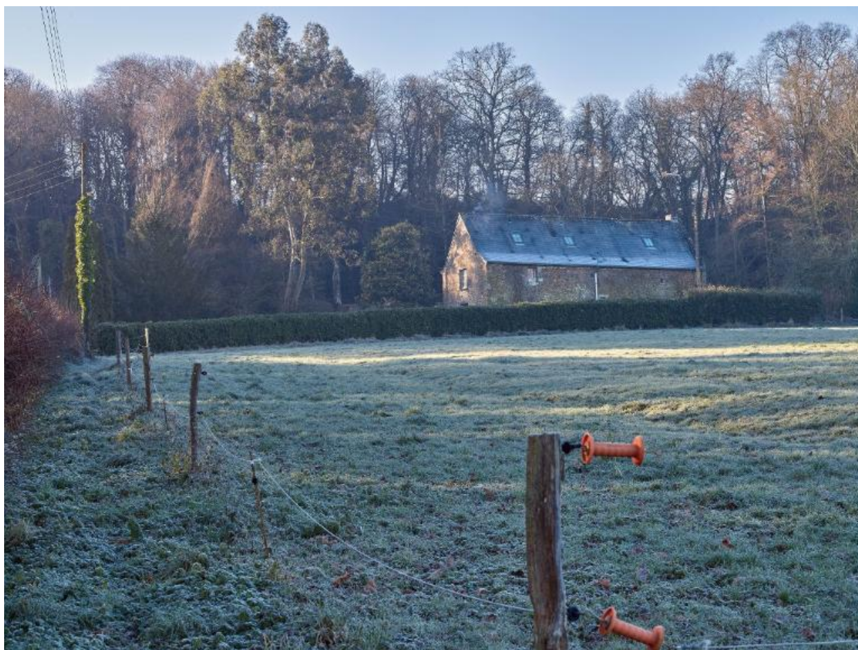
Vue de situation prise au nord
