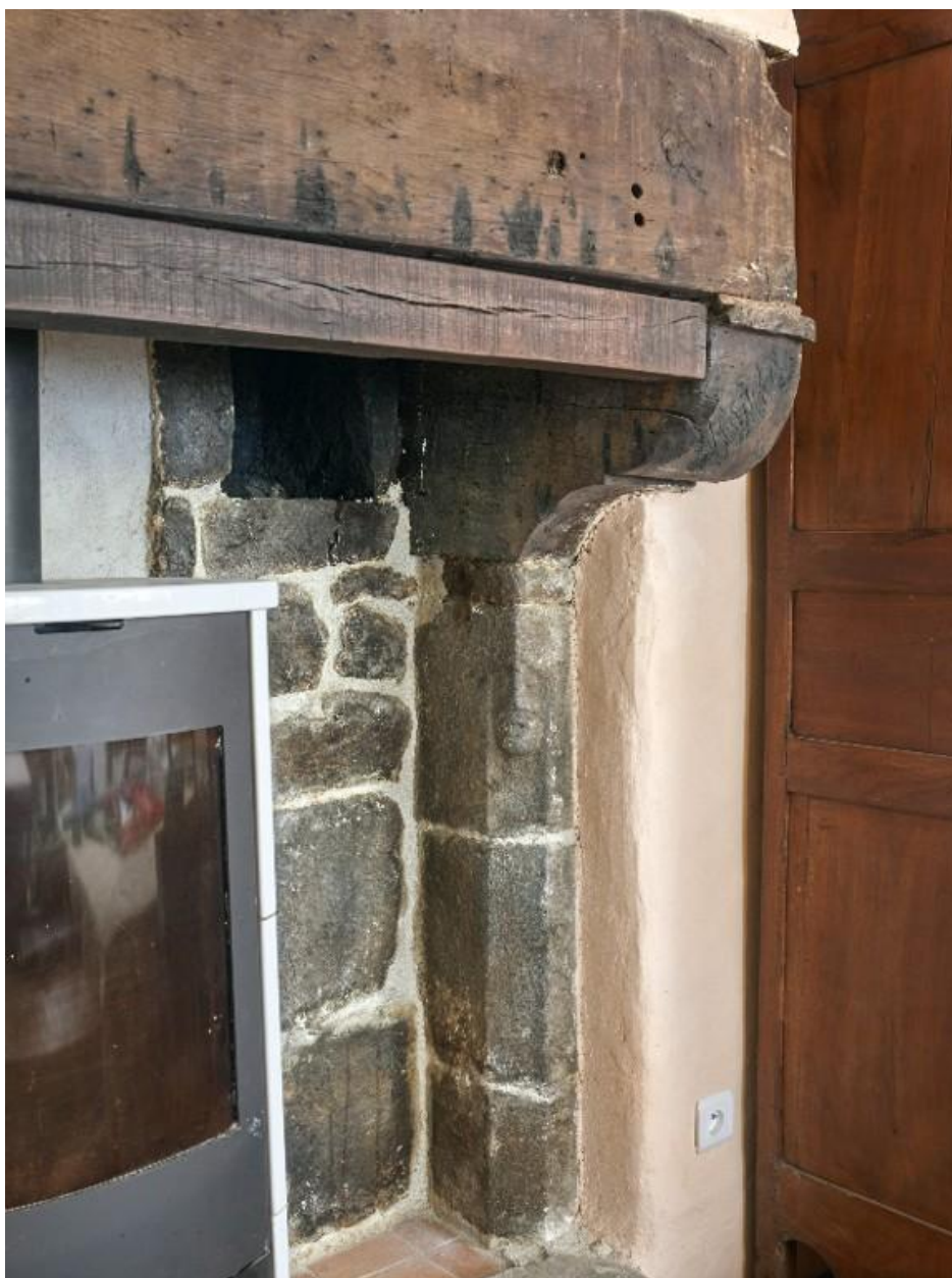
Salle ouest. Cheminée sur le pignon ouest. Détail d'un jambage chanfreiné et orné d'un visage dans sa partie haute
