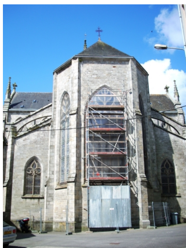
Quimper, église Saint-Mathieu : élévation est Phot. Gwénaél Fauchille IVR53_20082906416NUCA
