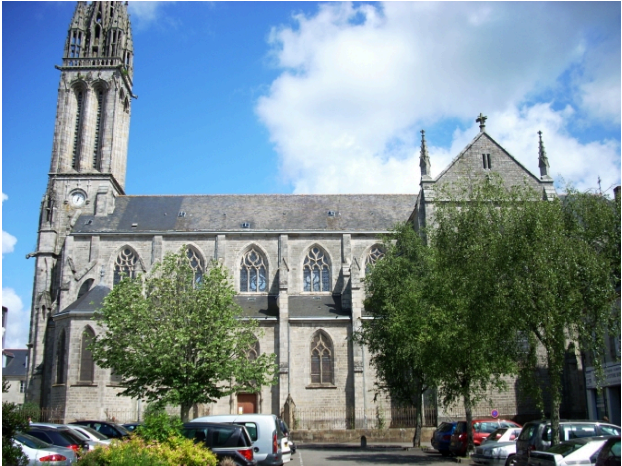
Quimper, église Saint-Mathieu : élévation sud
