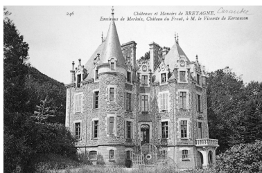
Vue générale Phot. Elise Lauranceau IVR53_20042905525NUCB
