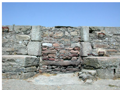
Vue de l'emplacement de l'embrasure bouchée (état en 2002) Phot. Guillaume Lécueillier IVR53_20022901904NUCA
