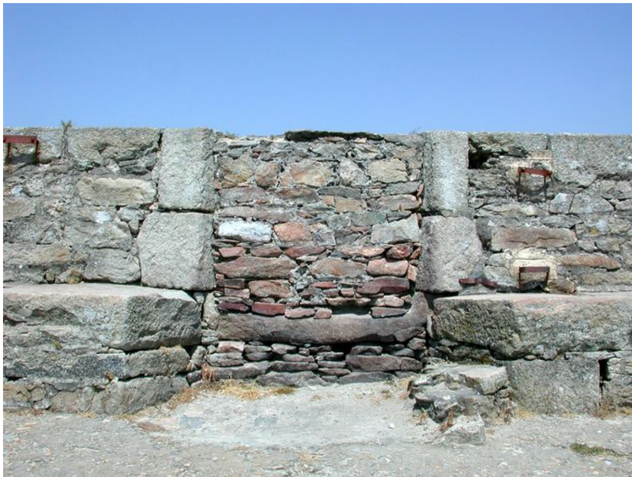
Vue de l'emplacement de l'embrasure bouchée (état en 2002)
