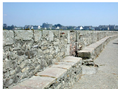
Vue de l'emplacement de l'embrasure bouchée (état en 2002) Phot. Guillaume Lécueillier IVR53_20022901907NUCA
