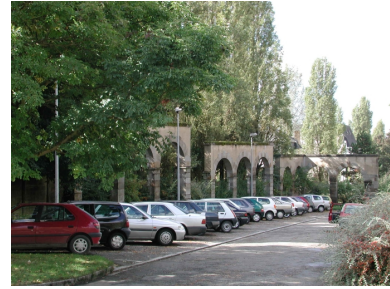
Arcades remontées dans la zup de Maurepas Phot. Isabelle Barbedor IVR53_20023515618NUCA
