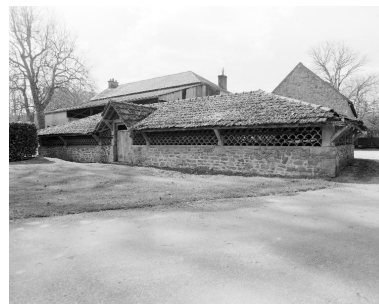
Vue générale du séchoir. Phot. Bernard Bègne IVR53_19995600386X
