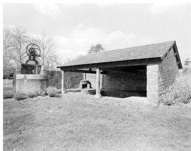
Lavoir, vue générale. Phot. Bernard Bègne IVR53_19995600387X
