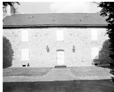
Dépendance, élévation sud. Phot. Bernard Bègne IVR53_19995600388X
