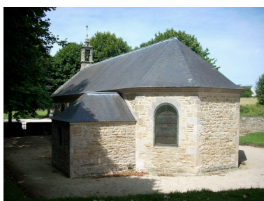
Plougoum, chapelle de Notre-Dame de Prat-Coum : vue générale sud-est Phot. Gwénaél Fauchille IVR53_20082906561NUCA
