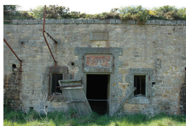
Vue d'une traverse-abri datée de 1883-1884 (état en 2005) Phot. Guillaume Lécueillier IVR53_20052903702NUCA
