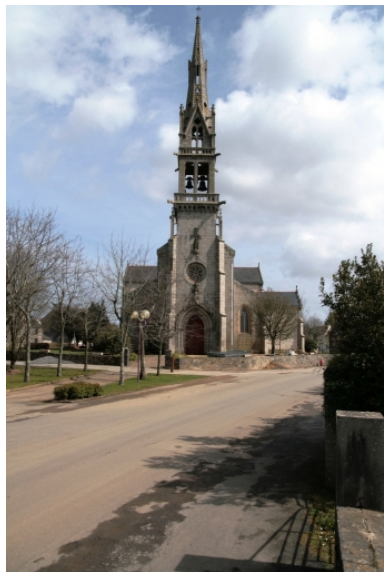
Hanvec, église paroissiale Saint-Pierre : élévation ouest Phot. Gwénaél Fauchille IVR53_20082905727NUCA
