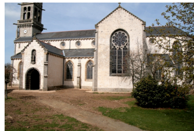
Hanvec, église paroissiale Saint-Pierre : vue générale sud Phot. Gwénaél Fauchille IVR53_20082905729NUCA
