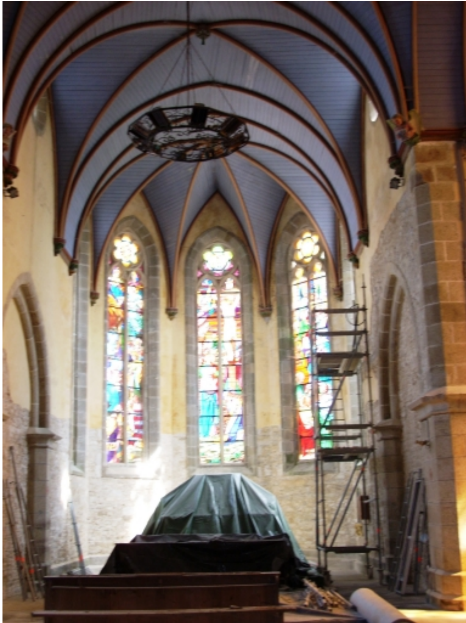
Hanvec, église paroissiale Saint-Pierre : détail, vue du chœur
