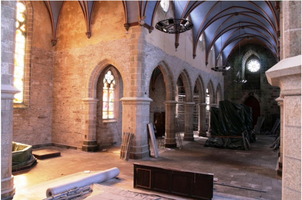
Hanvec, église paroissiale Saint-Pierre : vue transversale sud-ouest
