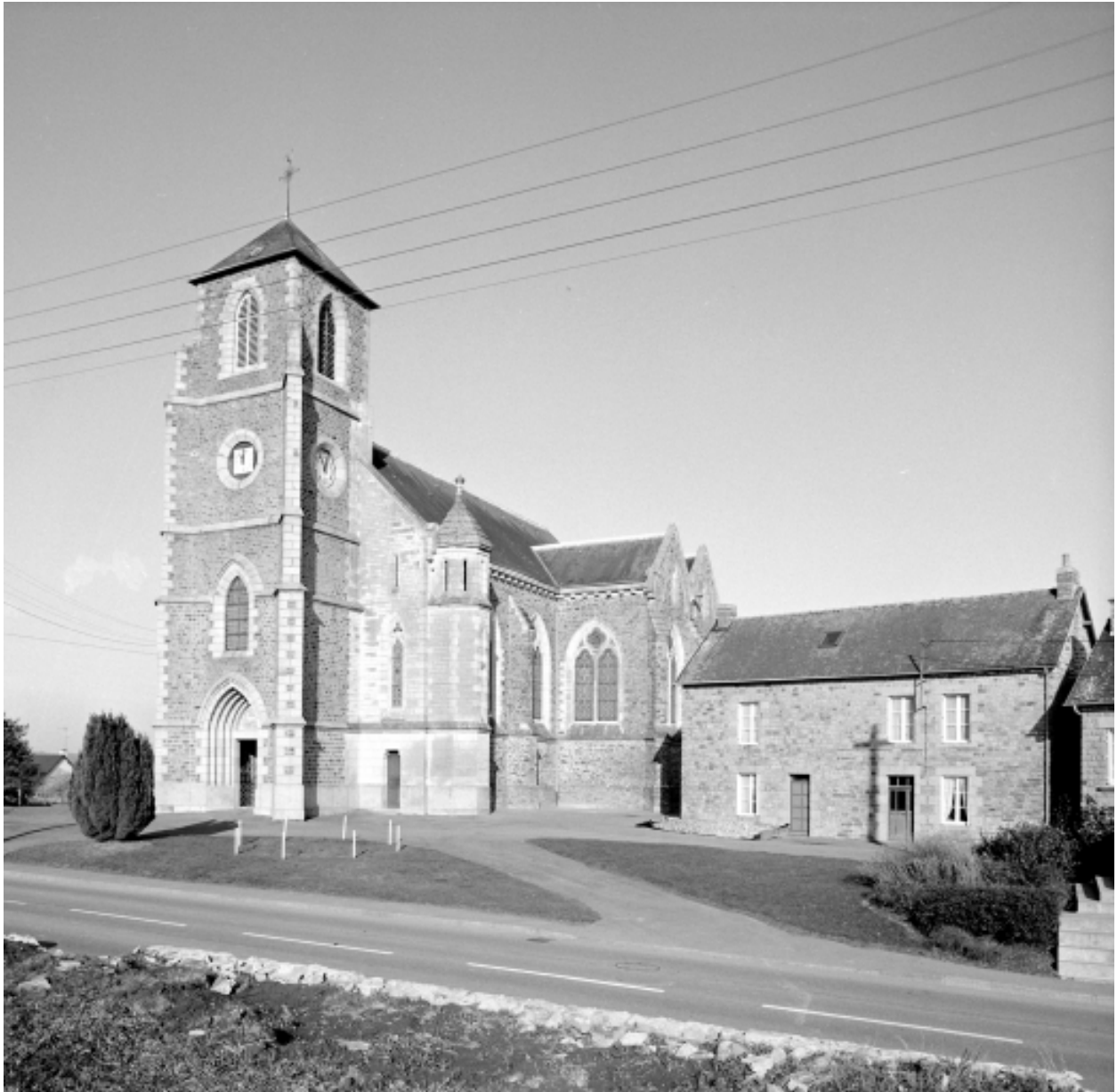
Elévation Sud-Ouest : vue générale
