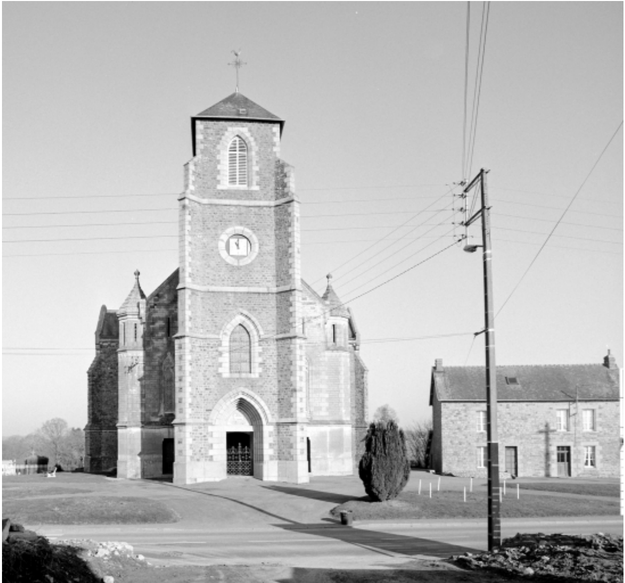
Elévation Ouest : vue générale
