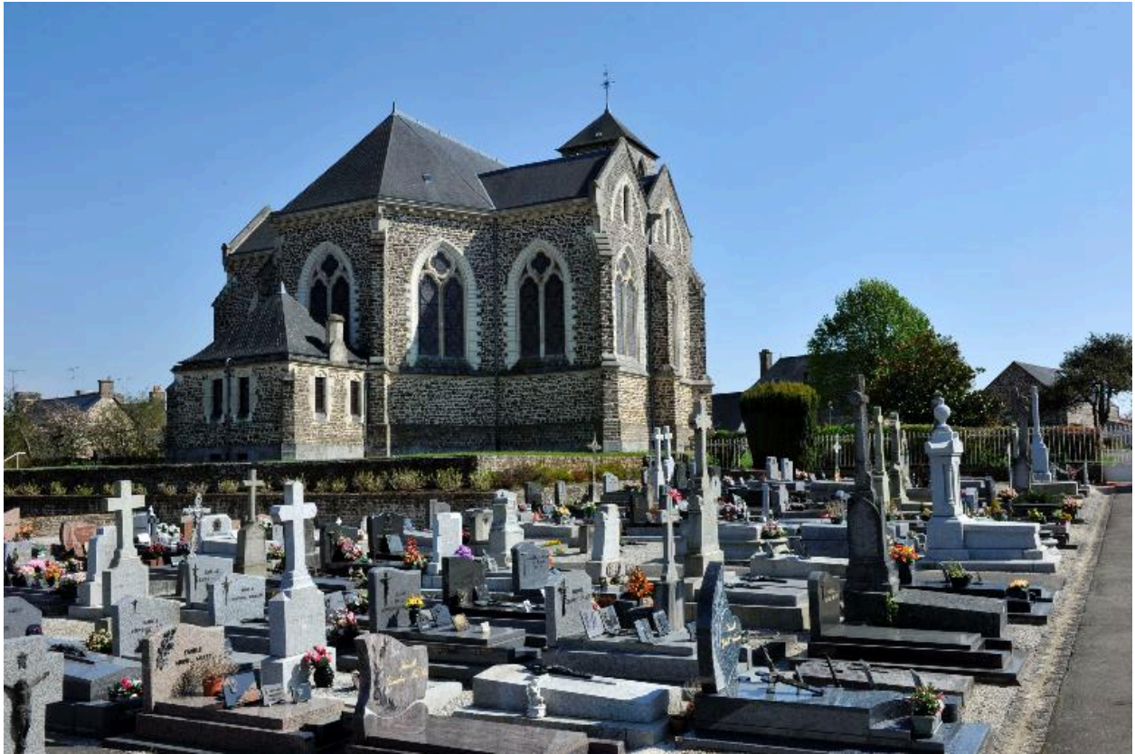
Vue générale : côté Nord-Ouest
