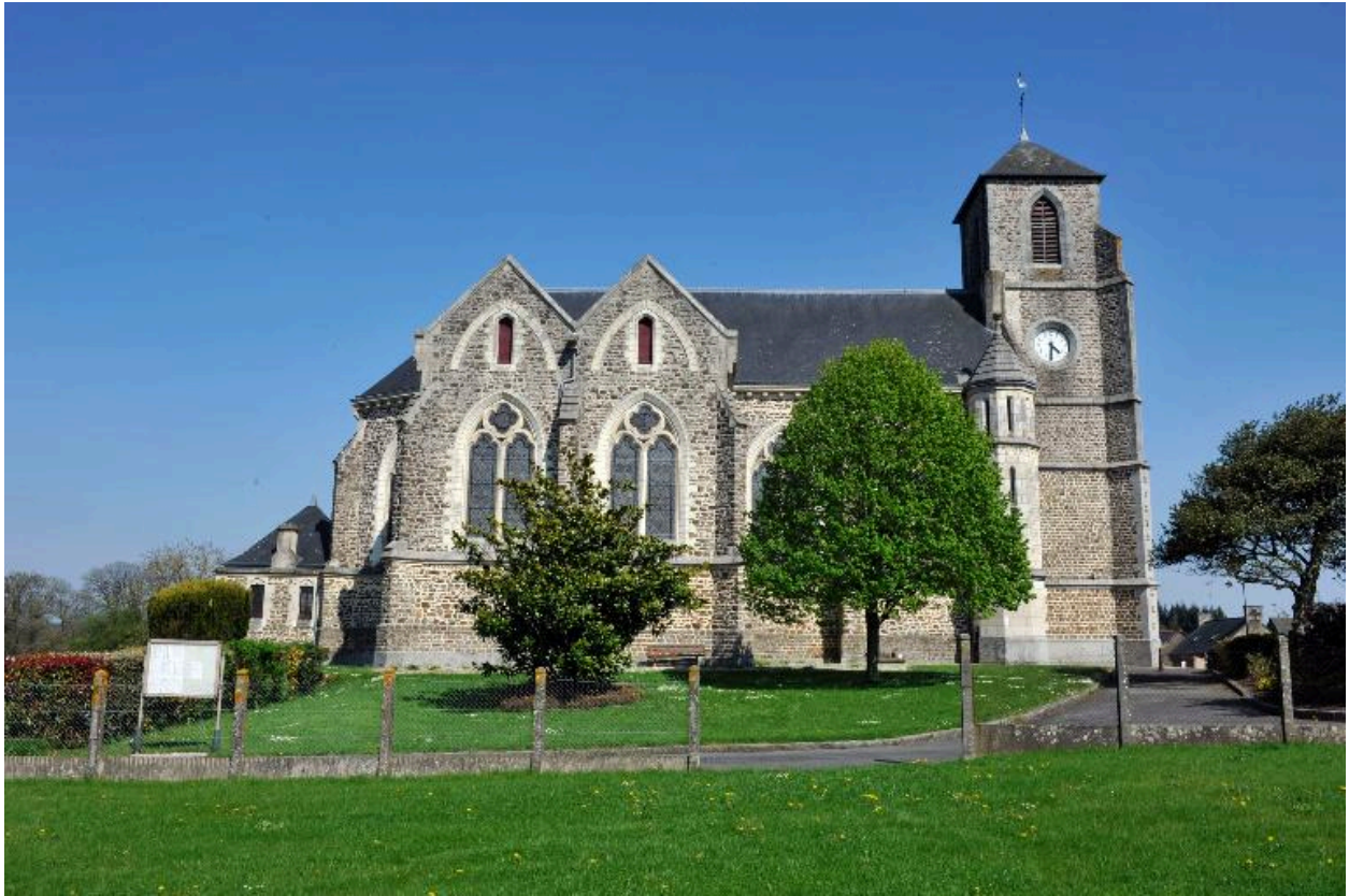
Vue générale : côté Ouest
