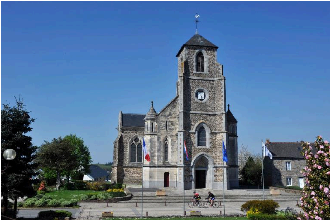
Vue générale : côté Sud
