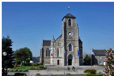
Vue générale : côté Sud Phot. Véronique Samson IVR53_20133500961NUCA
