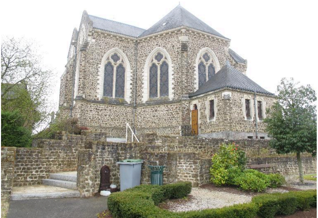
Vue générale : côté Nord-Est
