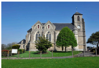
Vue générale : côté Ouest Phot. Véronique Samson IVR53_20133500962NUCA
