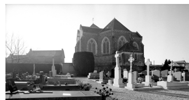
Elévation Sud-Est : vue générale Phot. Bernard Bègne, Phot. A. Boden IVR53_19933500599X
