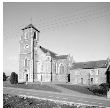
Elévation Sud-Ouest : vue générale Phot. Guy Artur, Phot. Norbert Lambart IVR53_19933500600X
