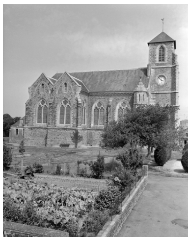
Elévation Nord : vue générale Phot. Guy Artur, Phot. Norbert Lambart IVR53_19943501467X
