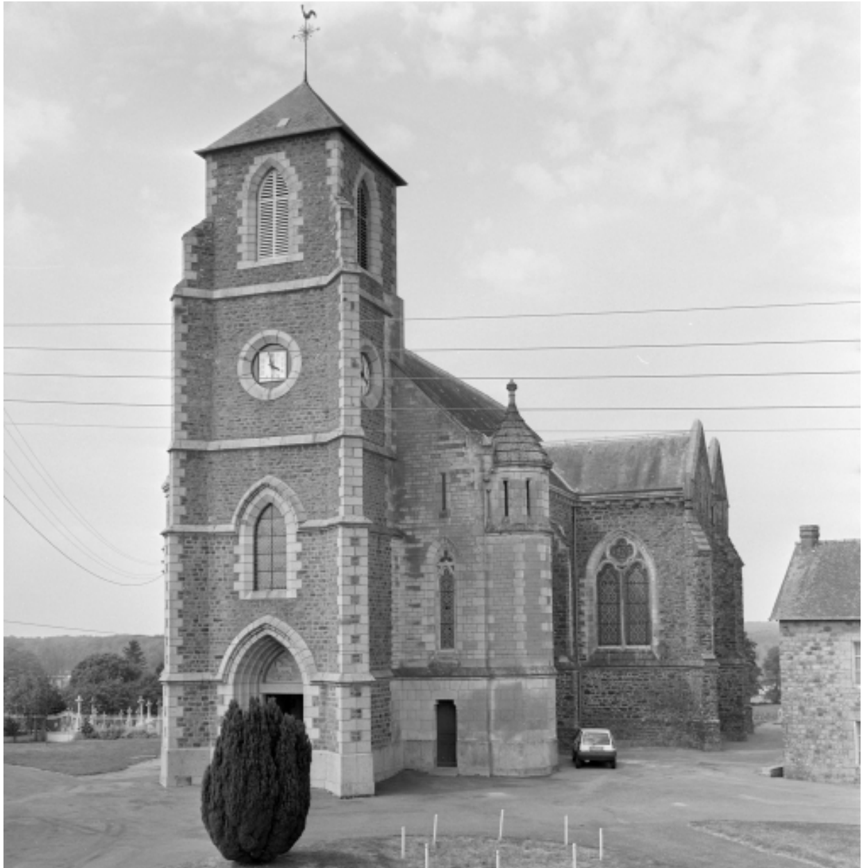
Elévation Sud-Ouest : vue générale
