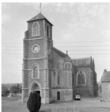
Elévation Sud-Ouest : vue générale Phot. Guy Artur, Phot. Norbert Lambart IVR53_19943501468X
