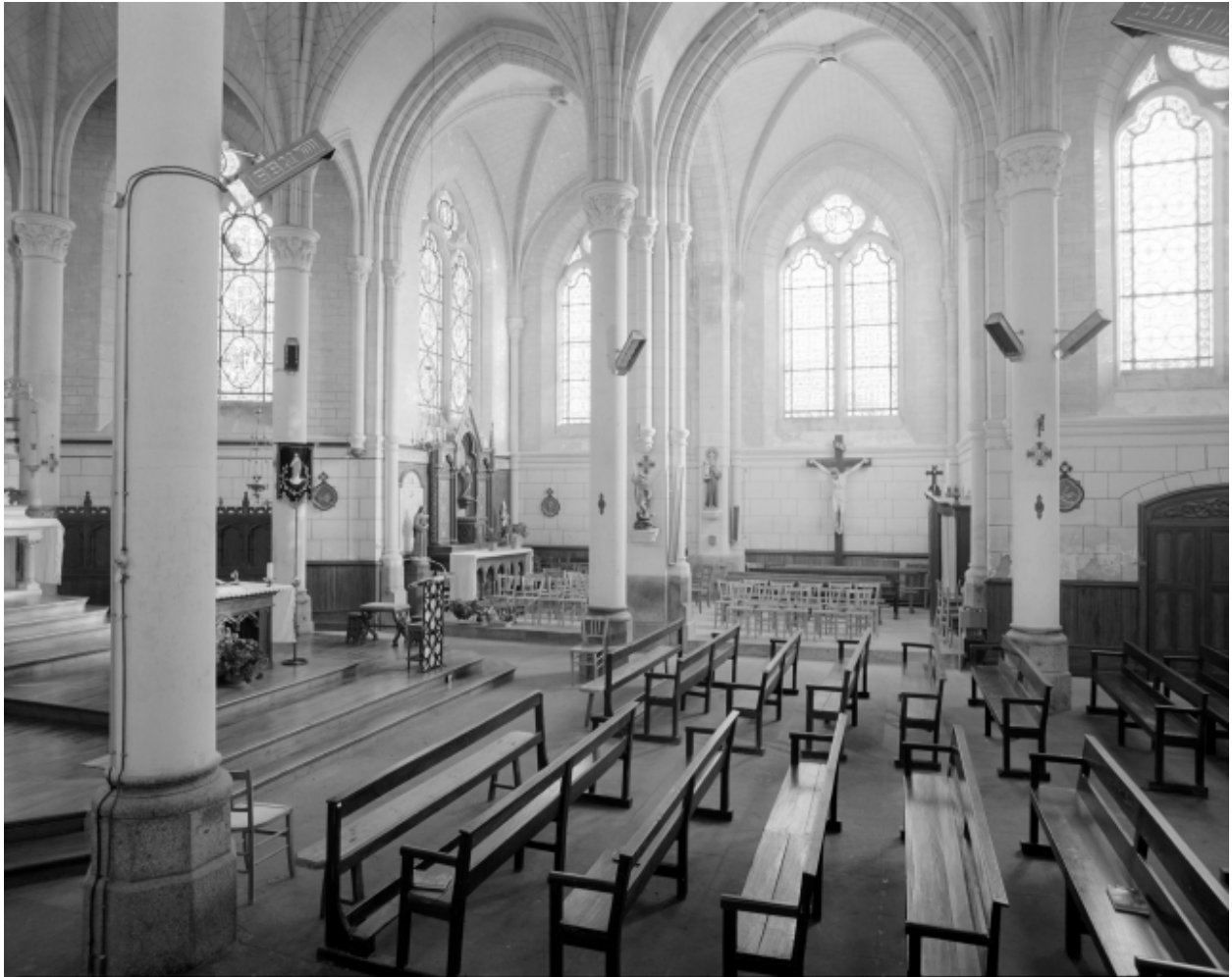
Intérieur, bras Sud du transept : vue générale.
