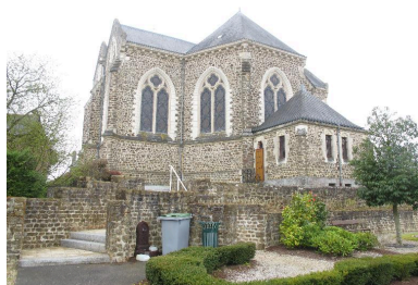
Vue générale : côté Nord-Est Phot. Frédéric Déan IVR53_20133520484NUCA
