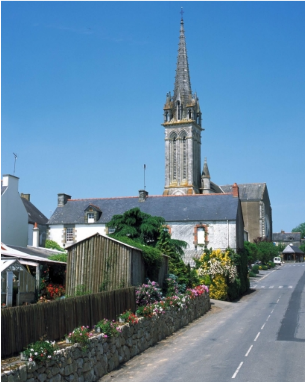
Vue de situation sud
