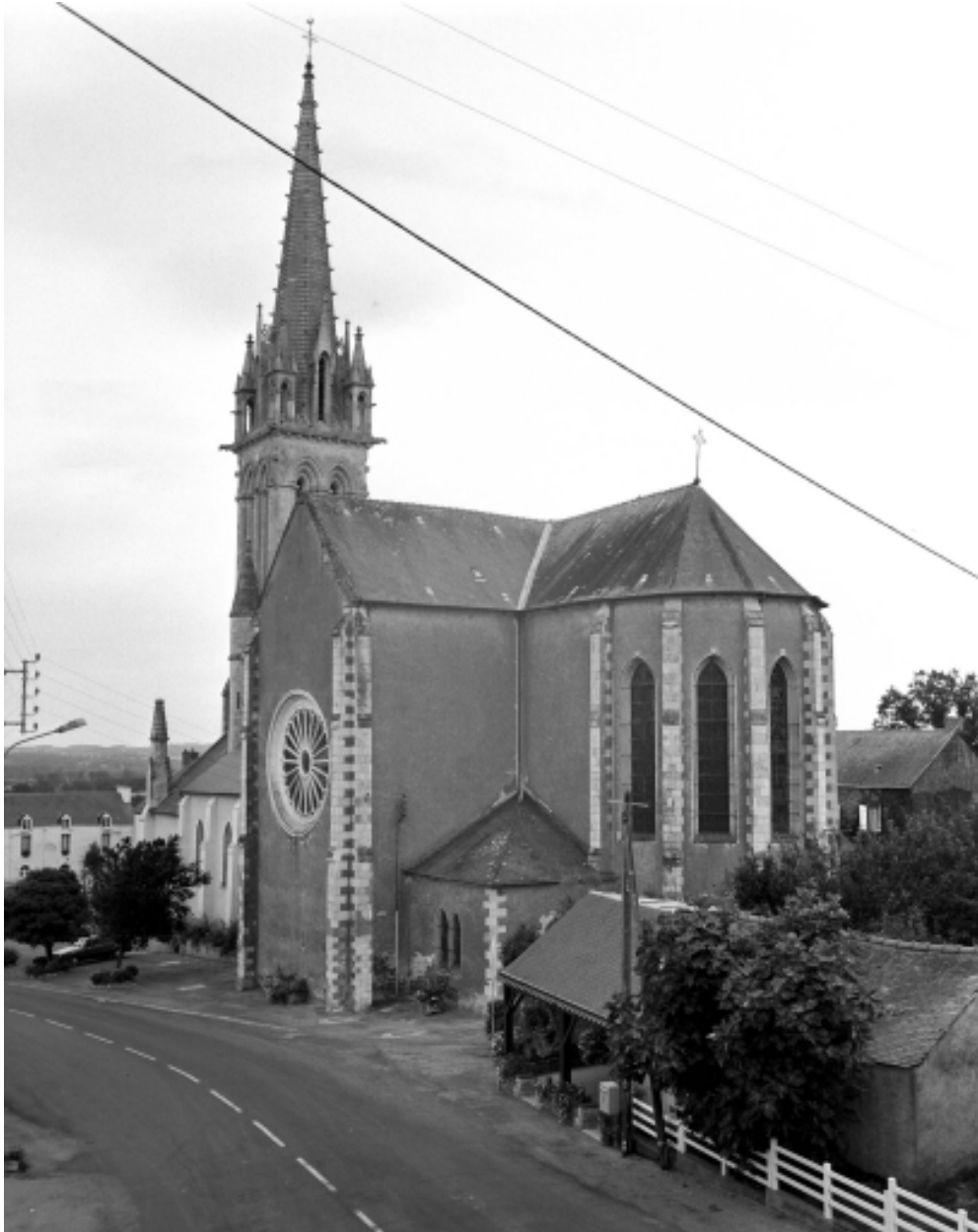
Vue générale nord est
