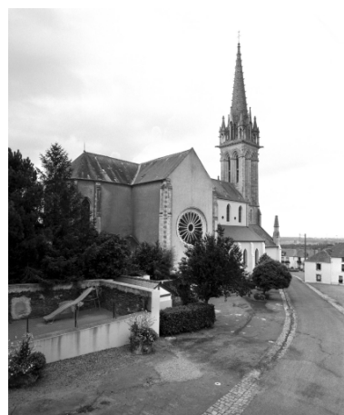
Vue générale ouest Phot. Guy Artur, Phot. Norbert Lambart IVR53_19943501734X
