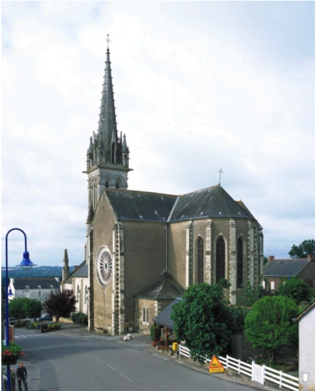
Vue générale nord est
