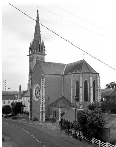
Vue générale nord est Phot. Guy Artur, Phot. Norbert Lambart IVR53_19943501736X
