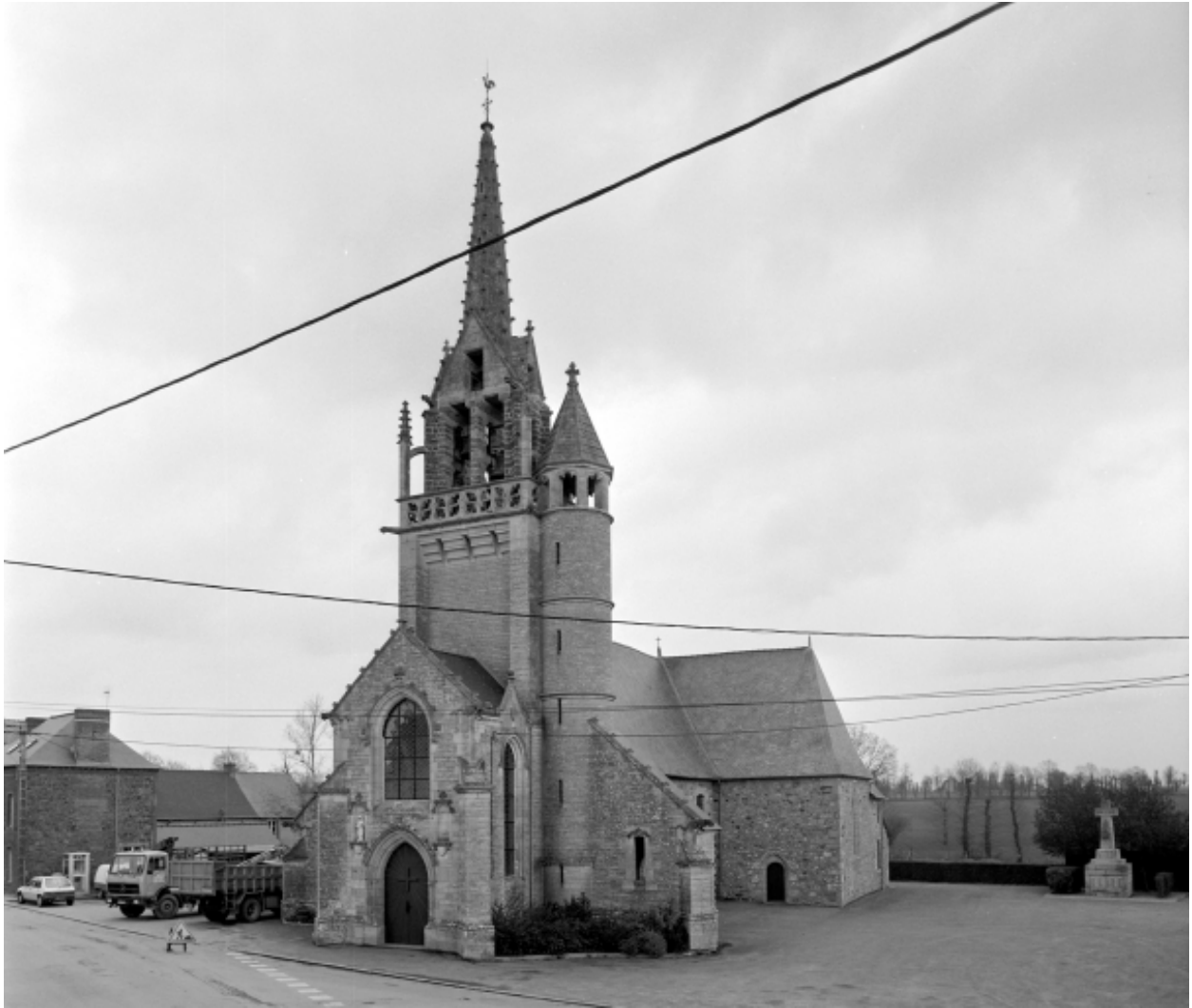
Elévation Ouest : vue générale
