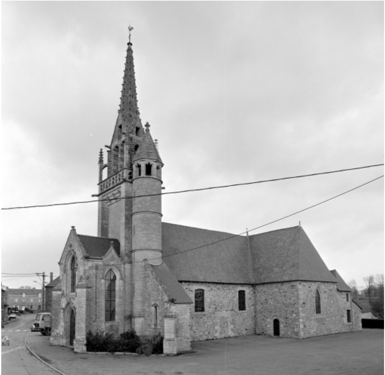
Elévation Sud-Ouest : vue générale
