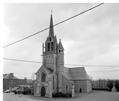
Elévation Ouest : vue générale Phot. Guy Artur, Phot. Norbert Lambart IVR53_19943500696X
