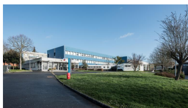
Vue d'ensemble : accueil, administration, externat, et, à l'arrière plan, à gauche, logements (Albert Hec et Roger Besnard, architectes, 1966). A droite, CDI (Bernard Kaleski, architecte, 1992). Phot. Delia Gaulin-Crespel IVR53_20203500317NUCA
