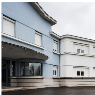
Bâtiment C, actuellement externat : détail sur l'entrée principale et son auvent en béton et pavés de verre ronds. Phot. Delia Gaulin-Crespel IVR53_20193501554NUCA
