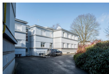
Bâtiment C, aile sud, façade arrière (ouest) : extension (Albert Hec et Roger Besnard, architectes, 1966). Phot. Delia Gaulin-Crespel IVR53_20203500322NUCA
