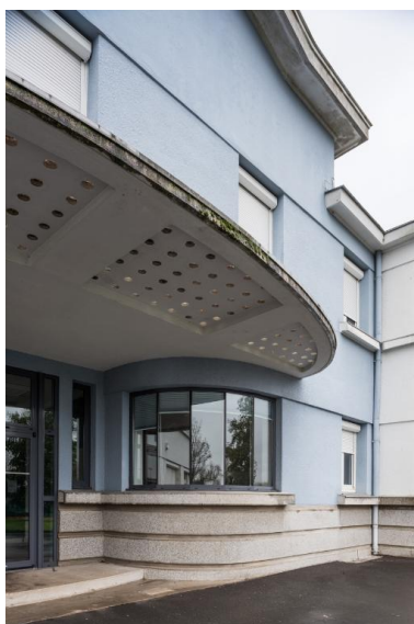
Bâtiment C, actuellement externat : détail sur l'entrée principale et le auvent (béton et pavés de verre ronds). Phot. Delia Gaulin-Crespel IVR53_20193501555NUCA
