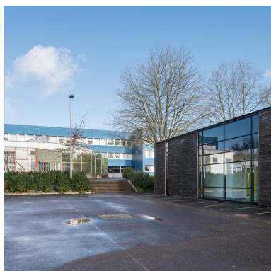
Vue d'ensemble : externat et, à droite, gymnase (Albert Hec et Roger Besnard, architectes, 1966). A gauche, CDI (Bernard Kaleski, architecte, 1992). Phot. Delia Gaulin-Crespel IVR53_20203500320NUCA
