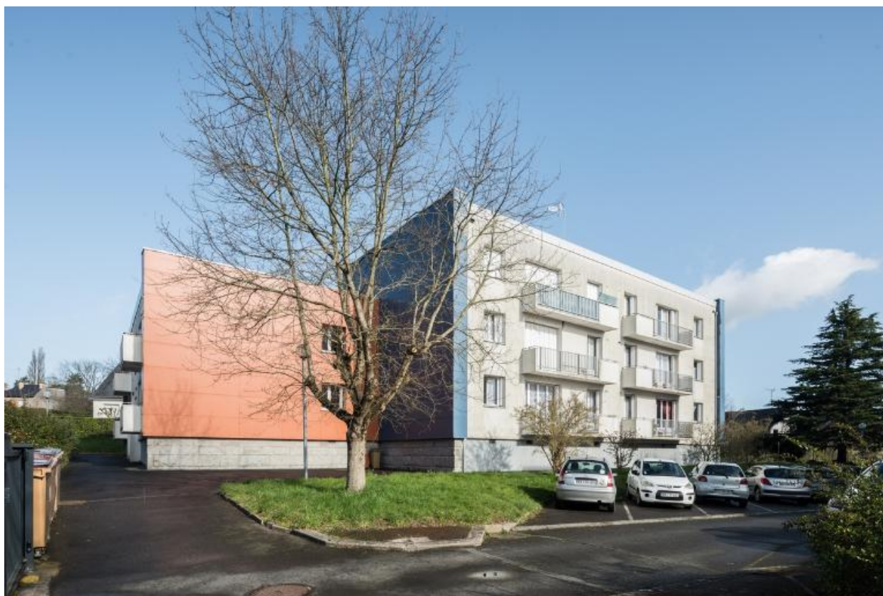
Vue d'ensemble des logements, prise du sud (Albert Hec et Roger Besnard, architectes, 1966).
