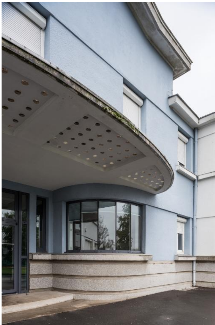
Bâtiment C, actuellement externat : détail sur l'entrée principale et le auvent (béton et pavés de verre ronds).
