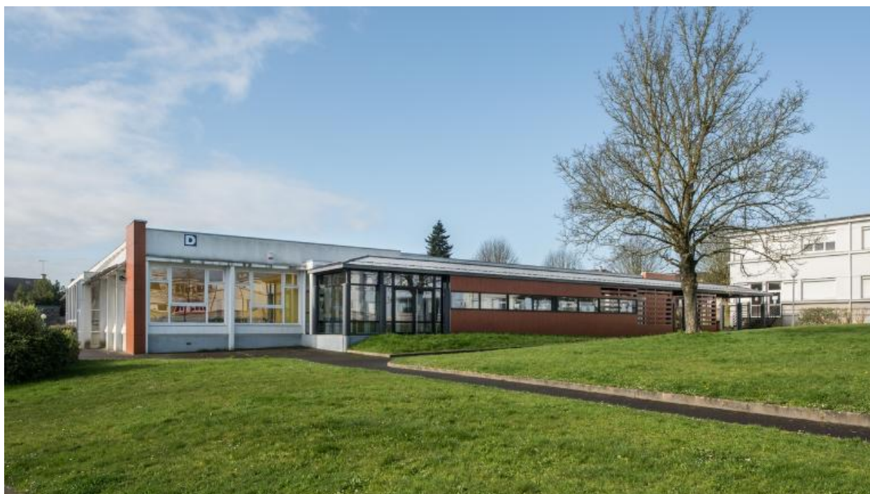
Bâtiment D, restauration scolaire, vue d'ensemble prise du nord-est (Albert Hec et Roger Besnard, architectes, 1966).
