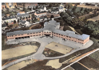
Vue aérienne oblique du collège municipal (entre 1947 et 1966) : carte postale colorisée. Le préau a, depuis, été transformé en salles de classe. L'escalier devant l'entrée principale et les rampes d'accès ont disparu. Le décor en plâtre figurant la ville de Fougères accueillant ses vieillards a d'ores et déjà été déposé.
