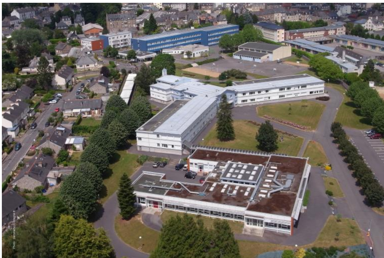
Vue aérienne oblique (2010)
