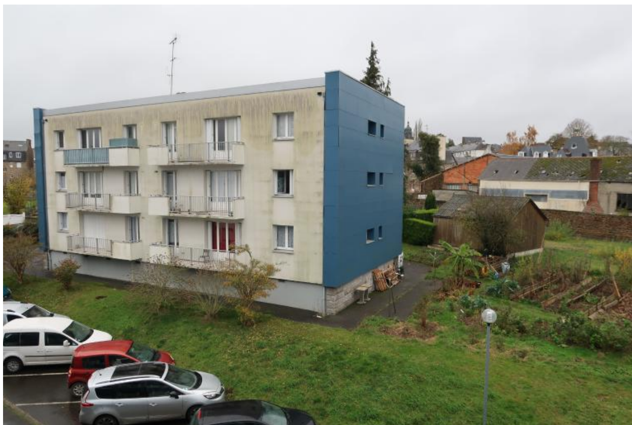
Les logements, angle sud est (Albert Hec et Roger Besnard, architectes, 1966).
