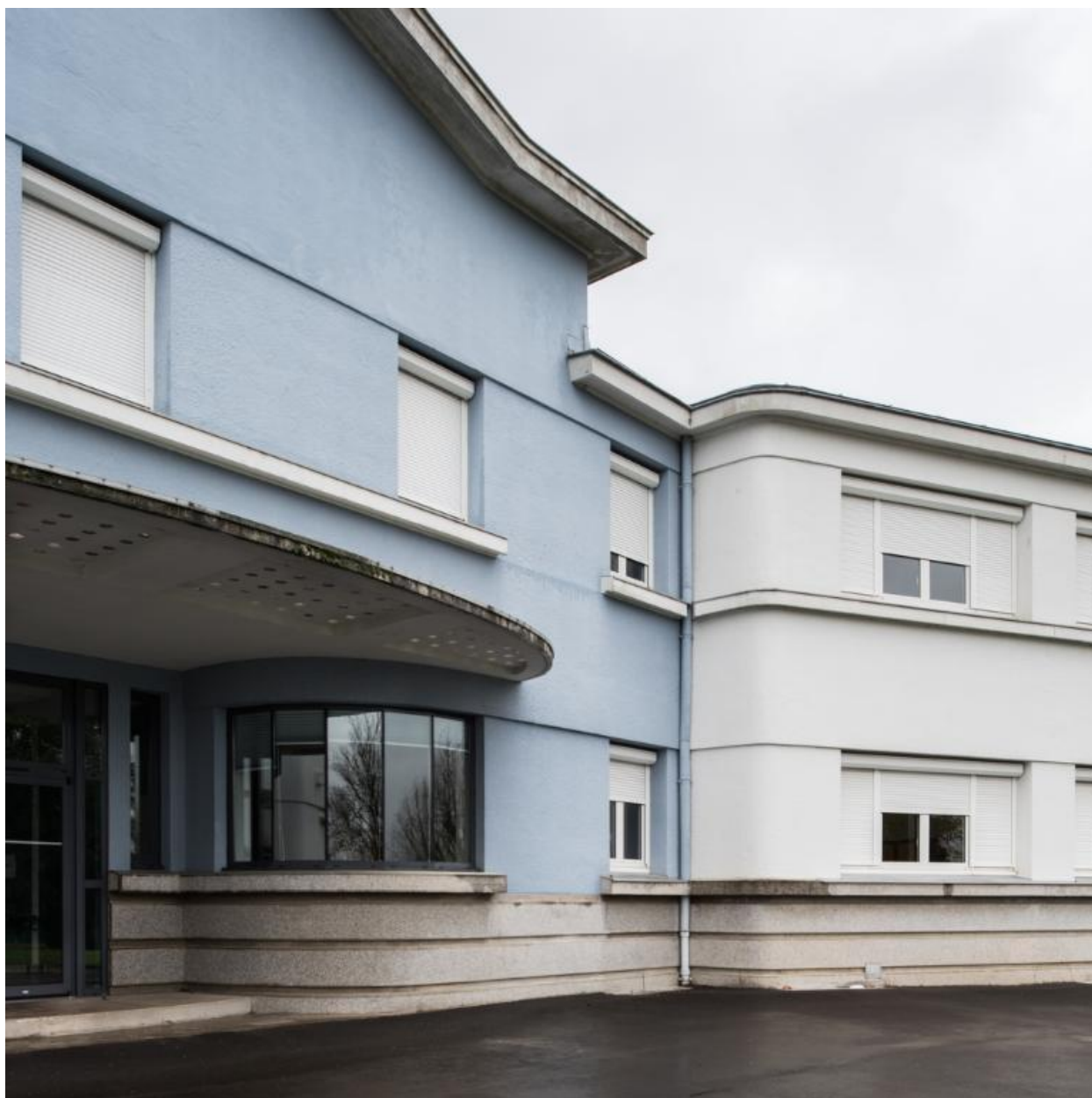
Bâtiment C, actuellement externat : détail sur l'entrée principale et son auvent en béton et pavés de verre ronds.
