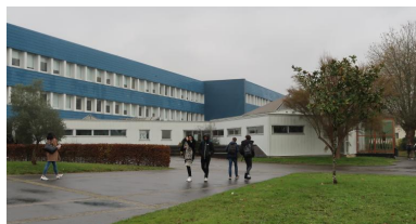
CDI, vue prise depuis l'ouest (Bernard Kaleski, architecte, 1992). A l'arrière plan, externat (Albert Hec et Roger Besnard, architectes, 1966). Phot. Thierry Goyet IVR53_20203505046NUCA
