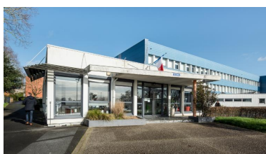
Accueil, administration, externat. Albert Hec et Roger Besnard, architectes, 1966. Noter, dans un univers de barres et de cubes, le traitement du auvent. Phot. Delia Gaulin-Crespel IVR53_20203500315NUCA
