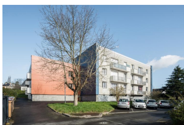
Vue d'ensemble des logements, prise du sud (Albert Hec et Roger Besnard, architectes, 1966). Phot. Delia Gaulin-Crespel IVR53_20203500329NUCA
