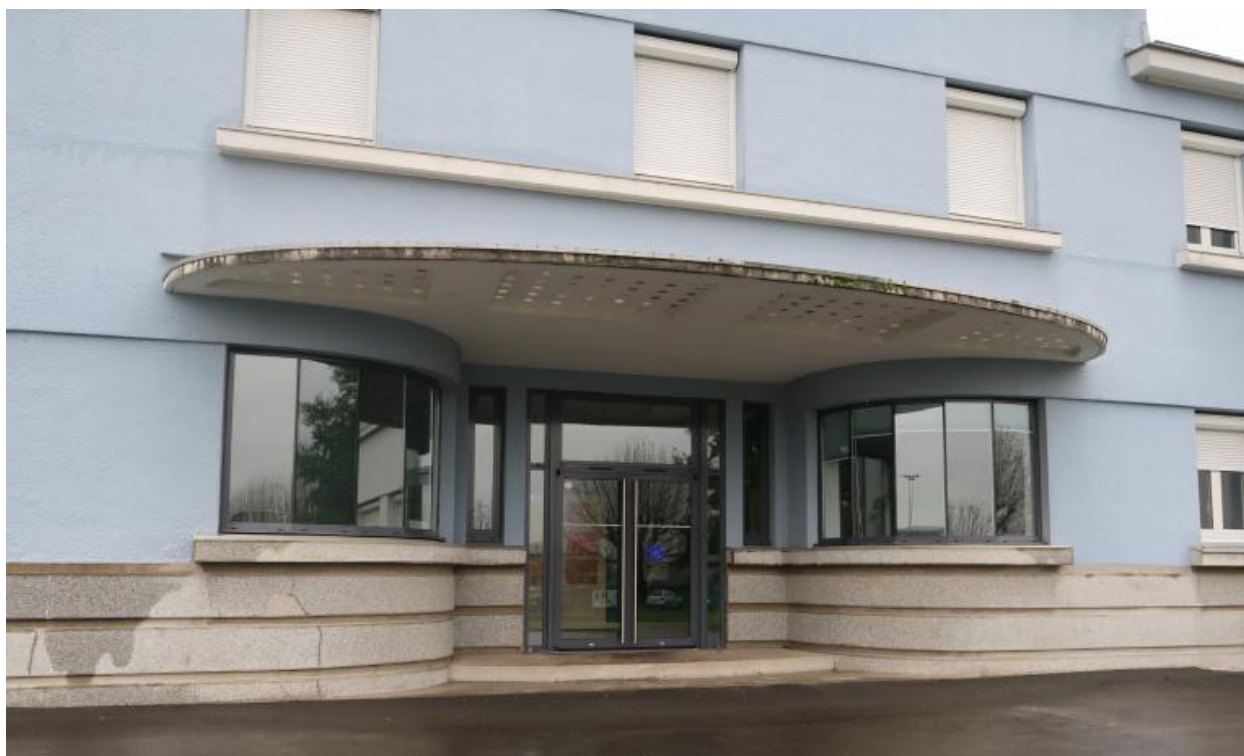
Bâtiment C, actuellement externat : détail sur l'entrée principale et son auvent en béton et pavés de verre ronds.
