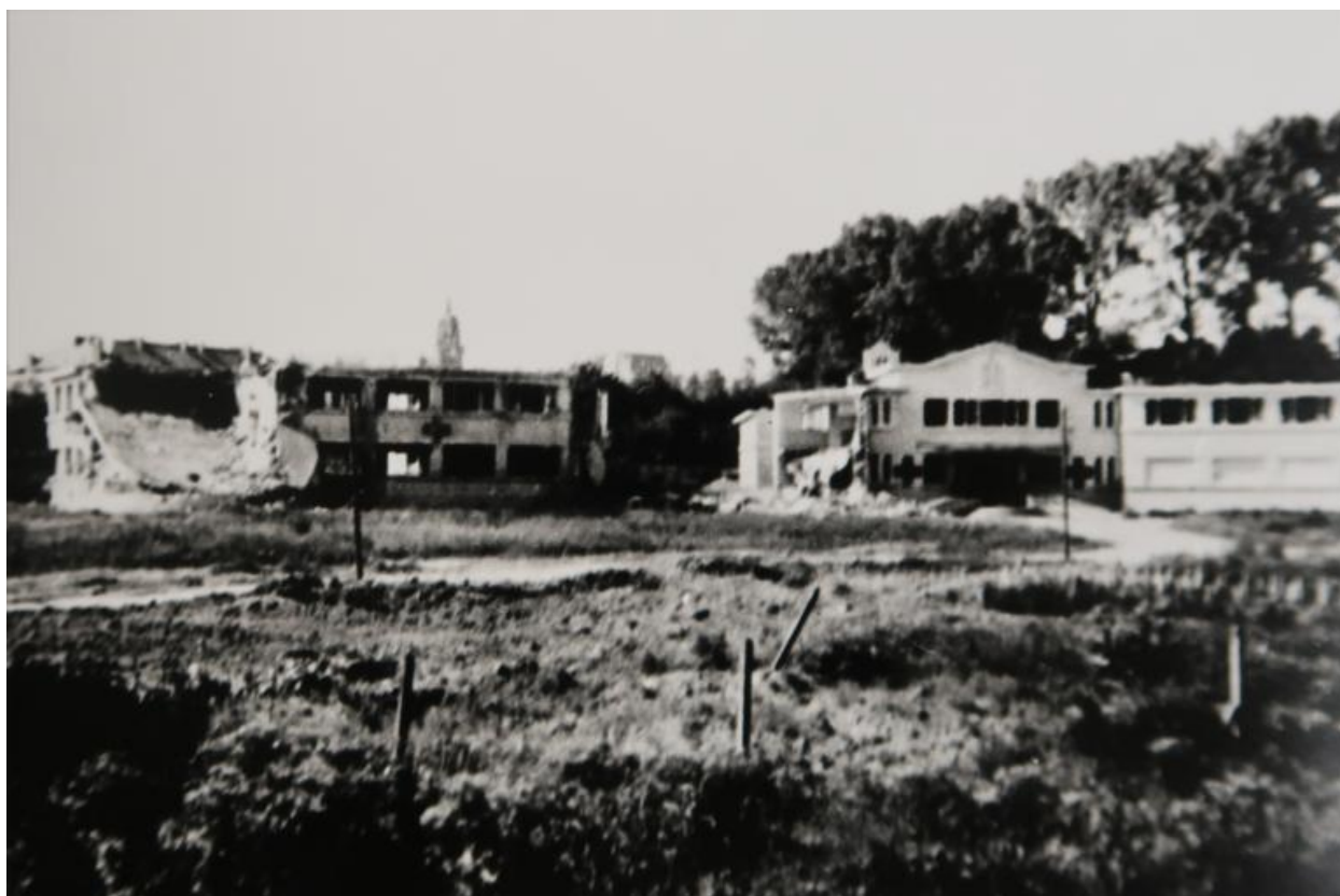
L'hospice de vieillards de la Chesnardière après les bombardements de juin 1944. On note la présence, au fronton de l'entrée, du haut-relief en plâtre. Il représentait la Ville de Fougères, accueillant les vieillards.
