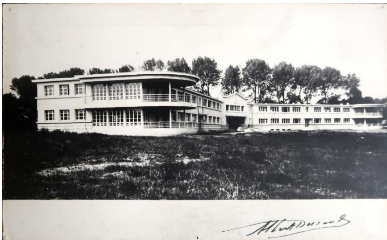
L'hospice de vieillards de la Chesnadière, peu après sa construction (vers 1939-1940), photographié par Albert Durand (1856-1943).
