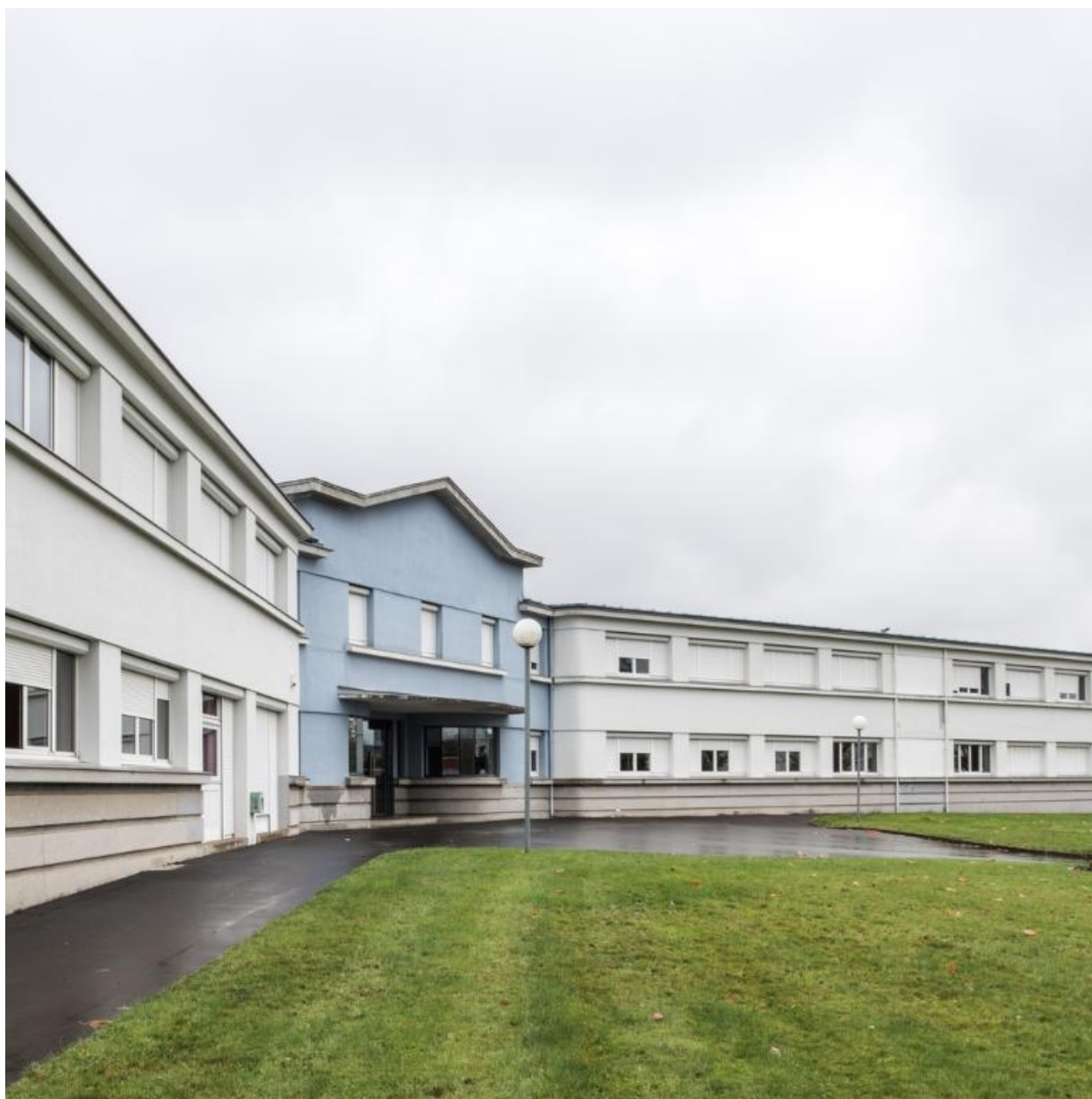
Bâtiment C, actuellement externat : anciens bâtiments de l'hospice civil de la Chesnadière, bombardé en 1944, reconstruit pour héberger le collège municipal puis une partie du lycée (Albert Hec architecte).
