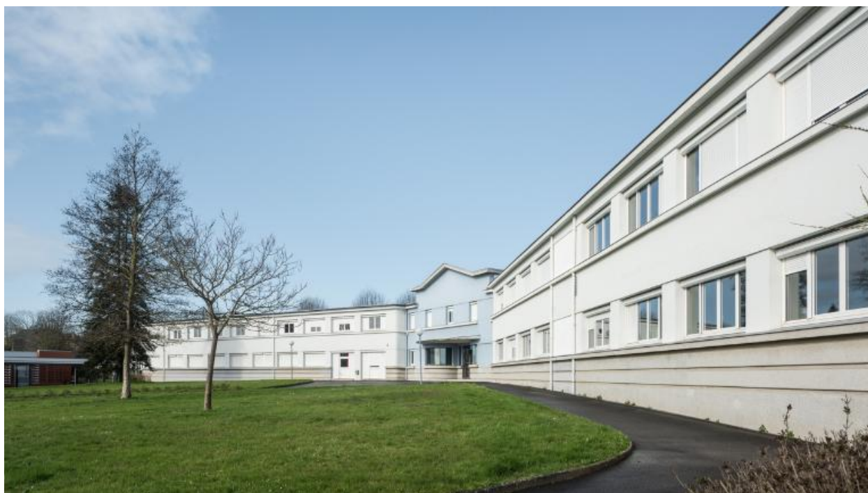
Bâtiment C, internat-externat, vue d'ensemble de la façade sud, prise de l'ouest (Albert Hec, architecte).
