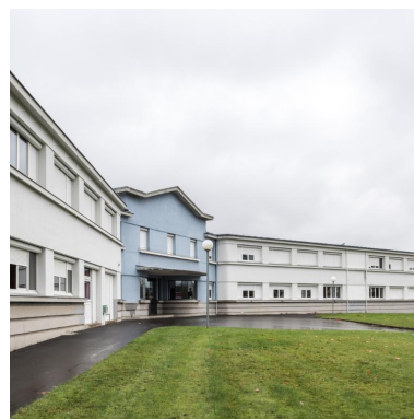
Bâtiment C, actuellement externat : anciens bâtiments de l'hospice civil de la Chesnadière, bombardé en 1944, reconstruit pour héberger le collège municipal puis une partie du lycée (Albert Hec architecte). Phot. Delia Gaulin-Crespel IVR53_20193501553NUCA
