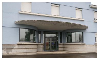
Bâtiment C, actuellement externat : détail sur l'entrée principale et son auvent en béton et pavés de verre ronds. Phot. Thierry Goyet IVR53_20203505044NUCA
