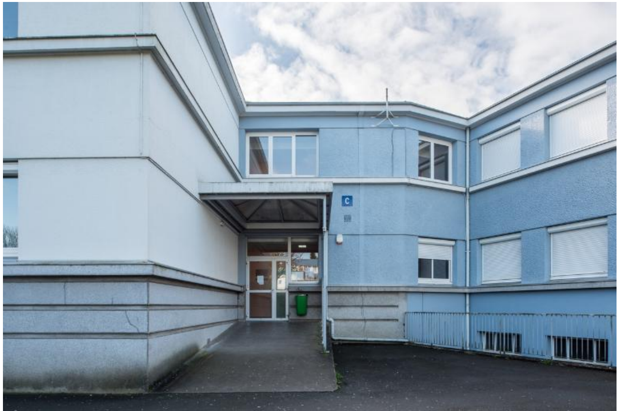
Bâtiment C, internat-externat, entrée secondaire.
