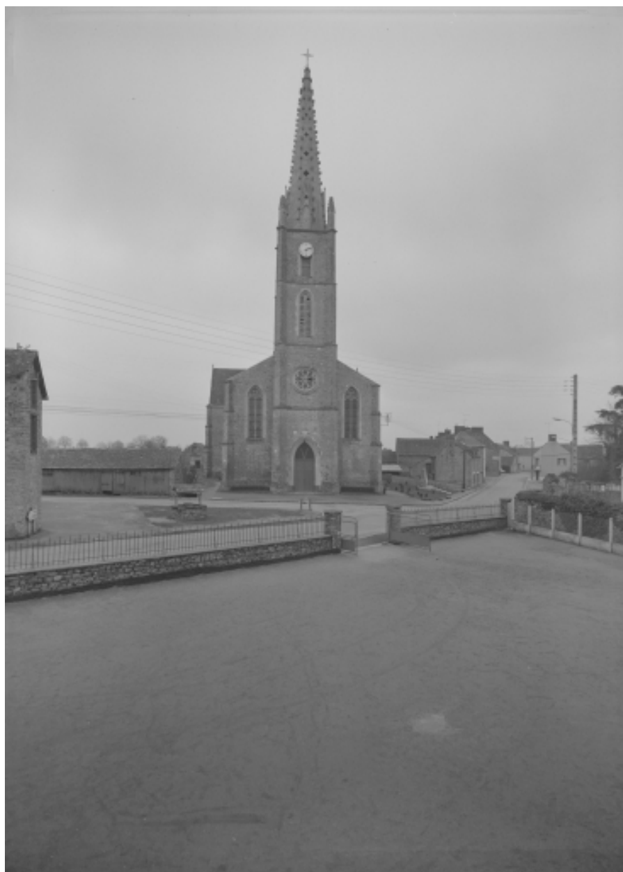
Elévation ouest : vue générale
