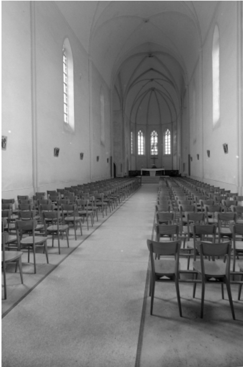
Intérieur : vue générale vers le chœur.
