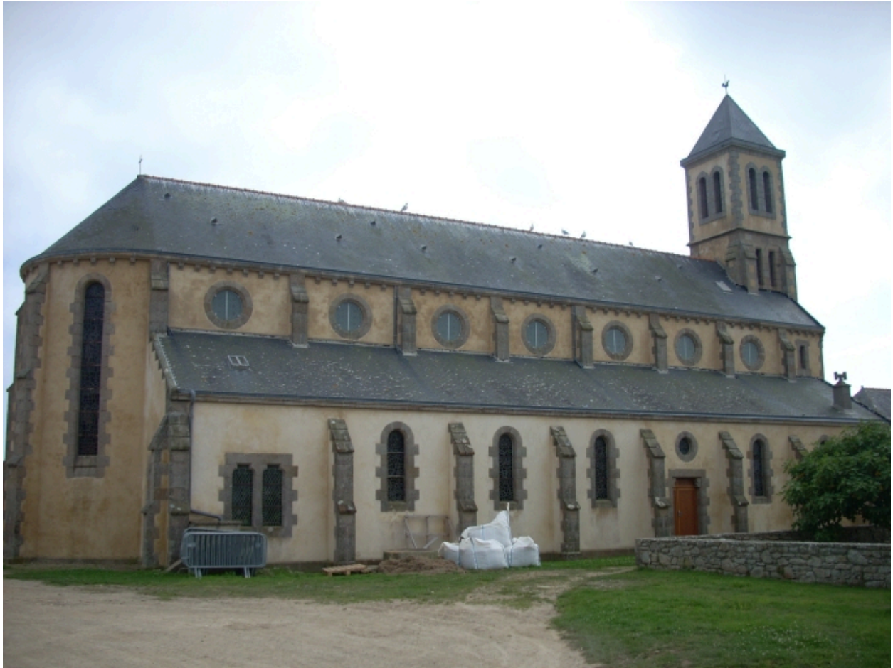
Ile-de-Sein, église paroissiale Saint-Guérolé : vue générale nord-est
