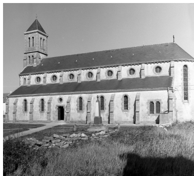
Ile-de-Sein, église paroissiale Saint-Guénoilé : vue générale sud-est, état en 1986 Phot. Norbert Lambart IVR53_19862900084X
