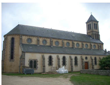
Ile-de-Sein, église paroissiale Saint-Guénoilé : vue générale nord-est Phot. Gwénaél Fauchille IVR53_20082906718NUCA
