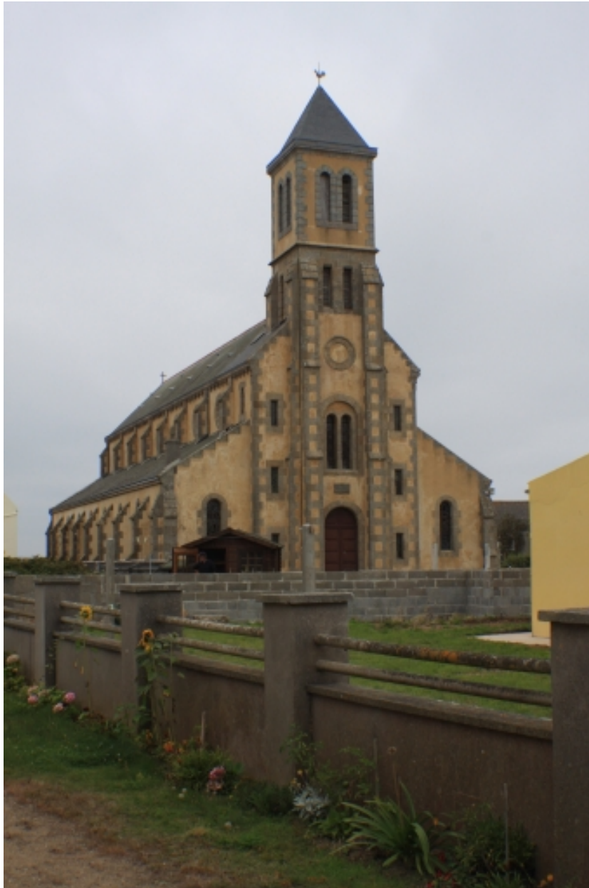
Ile-de-Sein, église paroissiale Saint-Guénoùlé : vue générale nord-ouest
