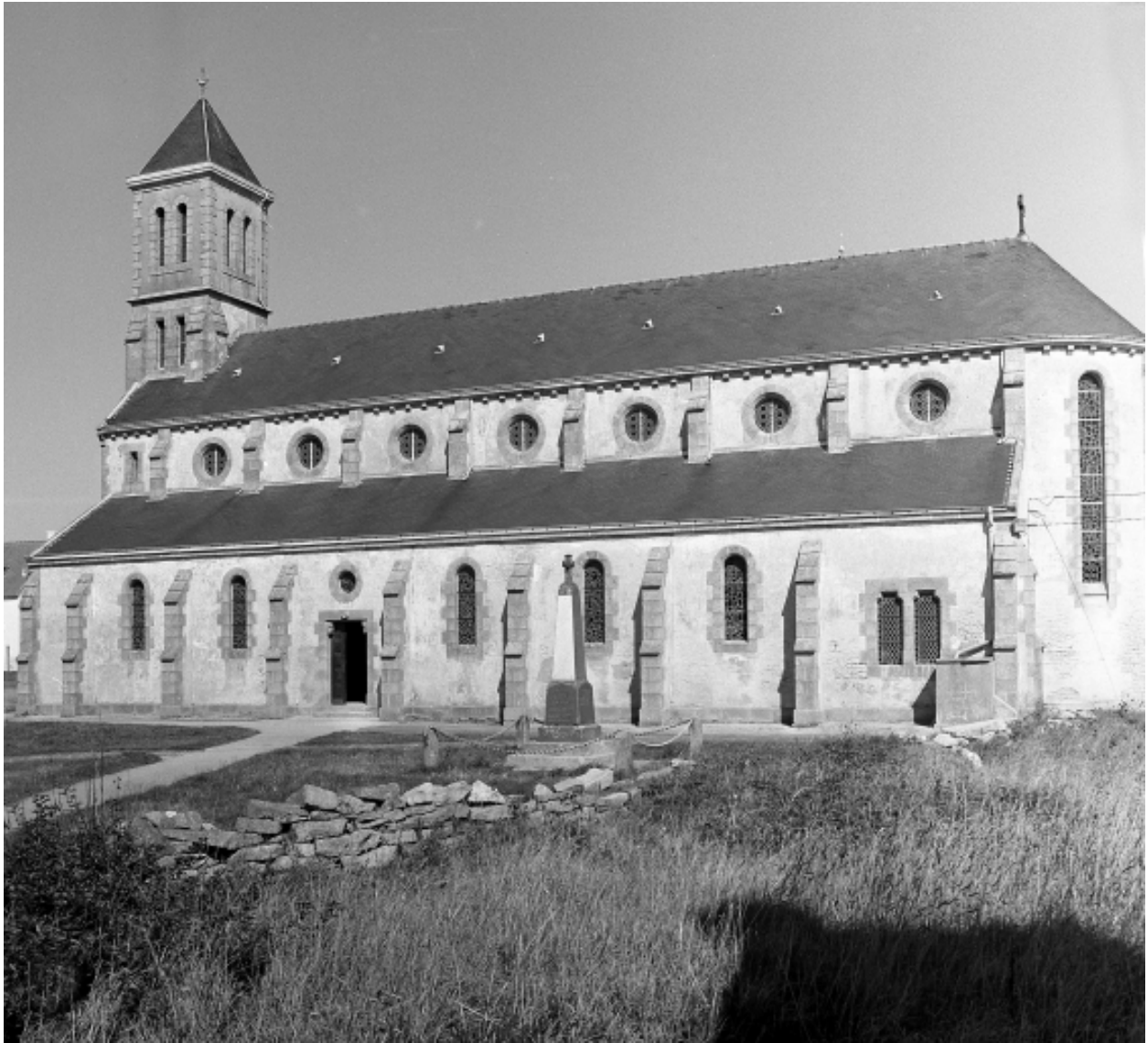
Ile-de-Sein, église paroissiale Saint-Guénoilé : vue générale sud-est, état en 1986
