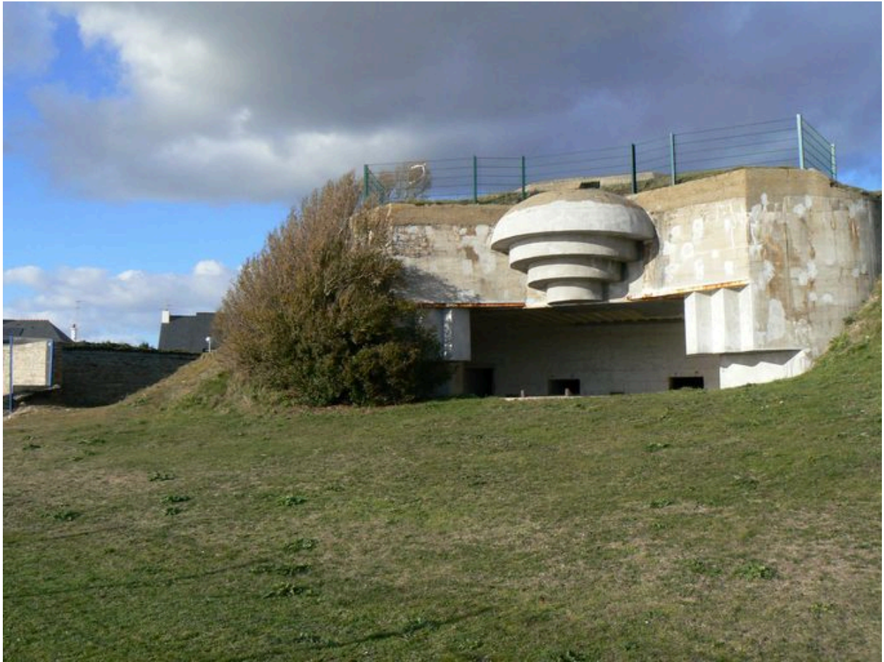
Casemate à proximité du fort de Locqueltas
