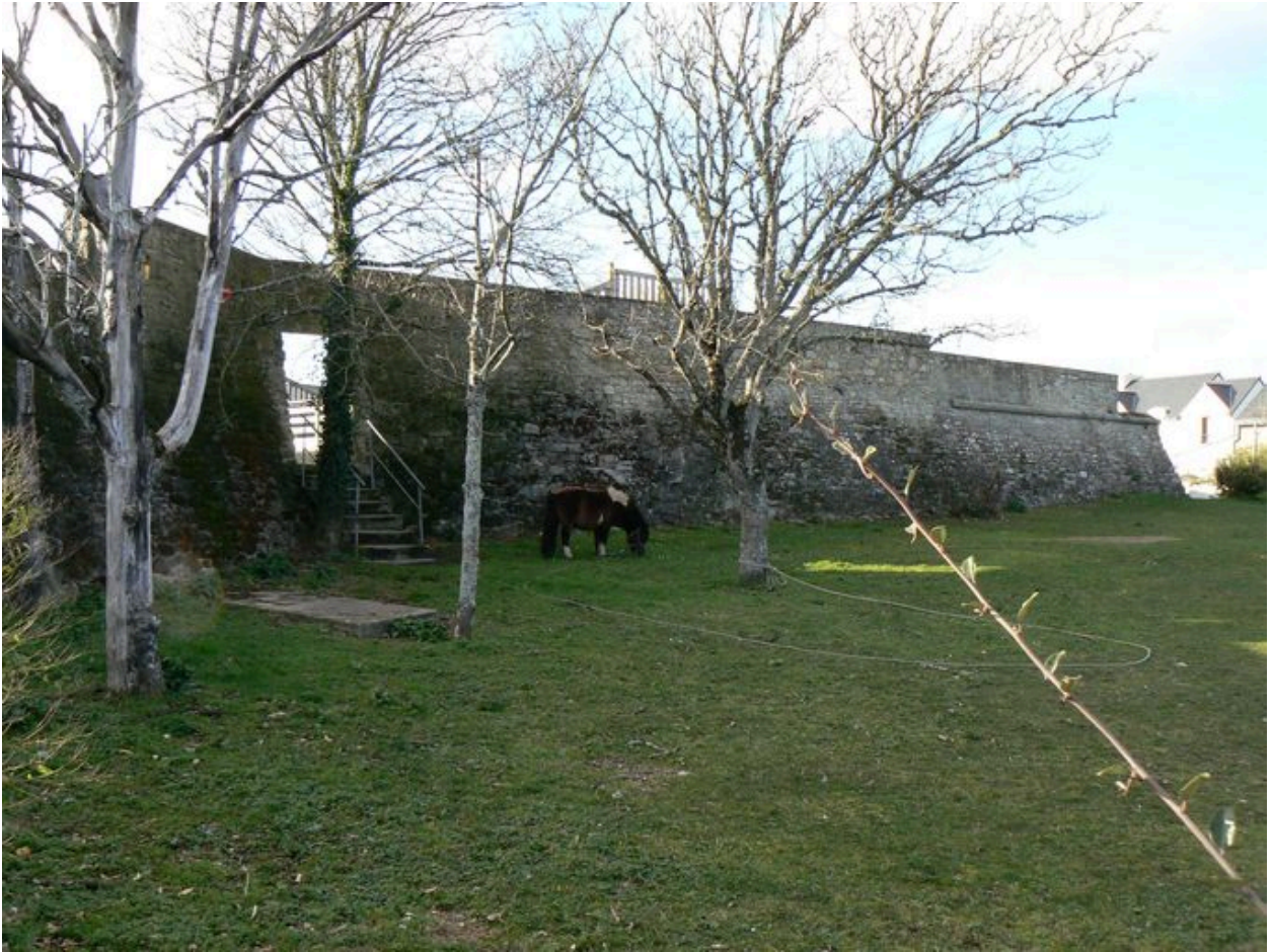
Vue générale du fort de Locqueltas
