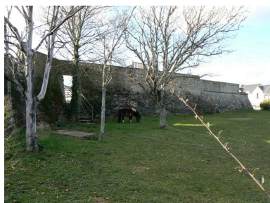
Vue générale du fort de Locqueltas Phot. Julien Amghar IVR53_20085606019NUCA
