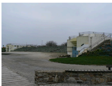
Casemates à proximité du fort de Locqueltas Phot. Julien Amghar IVR53_20085606023NUCA
