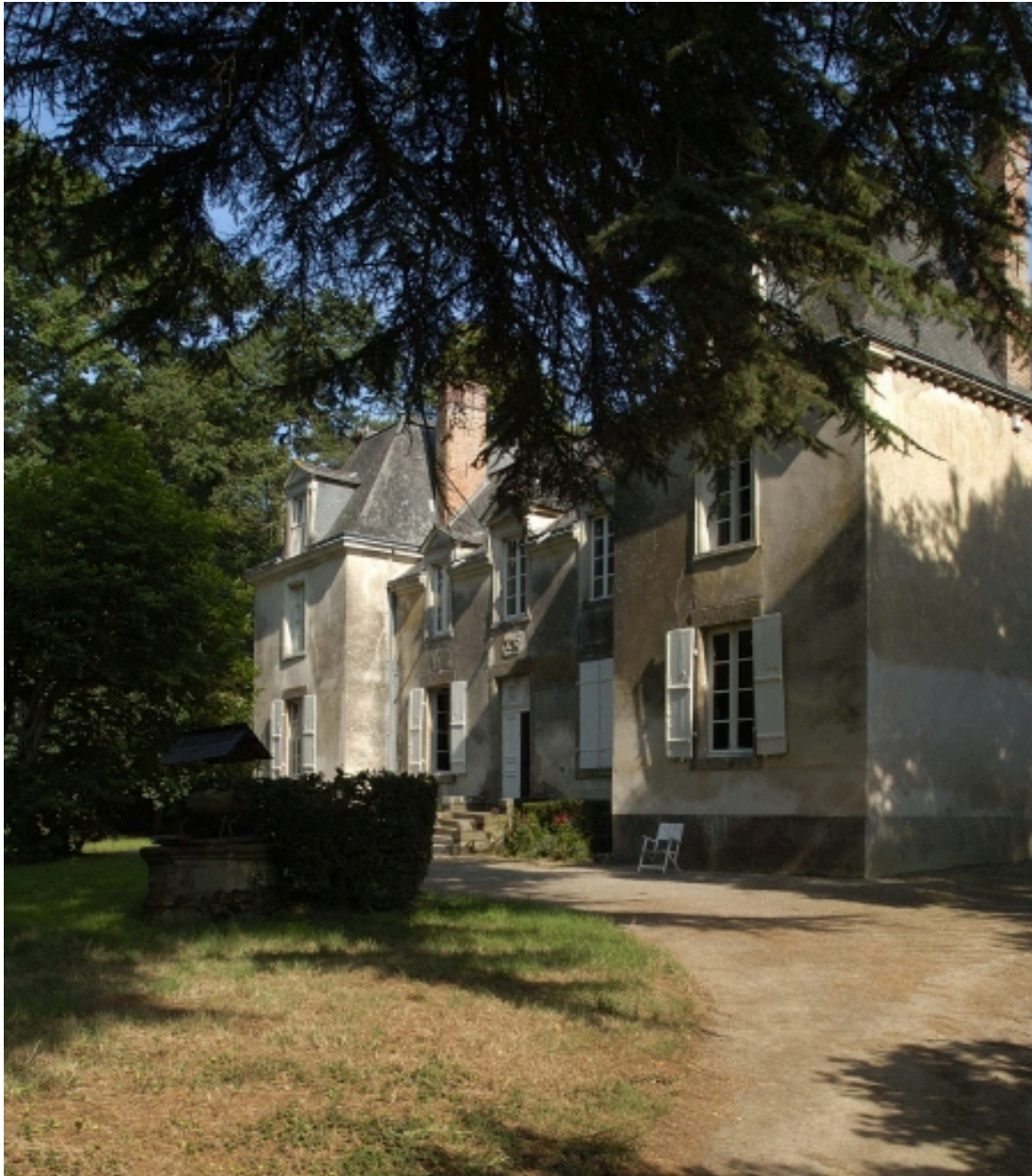
Vue générale rapprochée du logis
