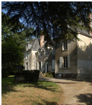
Vue générale rapprochée du logis Phot. Guy Artur, Phot. Norbert Lambart IVR53_20033501354NUCA
