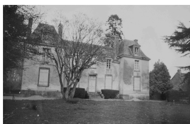
Vue générale de la façade (état en 1973) Phot. Auteur inconnu IVR53_20033510641NUC
