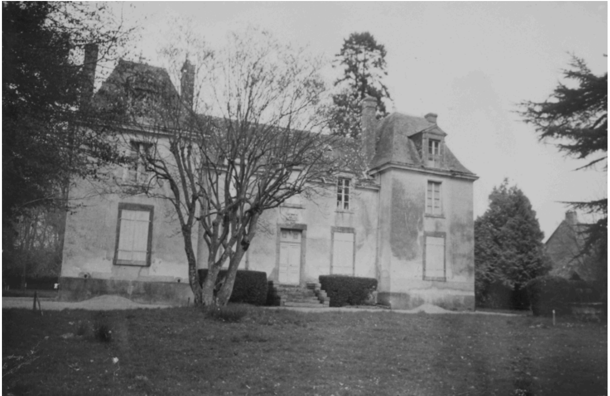
Vue générale de la façade (état en 1973)
