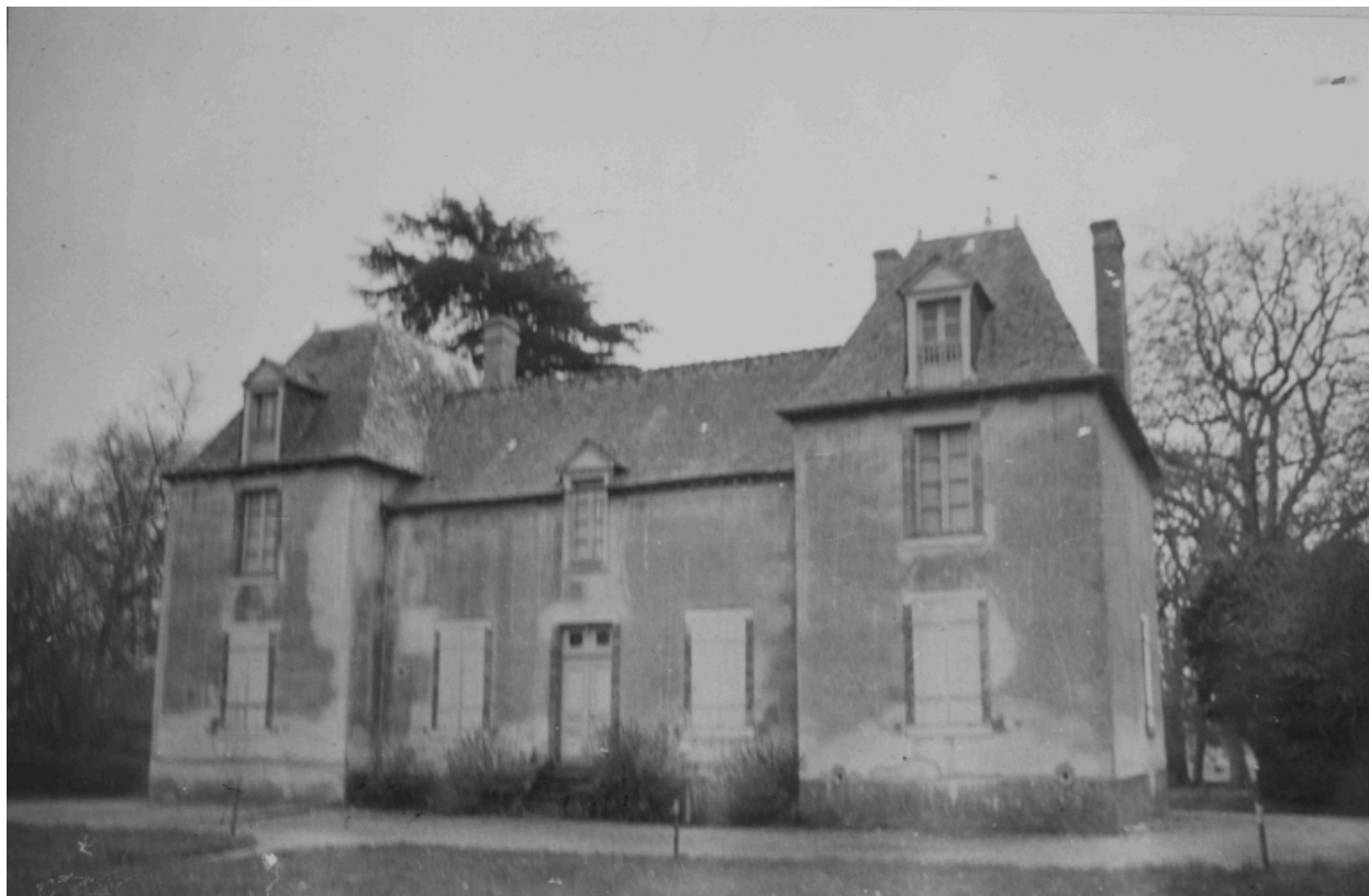
Vue générale de la façade (état en 1973)
