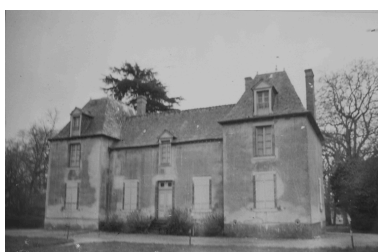
Vue générale de la façade (état en 1973) Phot. Auteur inconnu IVR53_20033510642NUC
