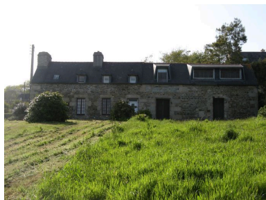
Vue générale du corps de garde de Postermen Phot. Guillaume Marie IVR53_20082908479NUCA
