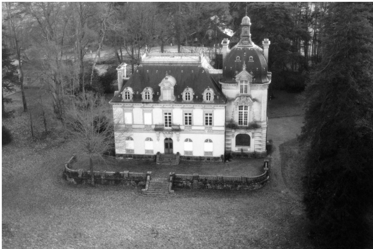
Vue aérienne rapprochée nord.
