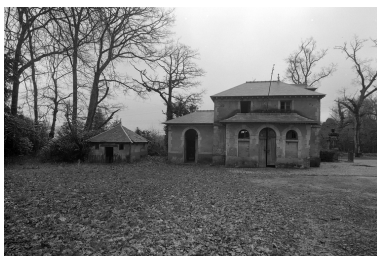
Pavillon d'écurie, vue générale. Phot. Guy Artur IVR53_19703500095V
