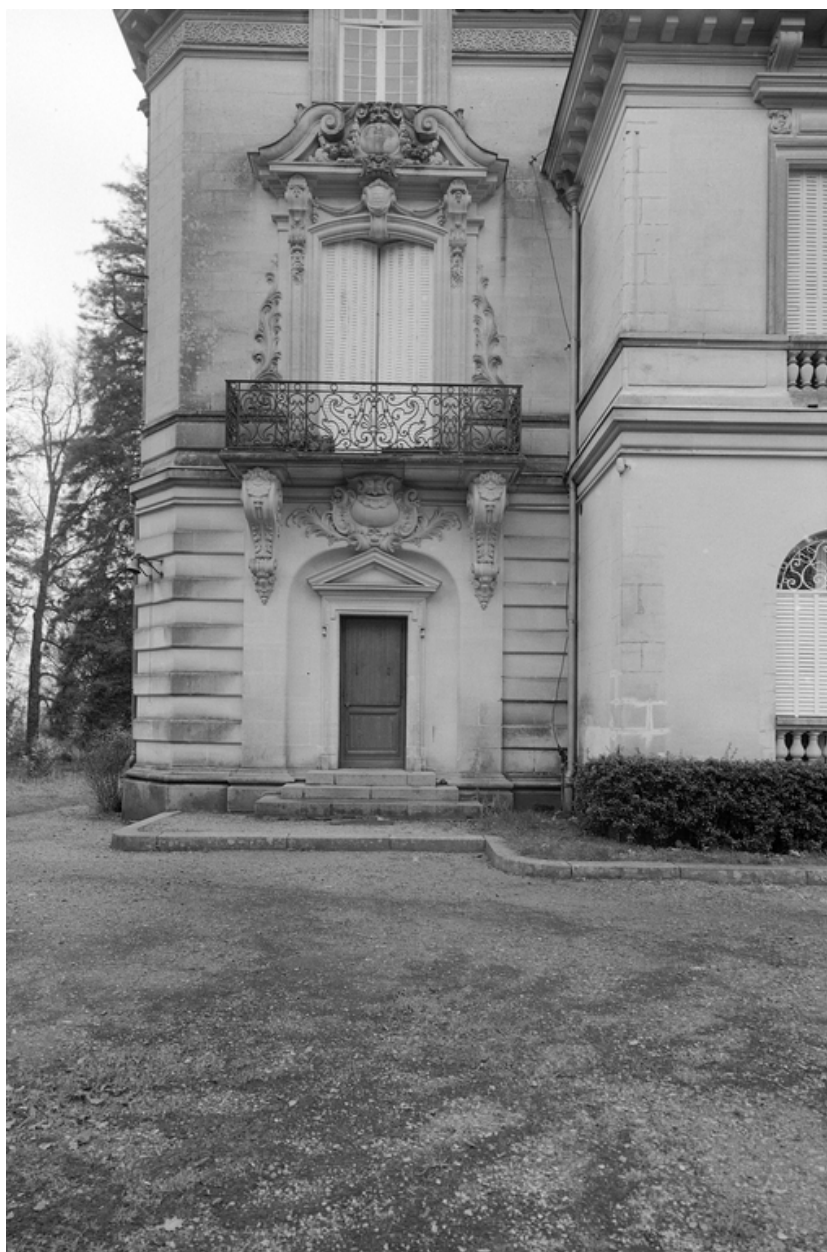
Vue de détail de la façade sud.
