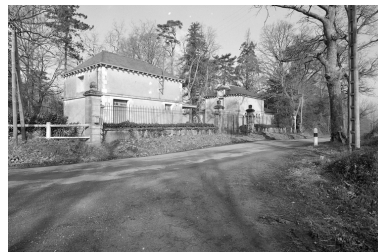
Entrée principale, vue générale. Phot. Guy Artur IVR53_19703500143V
