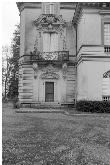
Vue de détail de la façade sud. Phot. Guy Artur IVR53_19703500096V
