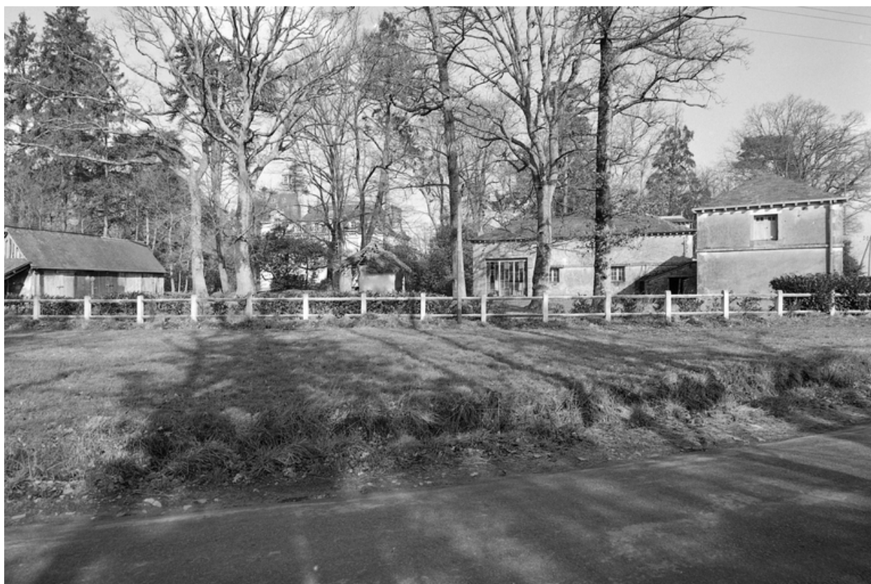
Vue de situation sud.
