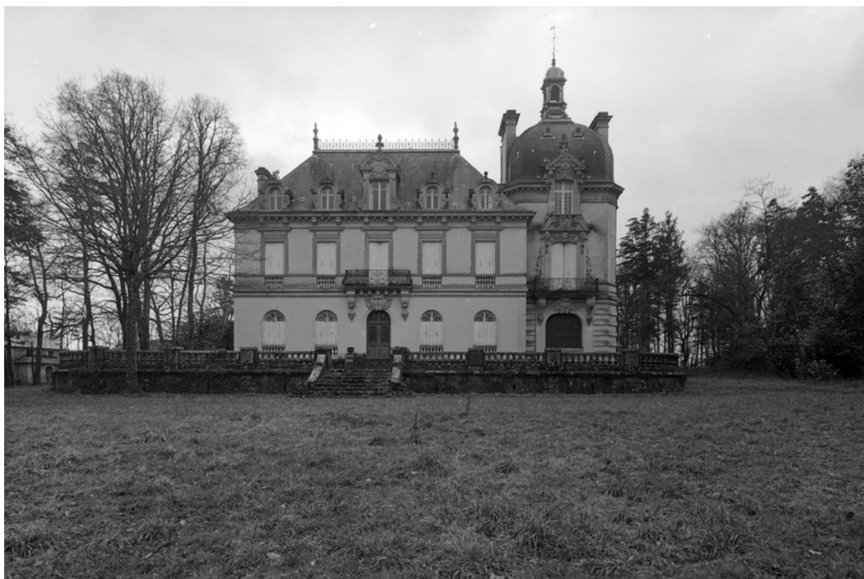
Façade nord, vue générale.
