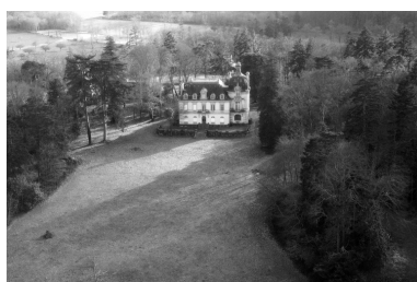
Vue aérienne nord. Phot. G.A.L.A.T.
