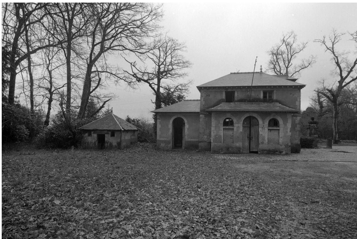
Pavillon d'écurie, vue générale.
