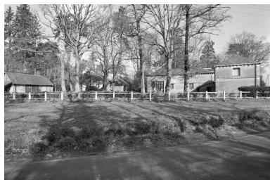
Vue de situation sud. Phot. Guy Artur IVR53_19703500142V
