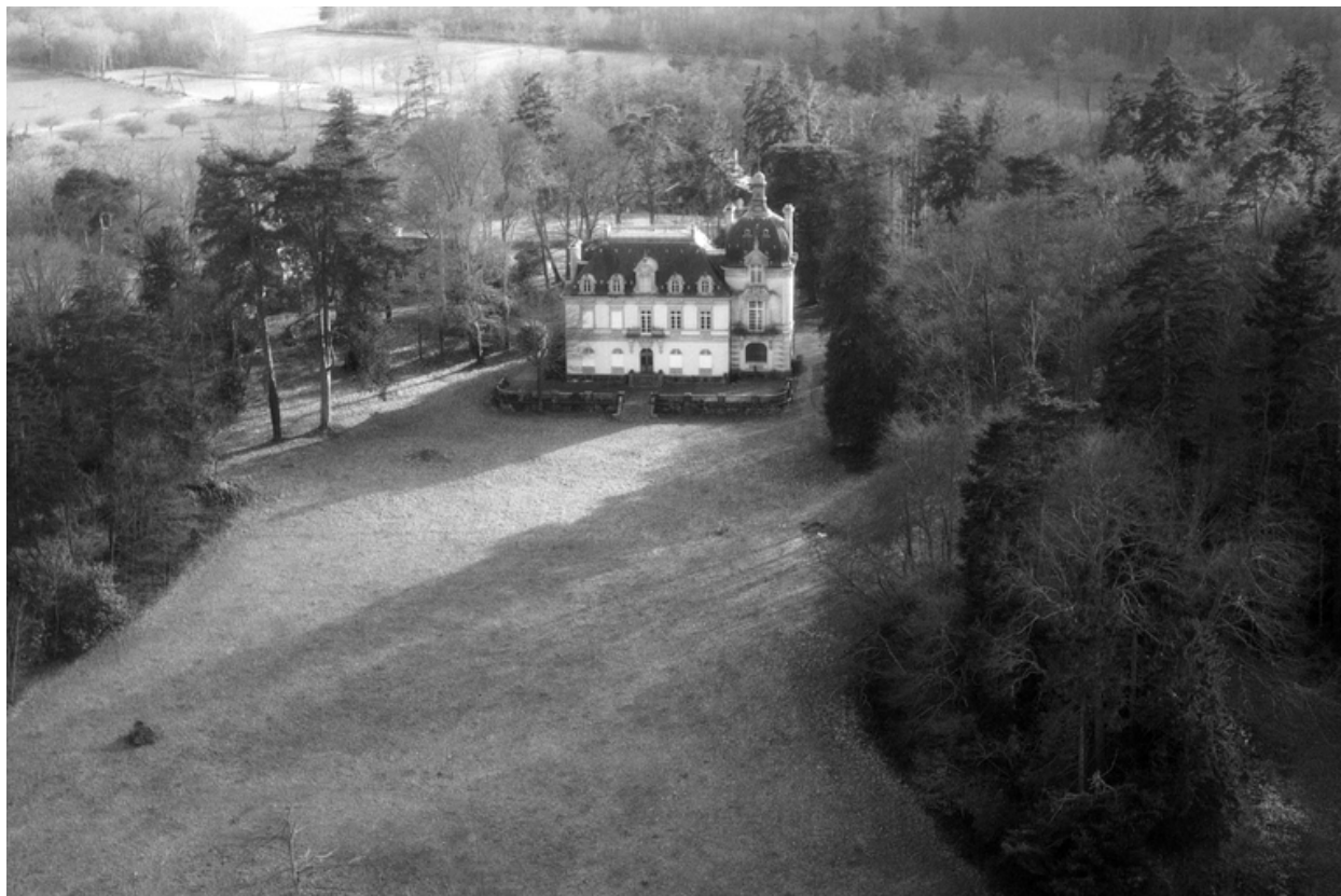
Vue aérienne nord.
