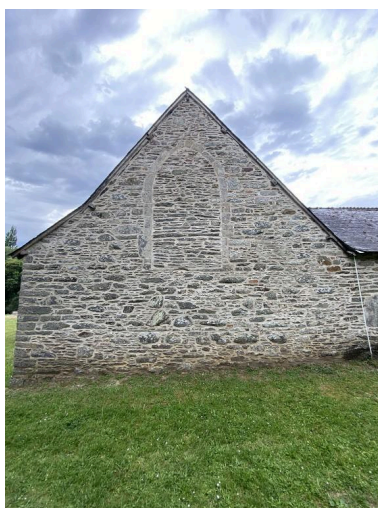
Élévation est Phot. Baptiste Oligo IVR53_20265610395NUCA
