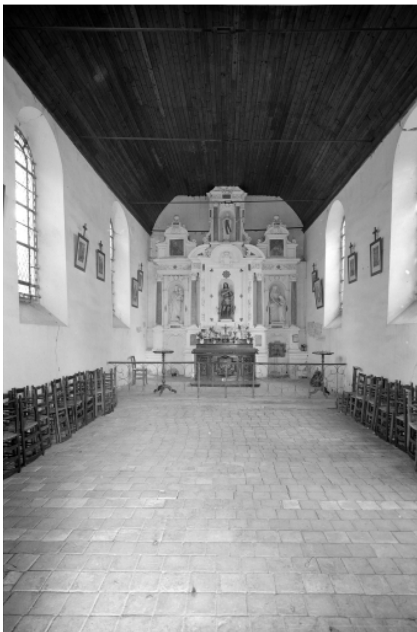
Intérieur : vue générale vers le chœur.
