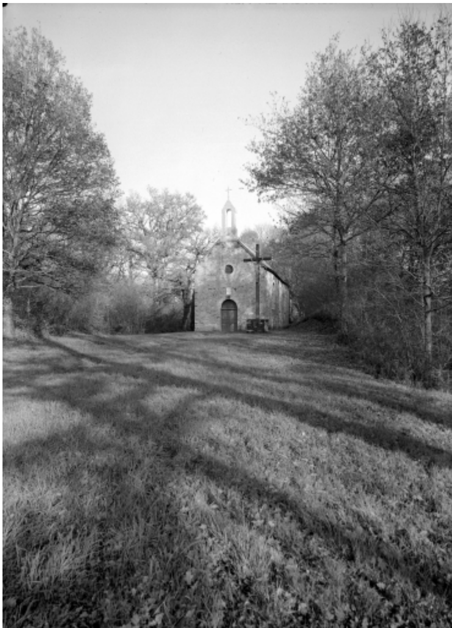
Elévation Ouest : vue de situation
