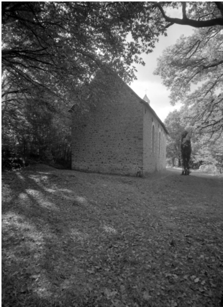
Elévation Est : vue générale
