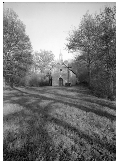
Elévation Ouest : vue de situation Phot. François Dagorn IVR53_19673500293V
