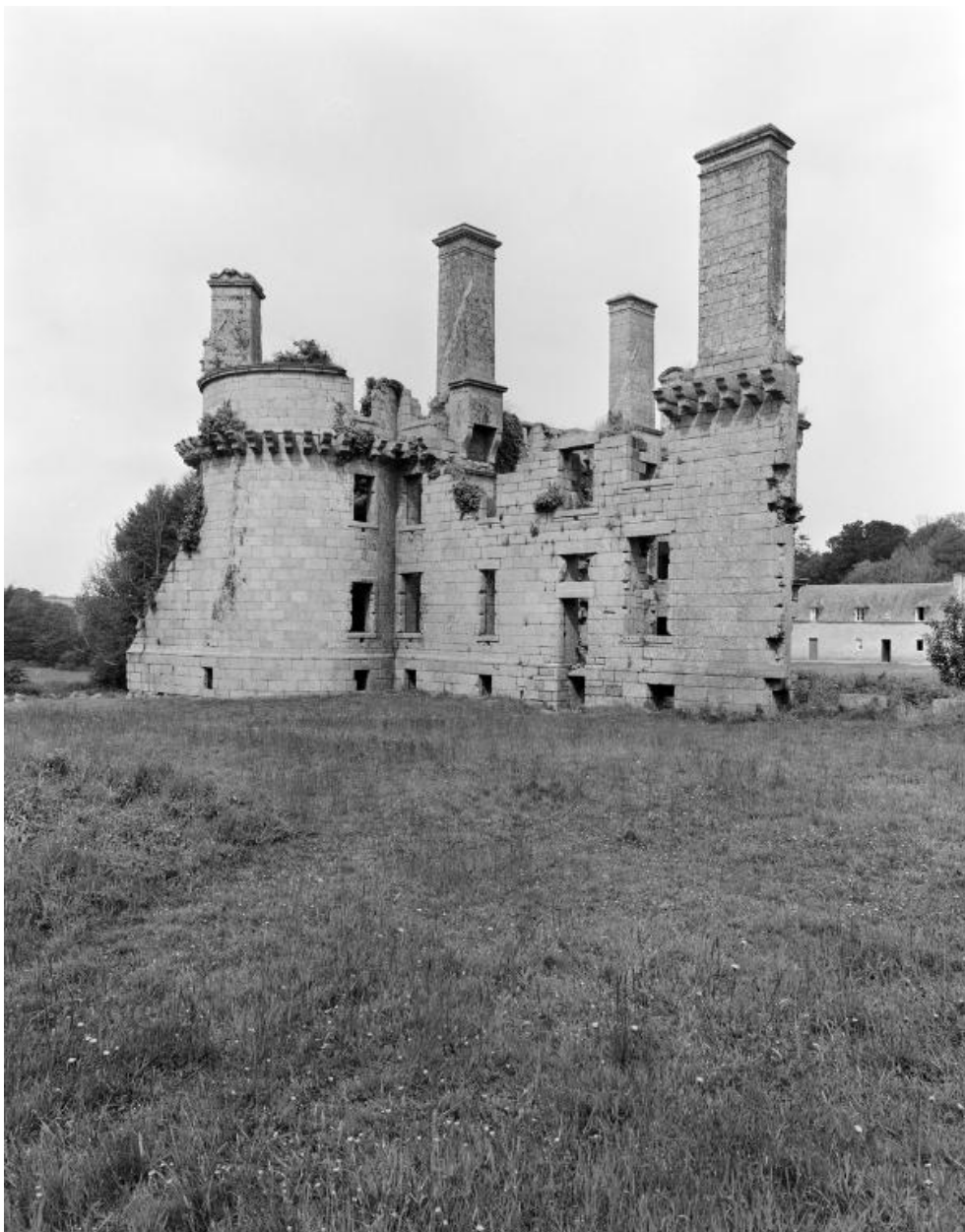
Vue de la tour sud et de la courtine sud-est (état en 1986)
