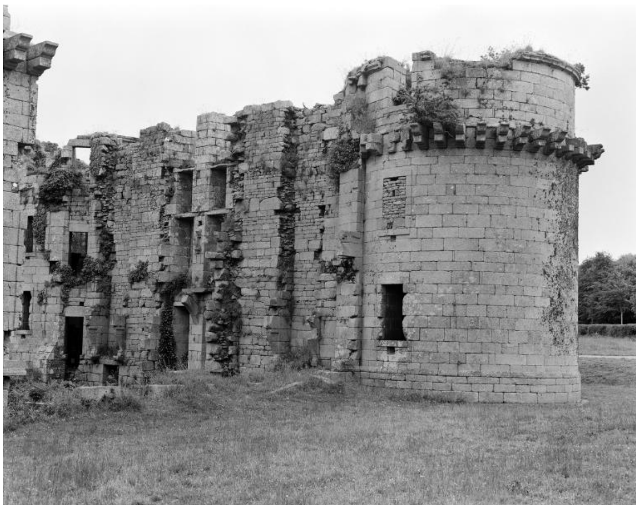
Vue de l'intérieur de la courtine nord-est (état en 1986). Au premier plan, la tour est. La fenêtre du premier étage de la tour a été murée et dotée d'une ouverture de tir
