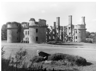
Vue générale depuis le nord (état en 1986). La courtine nord-ouest a été déconstruite Phot. Norbert Lambart IVR53_19862900532V
