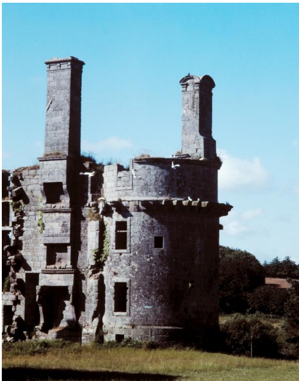
Vue de la tour ouest depuis le nord-est (état en 1986). A gauche, superposition de trois cheminées (rez-de-chaussée, premier étage et étage de comble). Les souches de cheminée sont ornées
