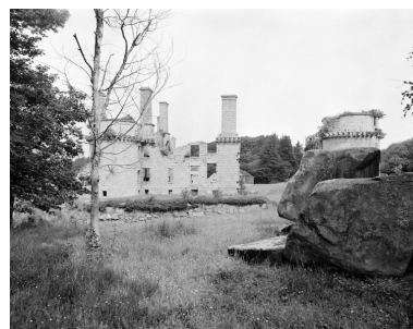
Vue générale depuis l'est (état en 1986). La courtine sud-est a été partiellement détruite Phot. Norbert Lambart IVR53_19862900536X
