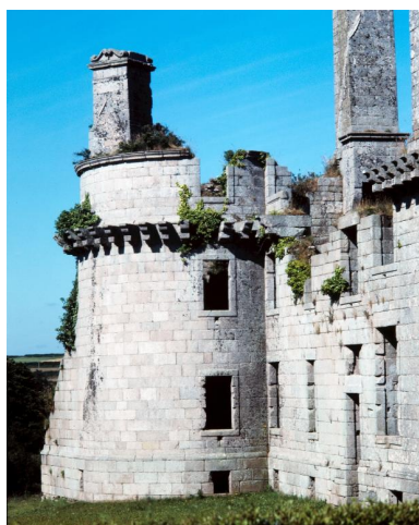
Vue de la tour sud et de la courtine sud-est (état en 1986). A gauche, l'éperon de la tour. Les fenêtres sont dotées d'un large bandeau décoratif. Chaque allège de fenêtre est percée d'une ouverture de tir
