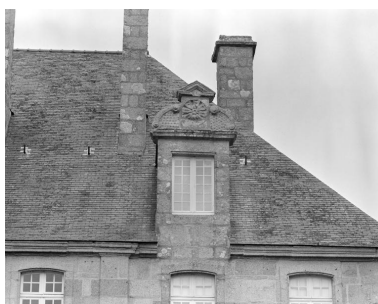
Vue de la demeure située au nord du château : élévation orientée vers le sud-est, détail de l'une des deux lucarnes (état en 1986) Phot. Norbert Lambart IVR53_19862900523X
