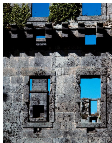
Vue de détail de deux fenêtres (état en 1986). Chaque allège de fenêtre est percée d'une ouverture de tir Phot. Norbert Lambart IVR53_19862900561XA
