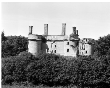
Vue générale depuis l'ouest : courtine sud-ouest (état en 1986). La tour sud comporte à sa base un éperon Phot. Norbert Lambart IVR53_19862900530X
