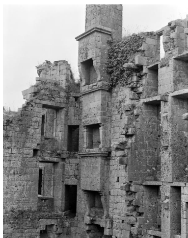
Vue du mur intérieur de la courtine sud-ouest depuis le nord : superposition des cheminées des rez-de-chaussée, premier étage et étage de comble (état en 1986) Phot. Norbert Lambart IVR53_19862900527X
