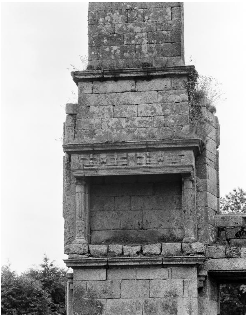
Vue du mur intérieur de la courtine sud-est depuis le nord : cheminée de la grande salle centrale du premier étage (état en 1986)
