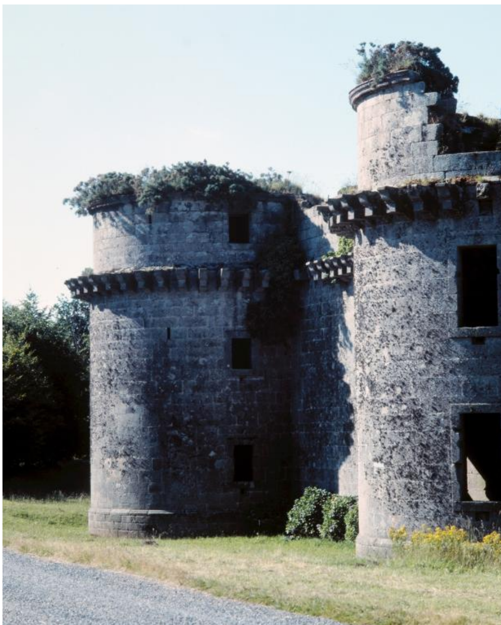
Vue des tours nord et est (état en 1986). Entre les tours, la courtine nord-est
