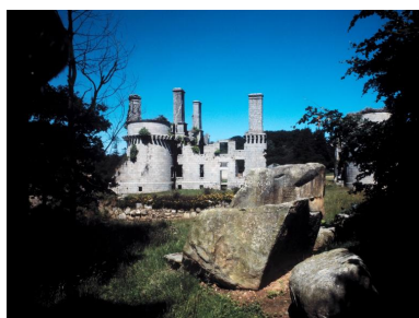
Vue générale depuis l'est (état en 1986). La courtine sud-est a été partiellement détruite Phot. Norbert Lambart IVR53_19862900538XA
