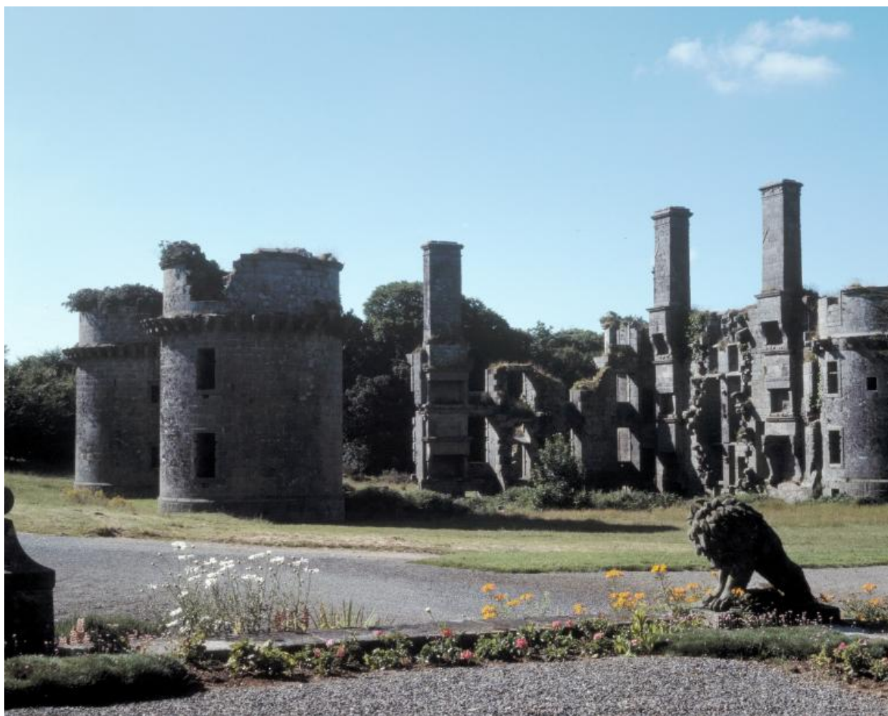
Vue générale depuis le nord et la terrasse du logis (état en 1986). Au premier plan, l'un des lions qui ornent le jardin
