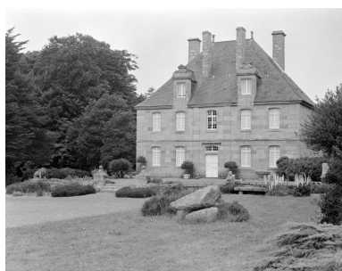
Vue de la demeure située au nord du château : élévation orientée vers le sud-est (état en 1986) Phot. Norbert Lambart IVR53_19862900522X
