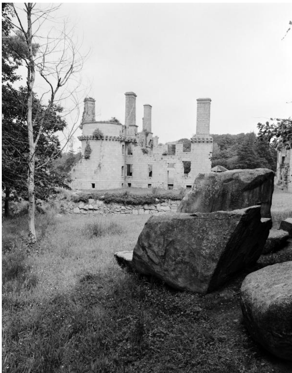
Vue générale depuis l'est (état en 1986). La courtine sud-est a été partiellement détruite
