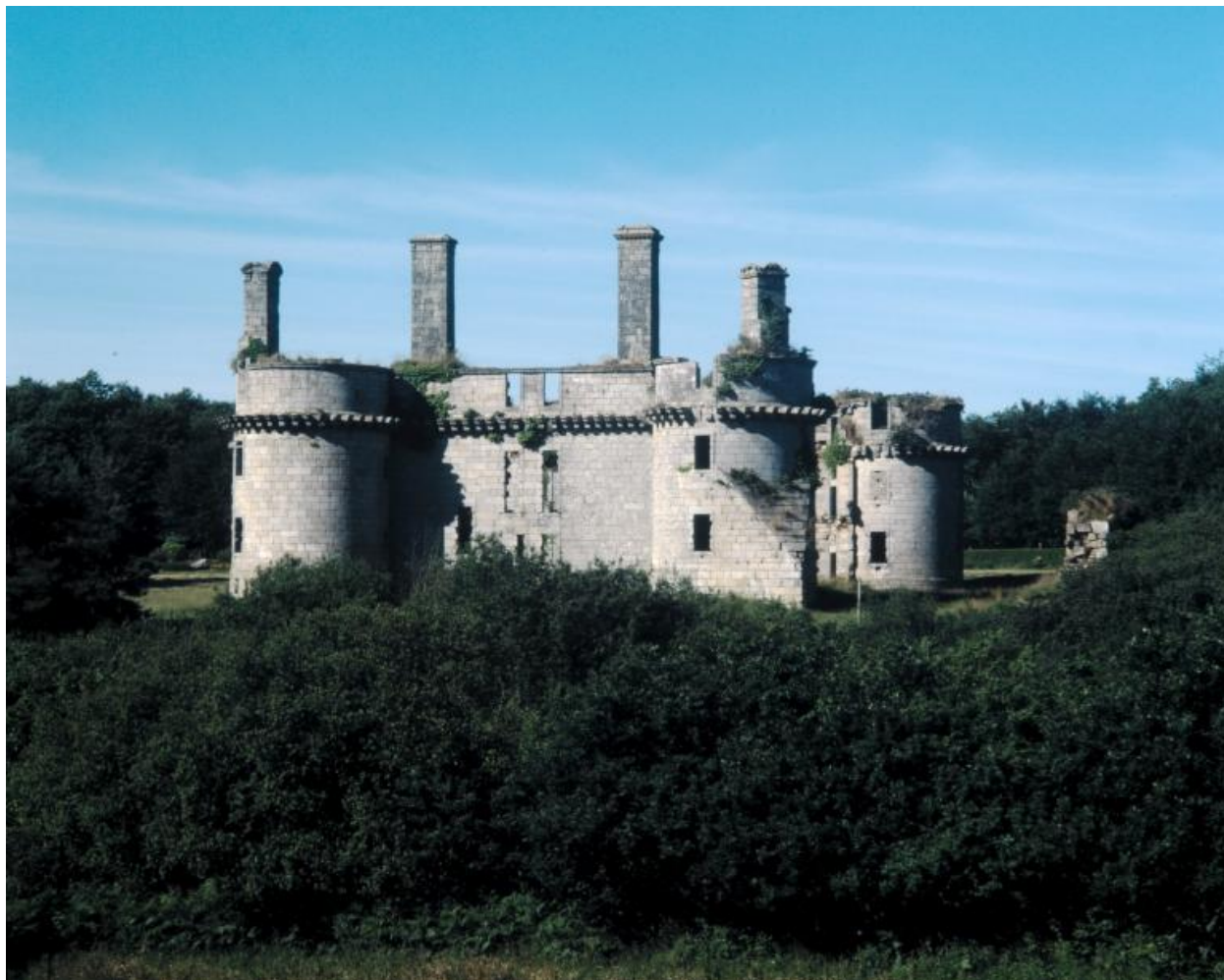
Vue générale depuis l'ouest : courtine sud-ouest (état en 1986). La tour sud comporte à sa base un éperon
