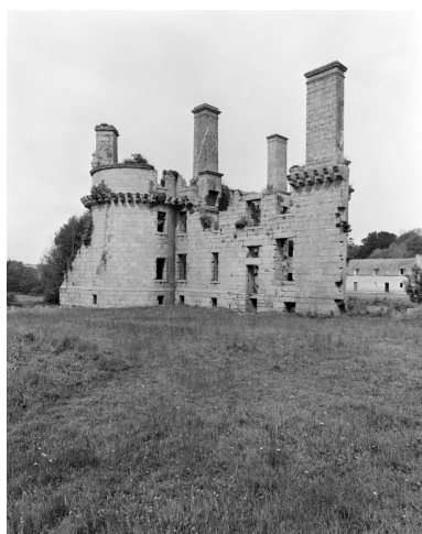
Vue de la tour sud et de la courtine sud-est (état en 1986) Phot. Norbert Lambart IVR53_19862900544X
