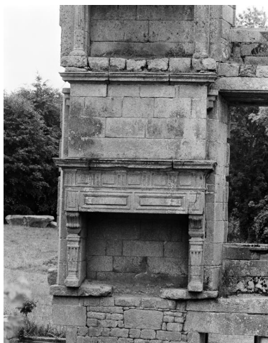
Vue du mur intérieur de la courtine sud-est depuis le nord : cheminée de la grande salle centrale du rez-de-chaussée (état en 1986)
