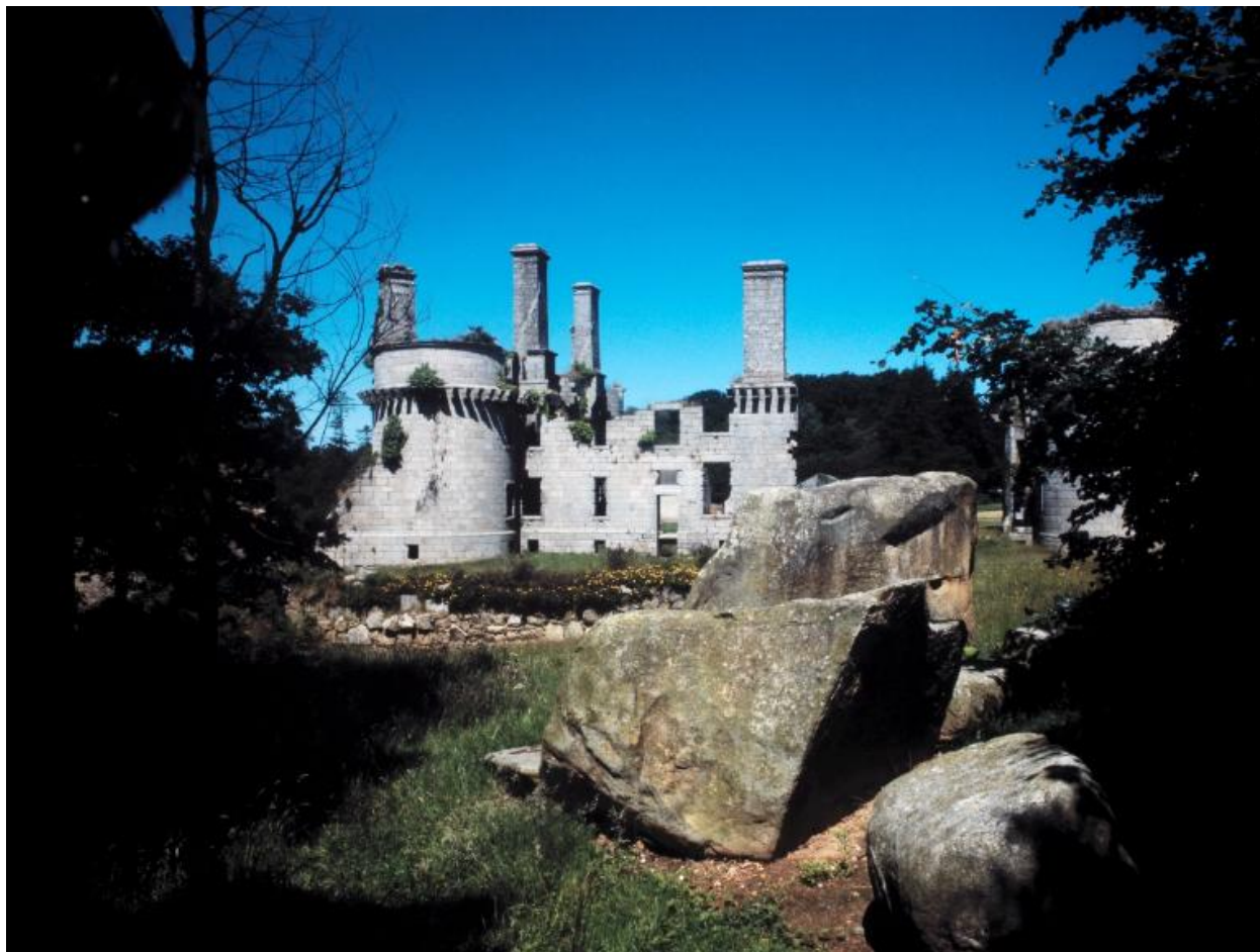
Vue générale depuis l'est (état en 1986). La courtine sud-est a été partiellement détruite
