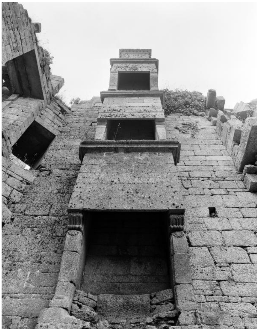
Vue en contreplongée du mur intérieur de la courtine sud-ouest depuis le nord : superposition des cheminées des rez-de-chaussée, premier étage et étage de comble (état en 1986)
