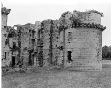
Vue de l'intérieur de la courtine nord-est (état en 1986). Au premier plan, la tour est. La fenêtre du premier étage de la tour a été murée et dotée d'une ouverture de tir Phot. Norbert Lambart IVR53_19862900546X
