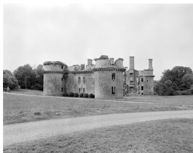
Vue générale depuis le nord (état en 1986). La courtine nord-ouest a été déconstruite Phot. Norbert Lambart IVR53_19862900534X
