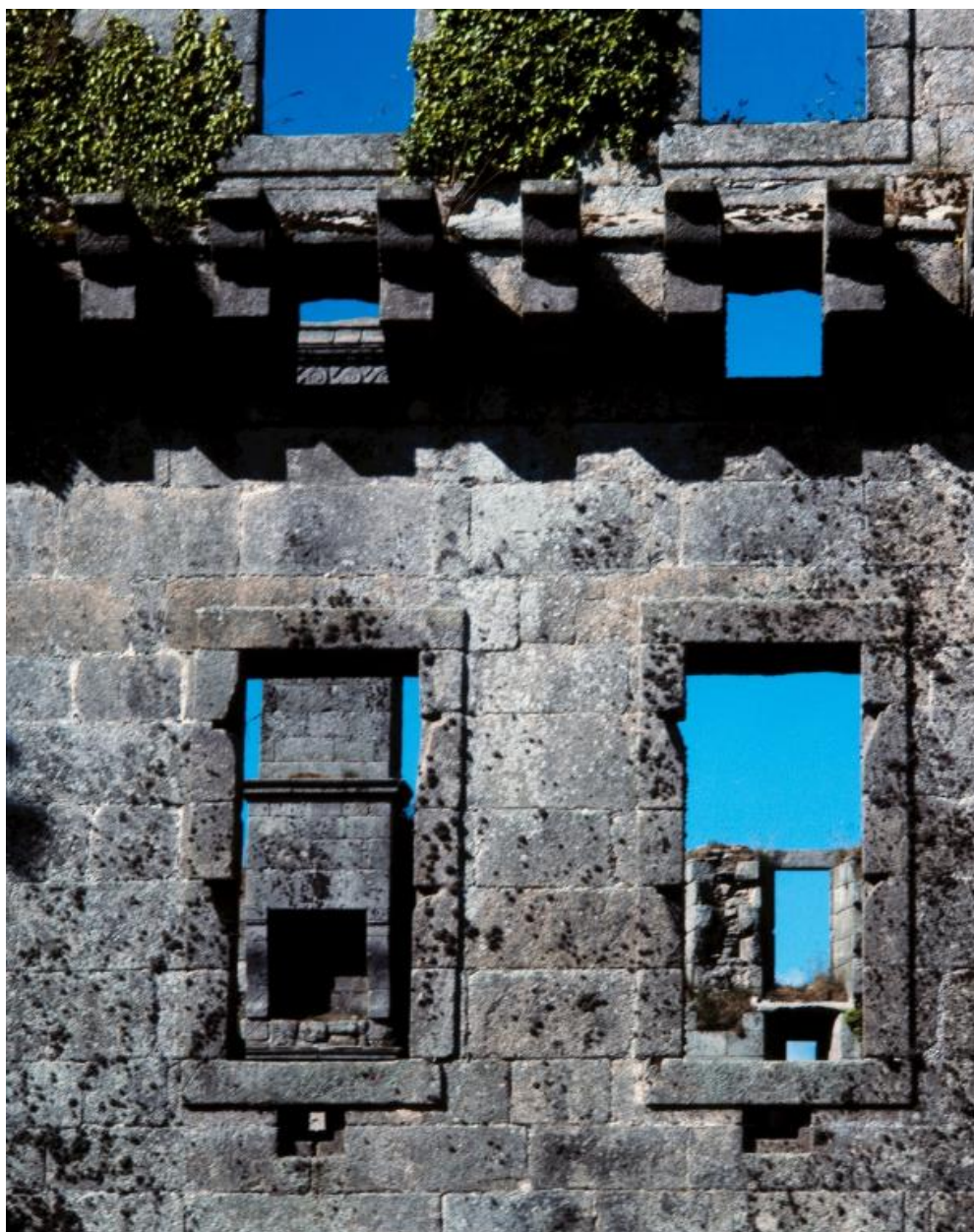
Vue de détail de deux fenêtres (état en 1986). Chaque allège de fenêtre est percée d'une ouverture de tir
