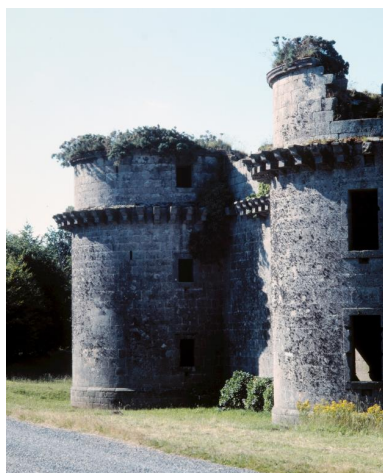
Vue des tours nord et est (état en 1986). Entre les tours, la courtine nord-est Phot. Norbert Lambart IVR53_19862900548XA
