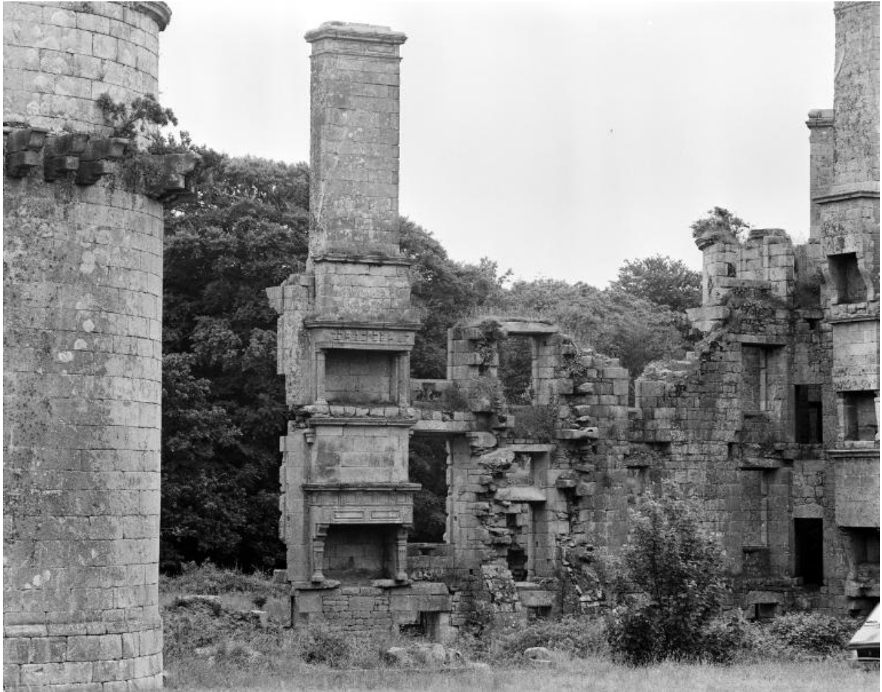
Vue du mur intérieur de la courtine sud-est depuis le nord (état en 1986). Les cheminées correspondent aux deux grandes salles centrales. A l'extrême droite, superposition de trois cheminées (rez-de-chaussée, premier étage et étage de comble). Les souches de cheminée sont ornées
