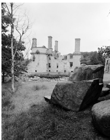
Vue générale depuis l'est (état en 1986). La courtine sud-est a été partiellement détruite Phot. Norbert Lambart IVR53_19862900537X
