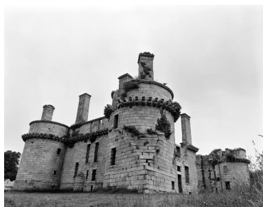
Vue rapprochée depuis le sud (état en 1986). Au centre, la tour sud-ouest est dotée d'un éperon Phot. Norbert Lambart IVR53_19862900545X
