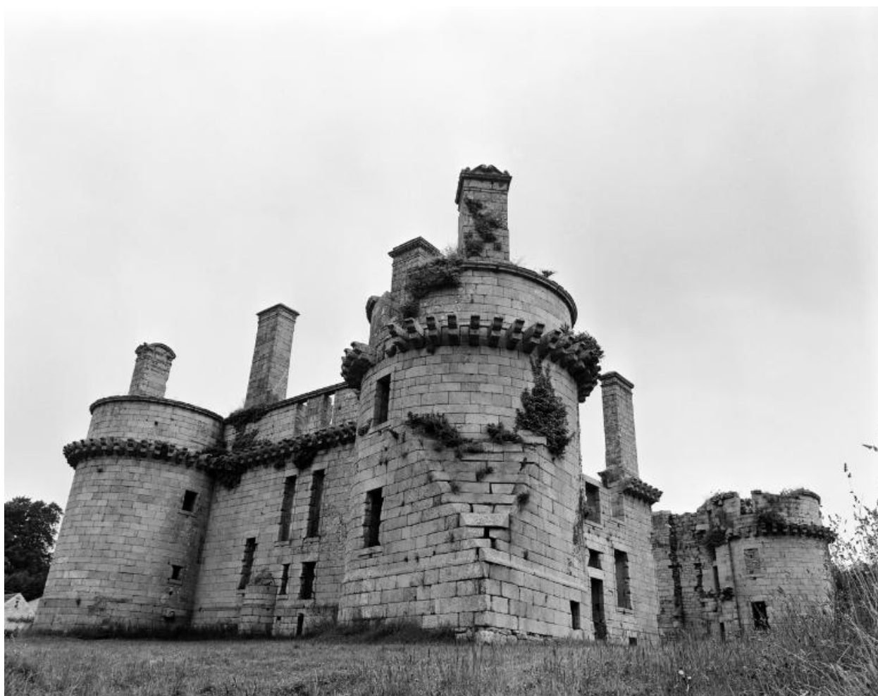
Vue rapprochée depuis le sud (état en 1986). Au centre, la tour sud-ouest est dotée d'un éperon
