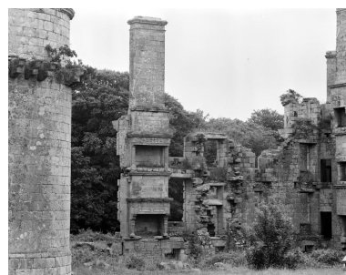
Vue du mur intérieur de la courtine sud-est depuis le nord (état en 1986).
