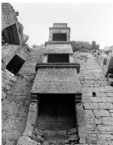
Vue en contreplongée du mur intérieur de la courtine sud-ouest depuis le nord : superposition des cheminées des rez-de-chaussée, premier étage et étage de comble (état en 1986) Phot. IVR53_19862900528X
