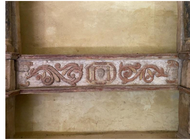
Détail Phot. Baptiste Oligo IVR53_20265610111NUCA
