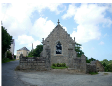
Guissény, chapelle Notre-Dame : élévation est Phot. Gwénaél Fauchille IVR53_20082906314NUCA
