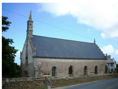
Guissény, chapelle Notre-Dame : vue générale sud-ouest Phot. Gwénaél Fauchille IVR53_20082906313NUCA
