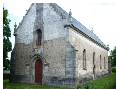
Guissény, chapelle Notre-Dame : vue générale sud-ouest Phot. Gwénaél Fauchille IVR53_20082906315NUCA
