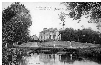
Vue générale Phot. Elise Lauranceau IVR53_20042209029NUCB
