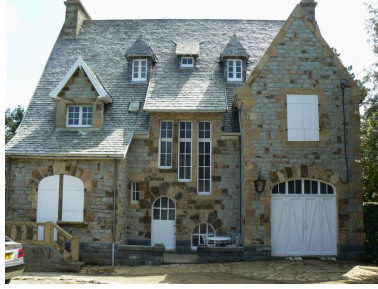
Vue arrière de la villa Roz Avel Phot. Johan Vincent IVR53_20072908611NUCA
