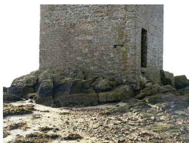
Vue de la base de la tour de Ténéro Phot. Julien Amghar IVR53_20085606130NUCA
