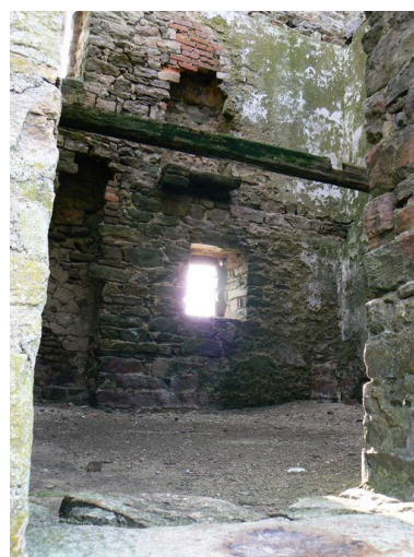
Vue intérieure de la tour de Ténéro Phot. Julien Amghar IVR53_20085606129NUCA
