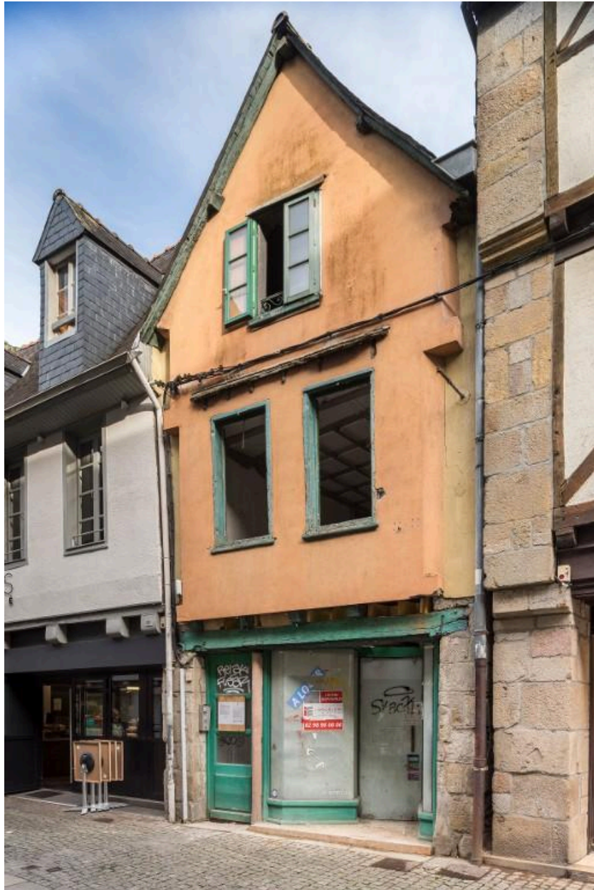
Maison à pignon sur rue et pan de bois entièrement enduit.
