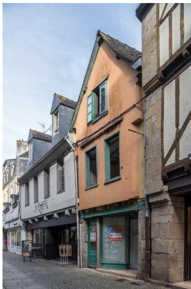
Alignement de maisons à façades sur rue en pan de bois, de formes variées (à pignon ou gouttereau sur rue, avec ou sans mur à ressaut, etc.). Phot. Charlotte Barraud IVR53_20242900958NUCA
