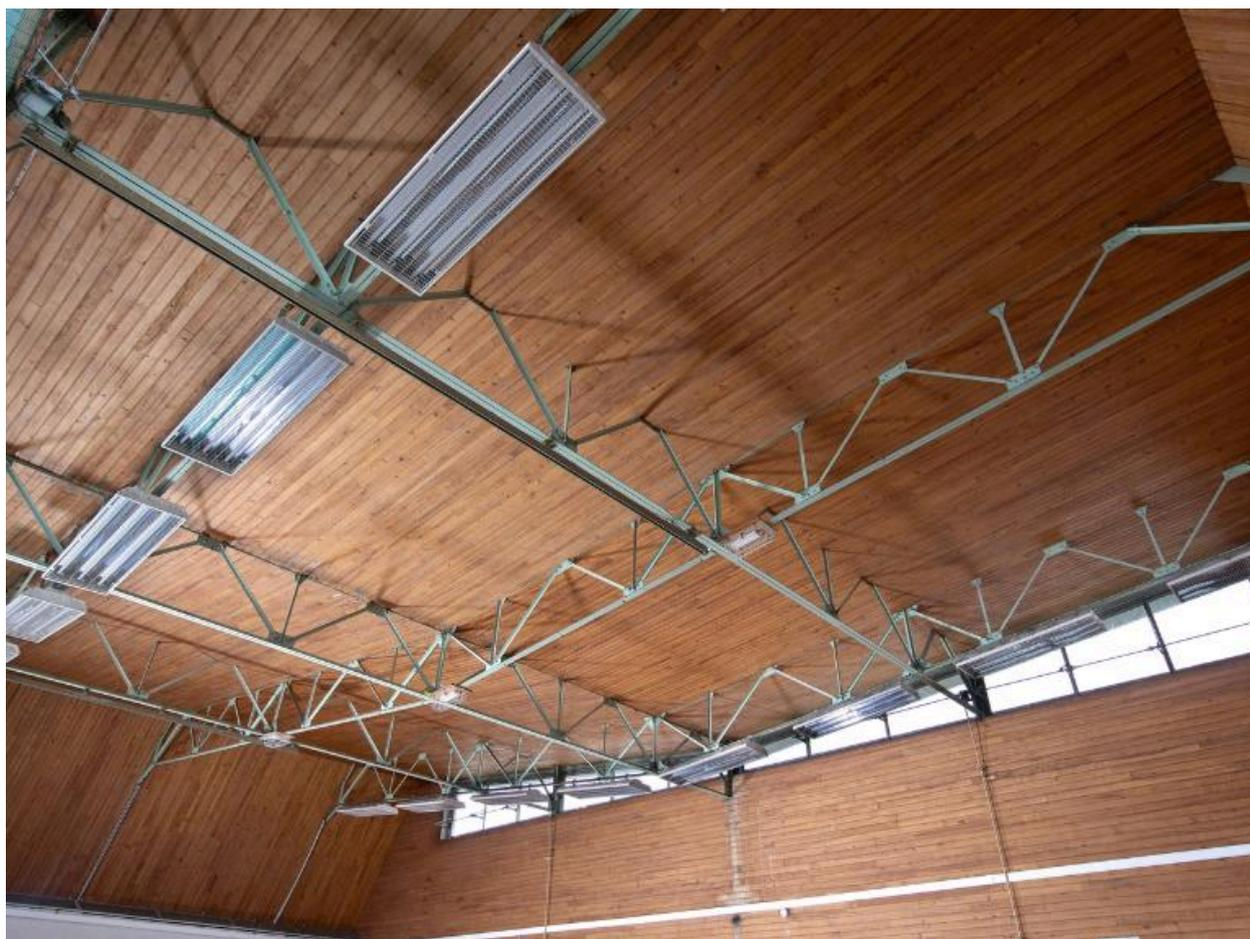
Vue de détail sur la charpente métallique, les lambris du plafond et la baie haute, côté sud.
