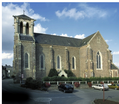
Vue générale sud-ouest Phot. Norbert Lambart IVR53_20023500644XA
