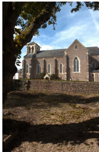
Vue de situation sud-est Phot. Norbert Lambart IVR53_20033501540NUCA
