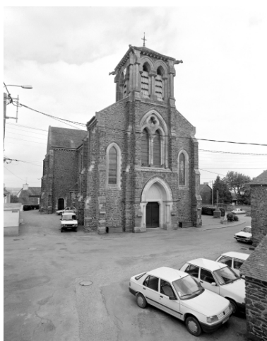
Elévation Ouest : vue générale Phot. Guy Artur, Phot. Norbert Lambart IVR53_19943500845X
