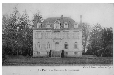
Vue générale Phot. Auteur inconnu IVR53_19883500466XB
