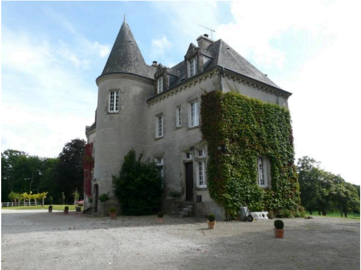
Façade nord et façade ouest
