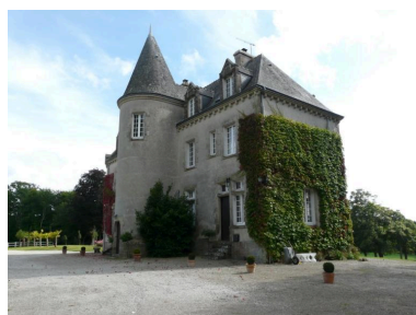
Façade nord et façade ouest
