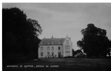
Vue générale de la façade
