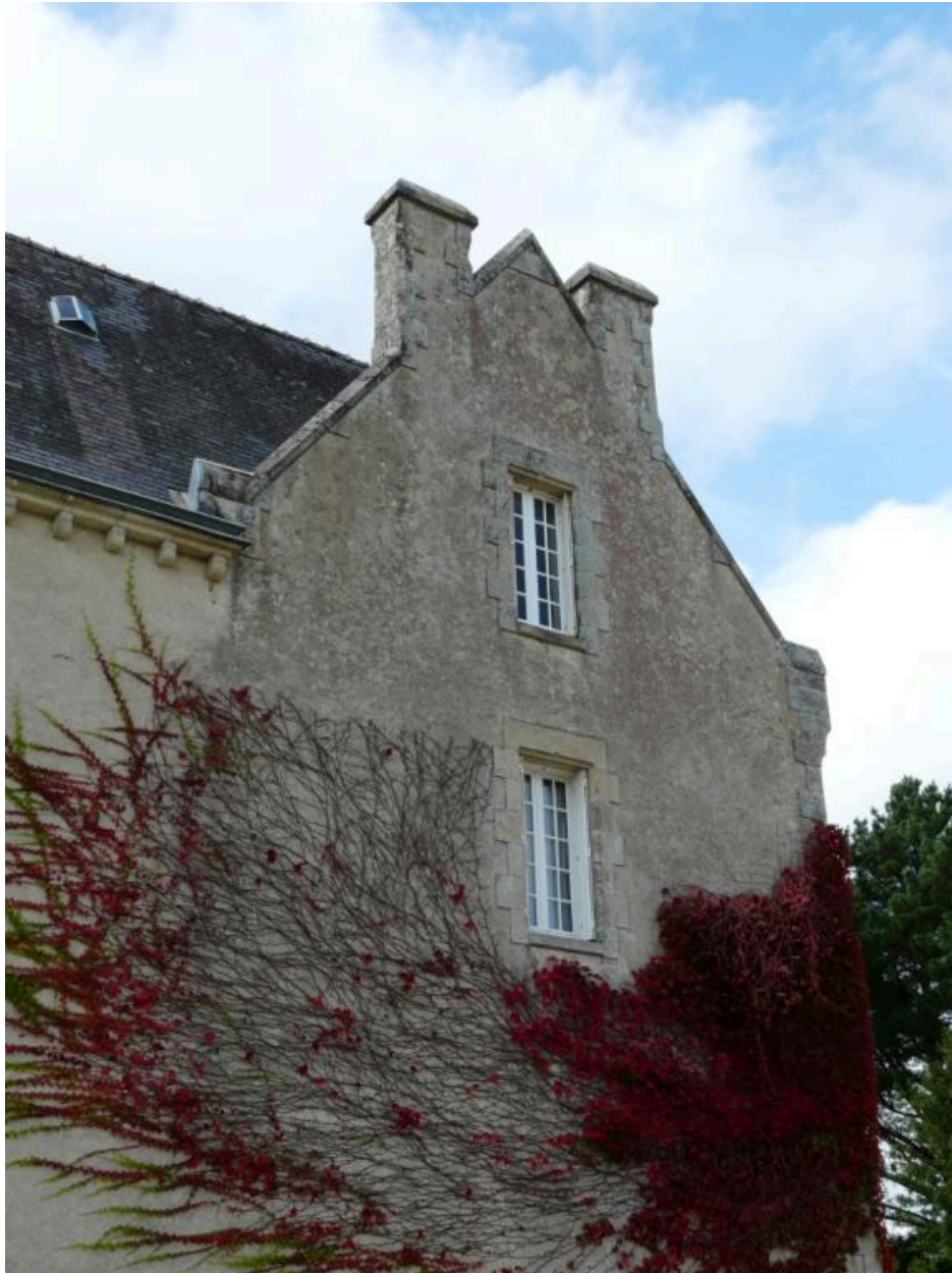
Façade est, détail du pignon à chevronnière avec deux souches de cheminée
