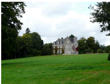
Façade sud du château vue du parc Phot. Jeanne Gueguen IVR53_20152911175NUCA
