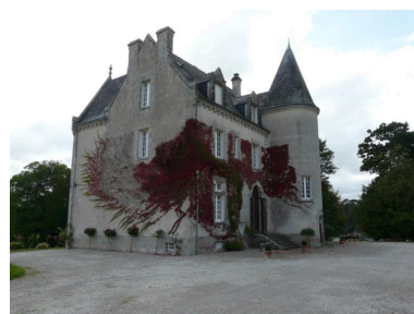
Façade nord et façade est
