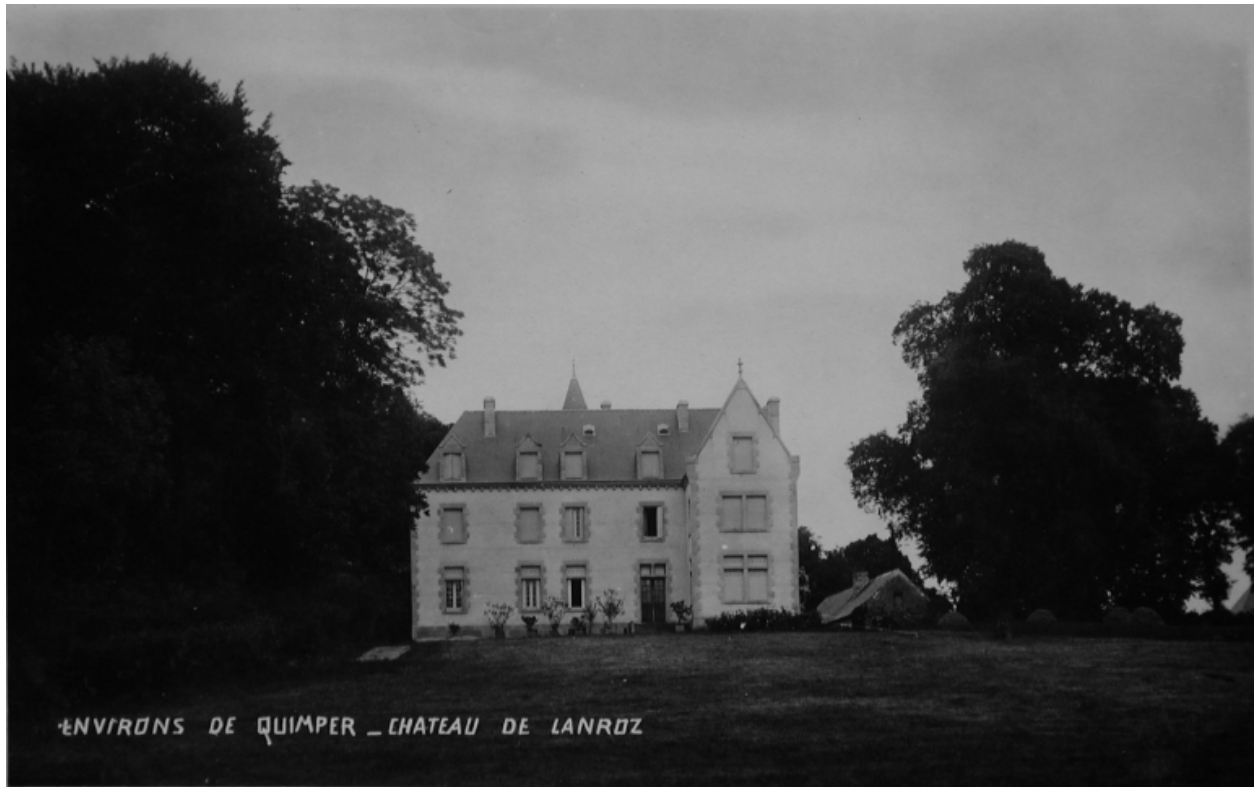
Vue générale de la façade
