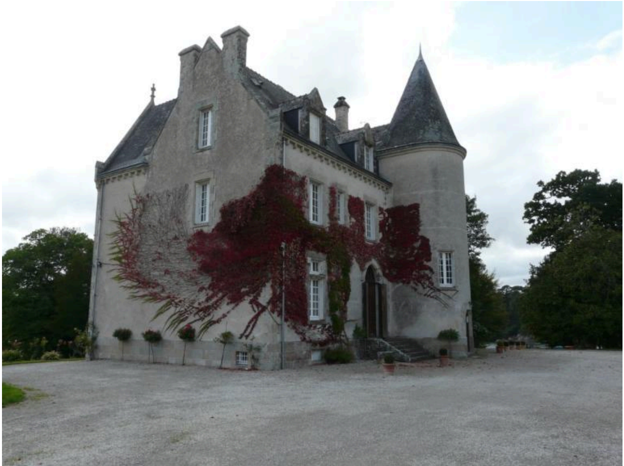
Façade nord et façade est
