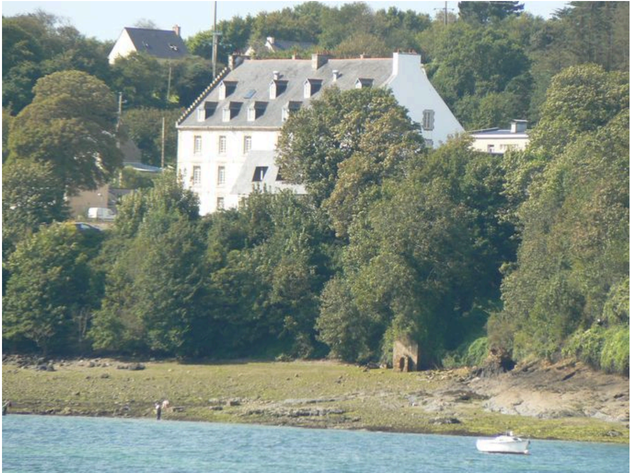
Vue générale de la caserne Sourdis
