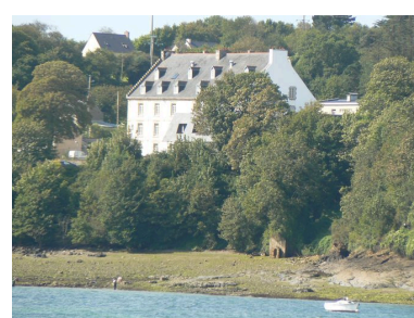
Vue générale de la caserne Sourdis Phot. Lénéaig L'Aot IVR53_20072908960NUCA
