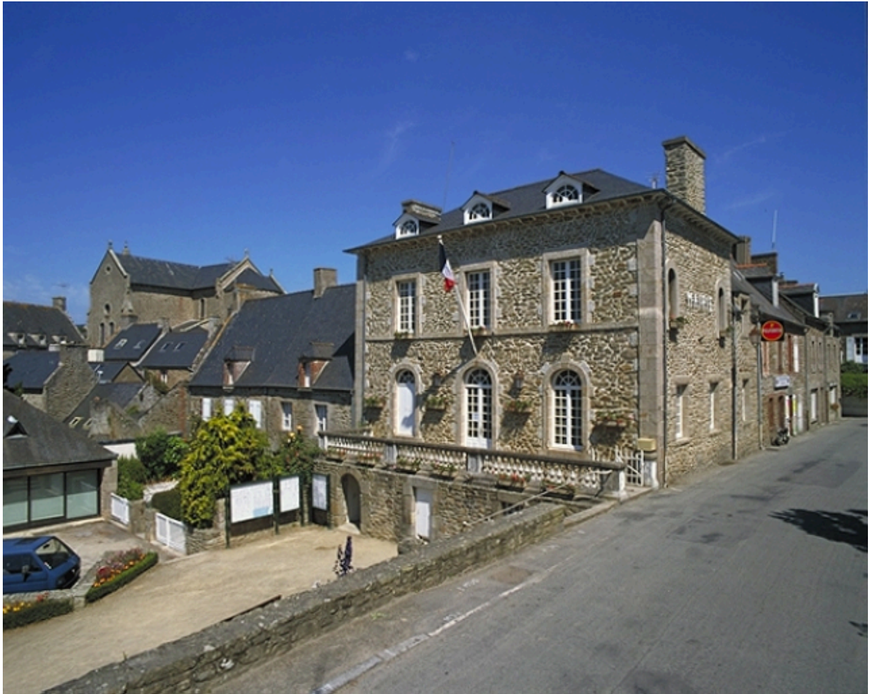
Vue de situation sud-est
