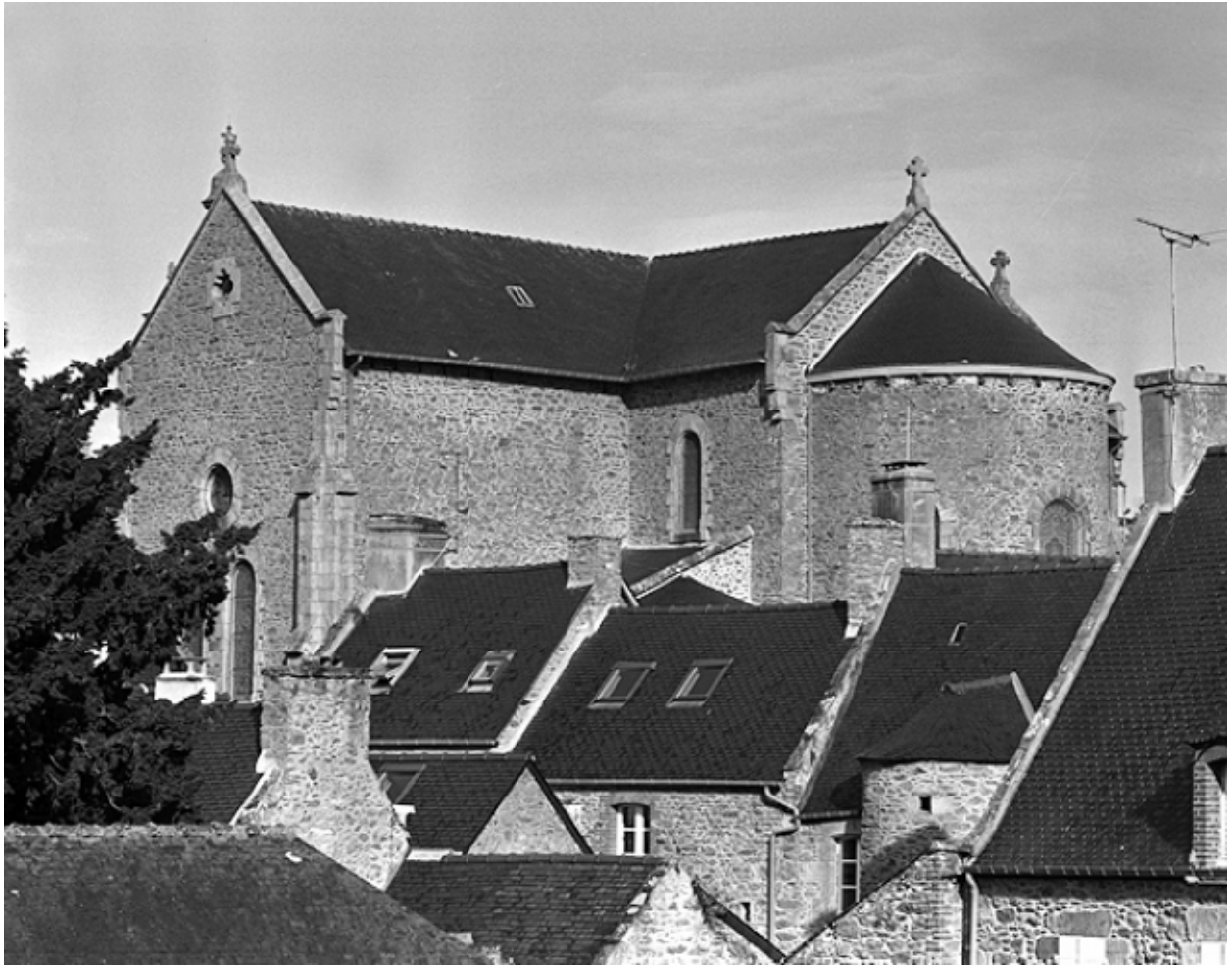
Vue de situation sud-est
