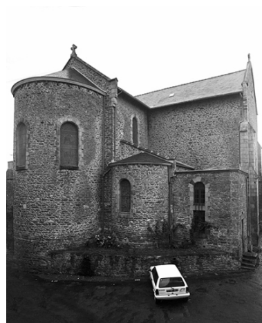
Vue générale nord-est Phot. Guy Artur, Phot. Norbert Lambart IVR53_19943501844X
