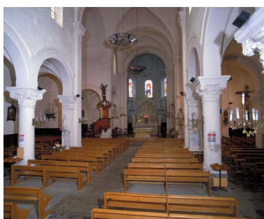
Vue intérieure prise de la nef vers le chœur en 2000 Phot. Bernard Bègne IVR53_20003501612XA
