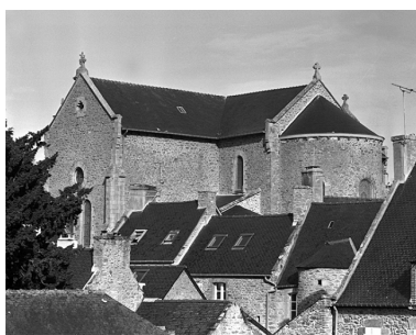
Vue de situation sud-est Phot. Guy Artur, Phot. Norbert Lambart IVR53_19943501848X
