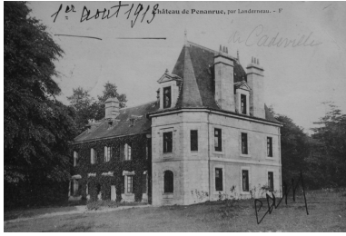
Vue générale Phot. Elise Lauranceau IVR53_20052904378NUCB
