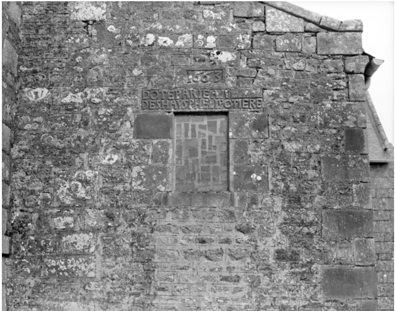
Elévation Ouest, partie Sud : détail de l'inscription
