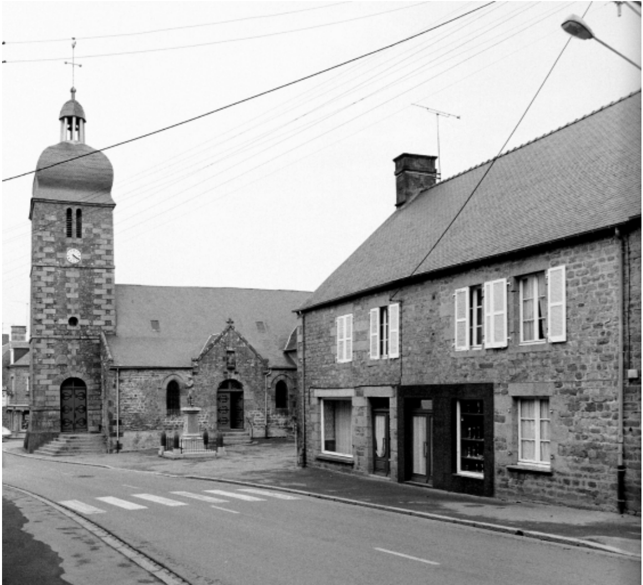
Elévation Sud, partie Ouest : vue générale
