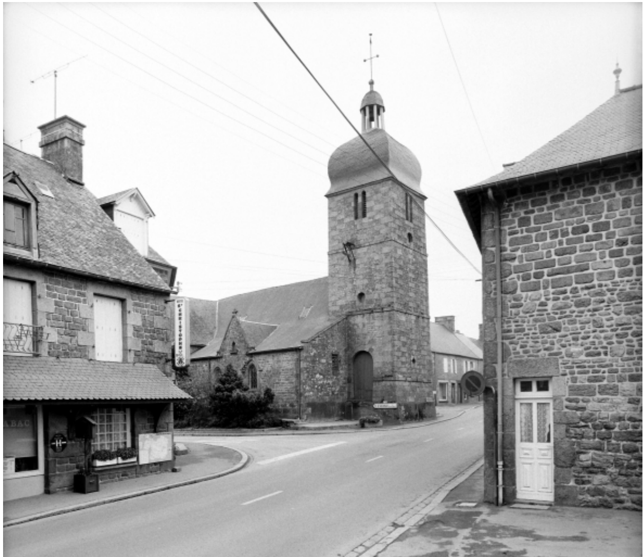
Elévation Nord-Ouest : vue générale
