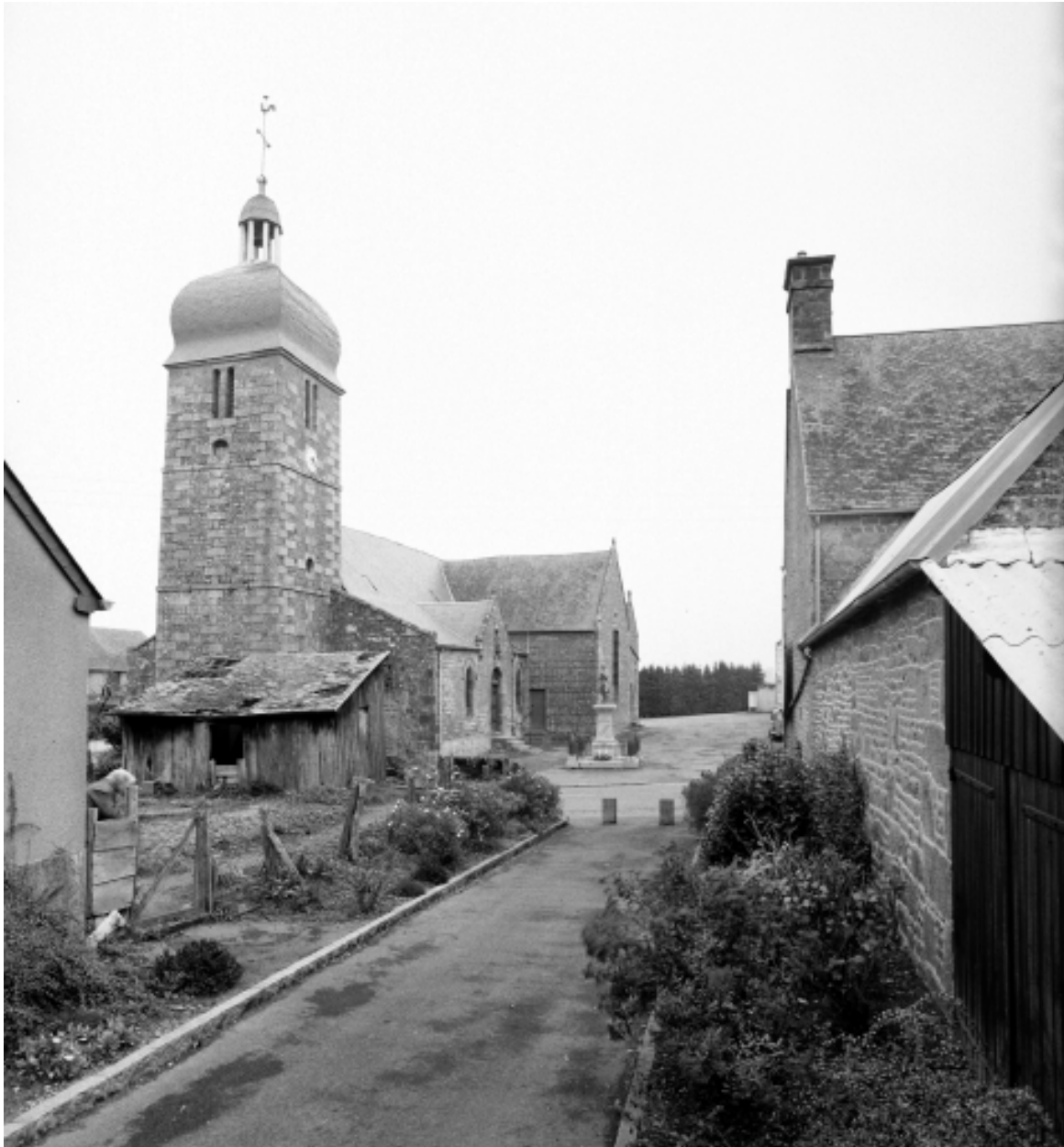
Elévation Sud-Ouest : vue de situation
