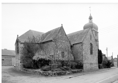
Elévation Nord-Est : vue générale Phot. Bernard Bègne, Phot. M. Loyon IVR53_19933500473X
