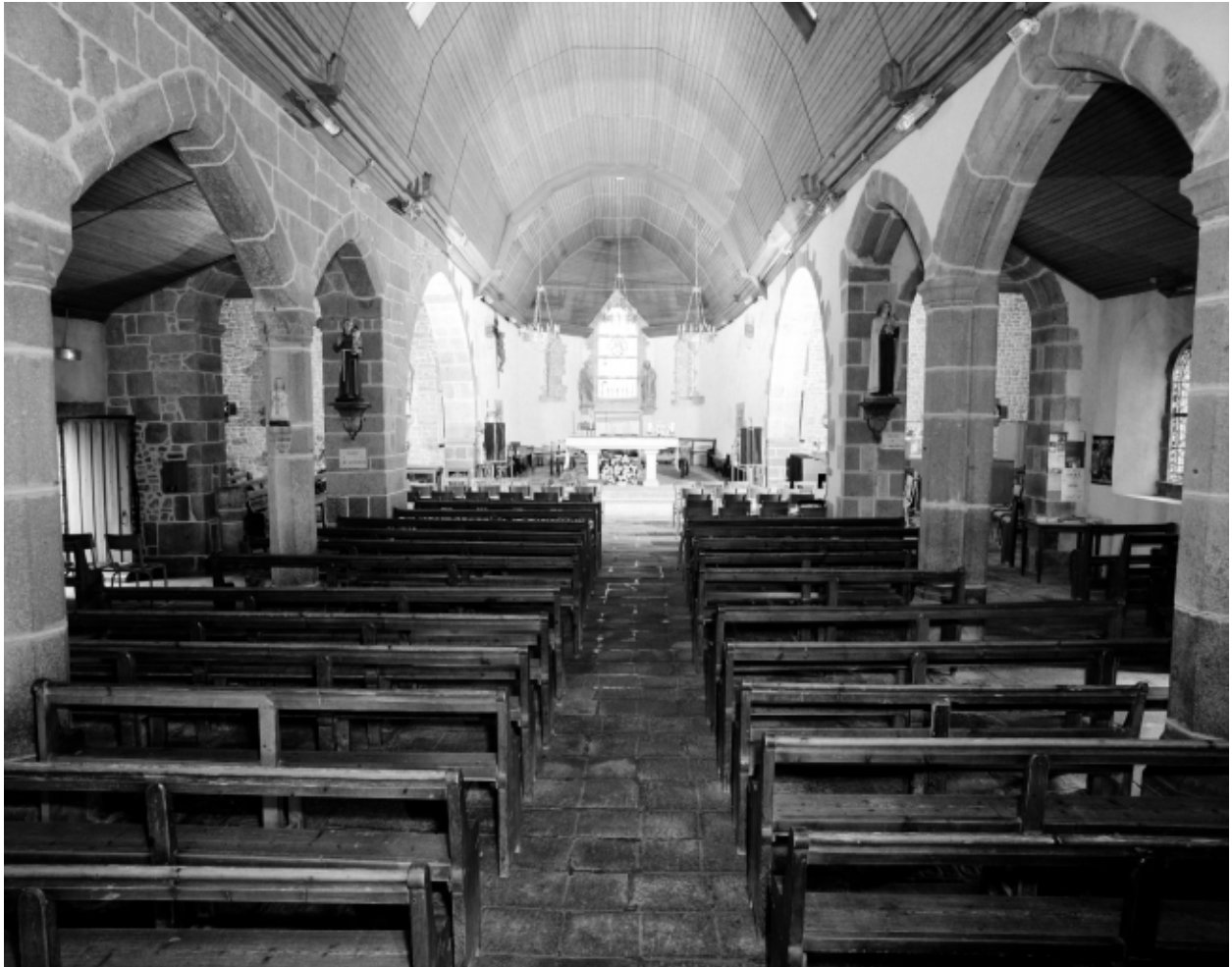
Intérieur : vue générale vers le chœur.
