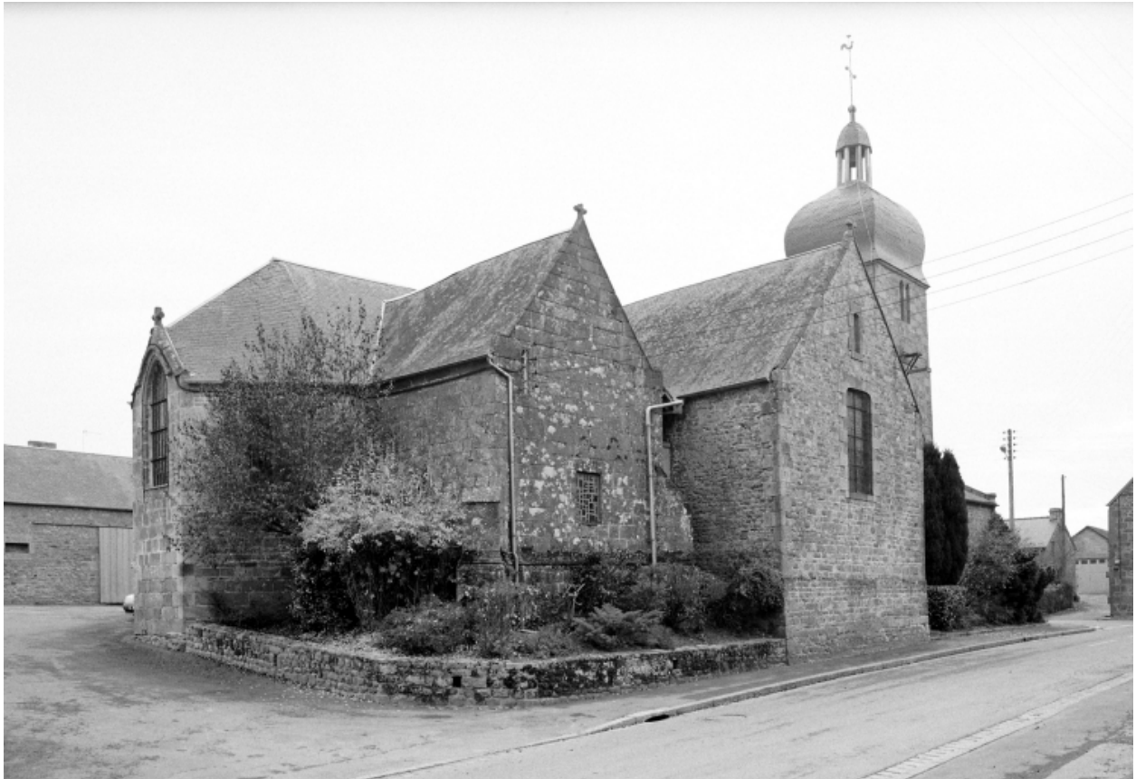
Elévation Nord-Est : vue générale
