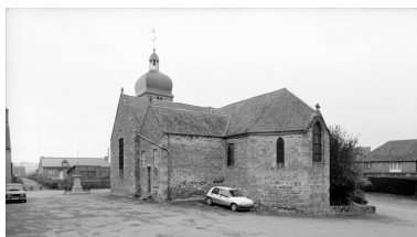
Elévation Sud-Est : vue générale Phot. Bernard Bègne, Phot. M. Loyon IVR53_19933500471X
