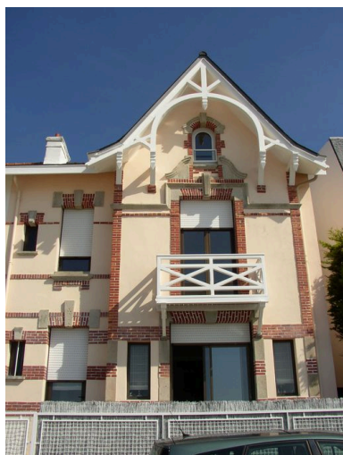
Vue générale de la maison de villégiature du 24 boulevard de Toulhars Phot. Johan Vincent IVR53_20065606539NUCA
