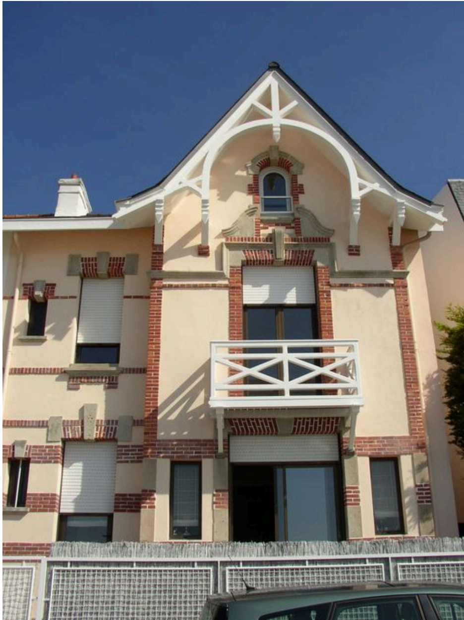
Vue générale de la maison de villégiature du 24 boulevard de Toulhars
