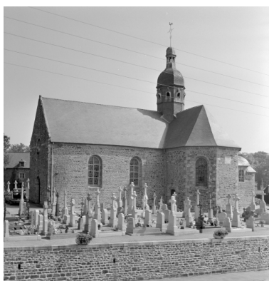
Elévation Sud-Ouest : vue générale Phot. Guy Artur, Phot. Norbert Lambart IVR53_19943501449X
