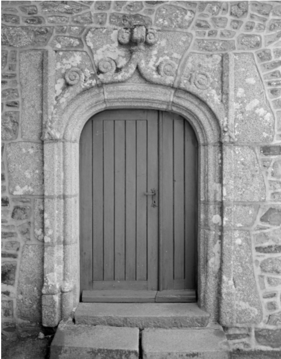
Elévation Ouest, bras Sud du transept, porte : vue générale
