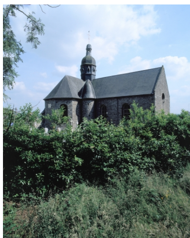
Élévation Nord, partie Est : vue générale Phot. Guy Artur, Phot. Norbert Lambart IVR53_19953500388XA
