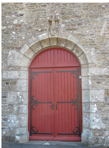
Porte principale Phot. Stéphanie Bardel IVR53_20143507098NUCA
