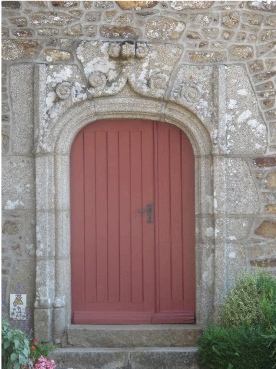
Elévation Ouest, bras Sud du transept, porte : vue générale
