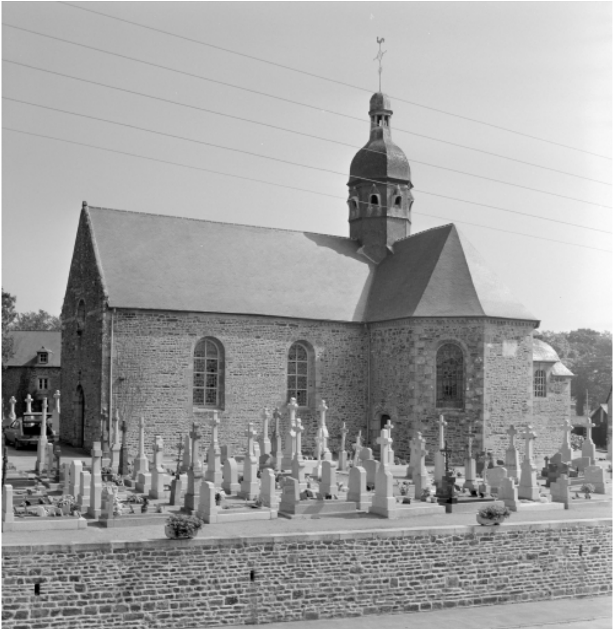
Elévation Sud-Ouest : vue générale
