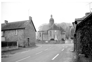
Élévation Est : vue générale Phot. Guy Artur, Phot. Norbert Lambart IVR53_19933500646X
