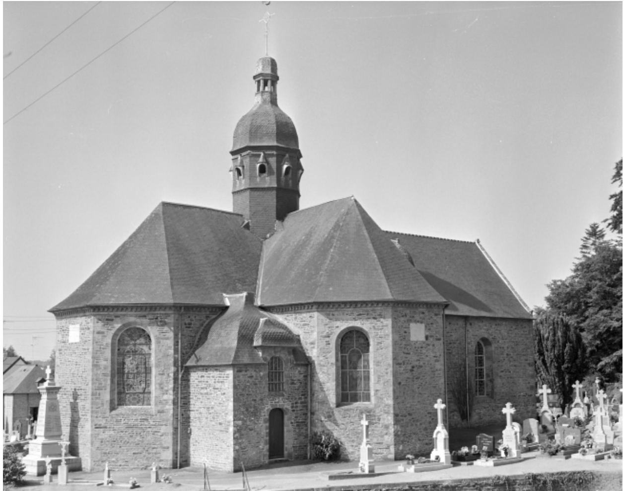
Elévation Nord-Est : vue générale
