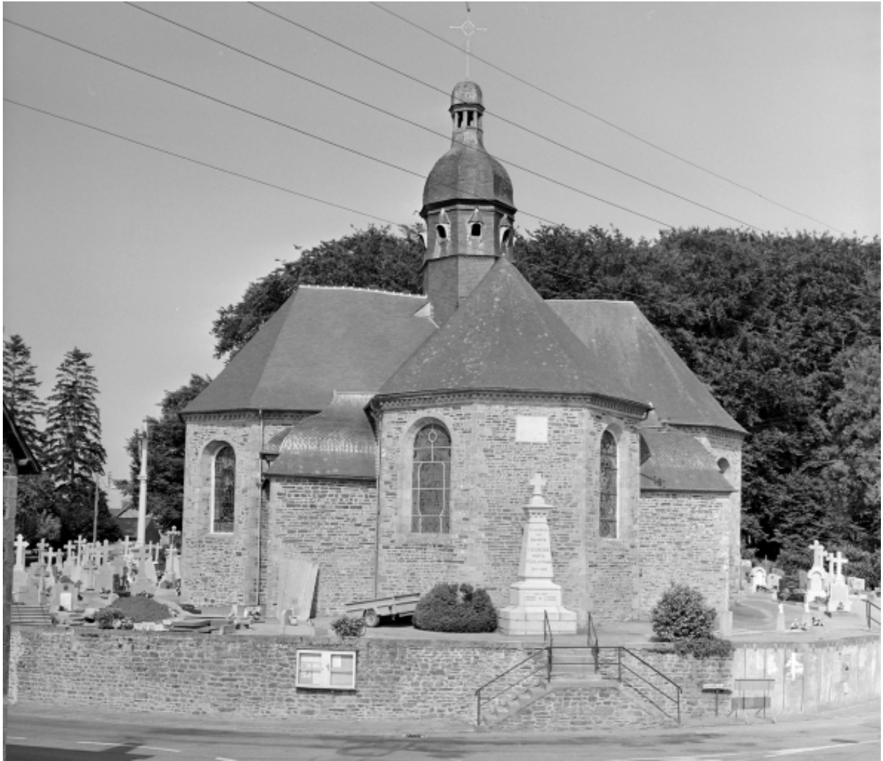
Elévation Est : vue générale
