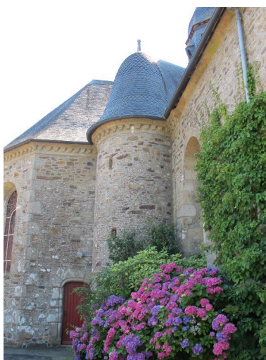
Elévation Nord partie Est Phot. Stéphanie Bardel IVR53_20143507096NUCA
