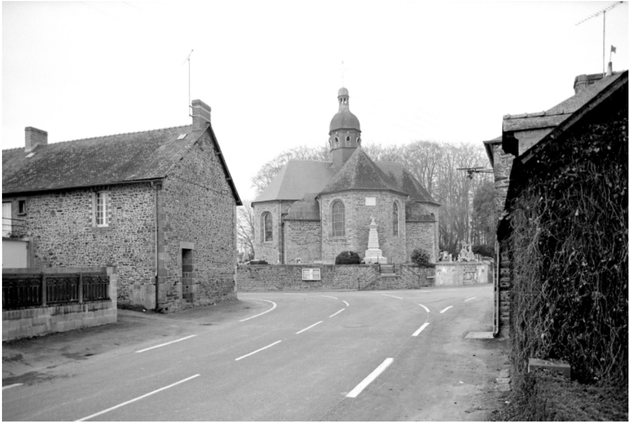
Elévation Est : vue générale
