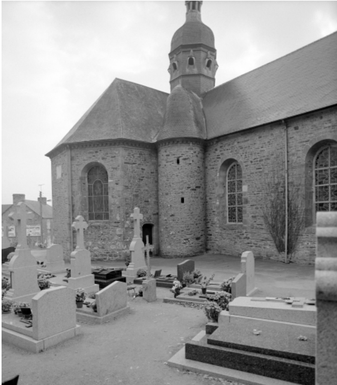
Elévation Nord, partie Est : vue générale
