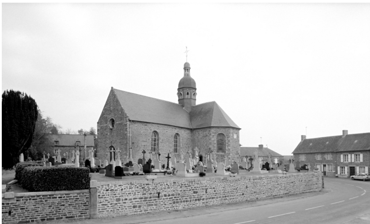
Elévation Sud-Ouest : vue générale
