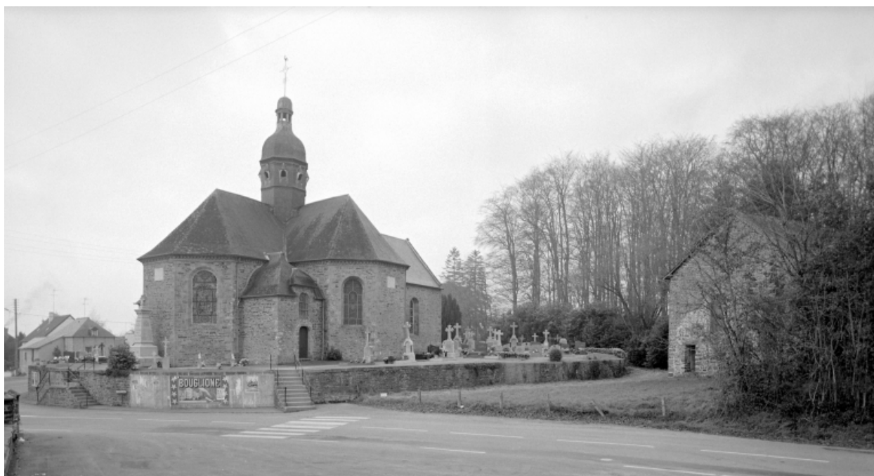
Elévation Nord-Est : vue générale
