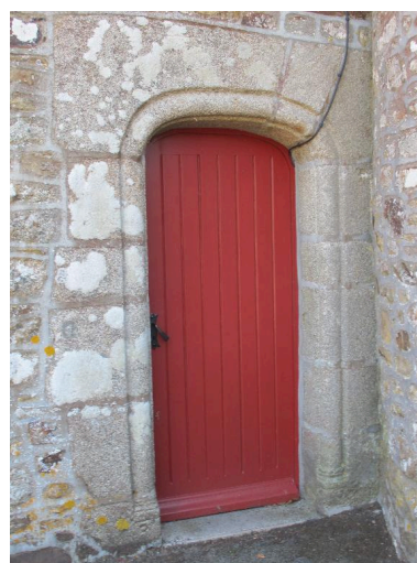
Porte, élévation nord partie est Phot. Stéphanie Bardel IVR53_20143507100NUCA
