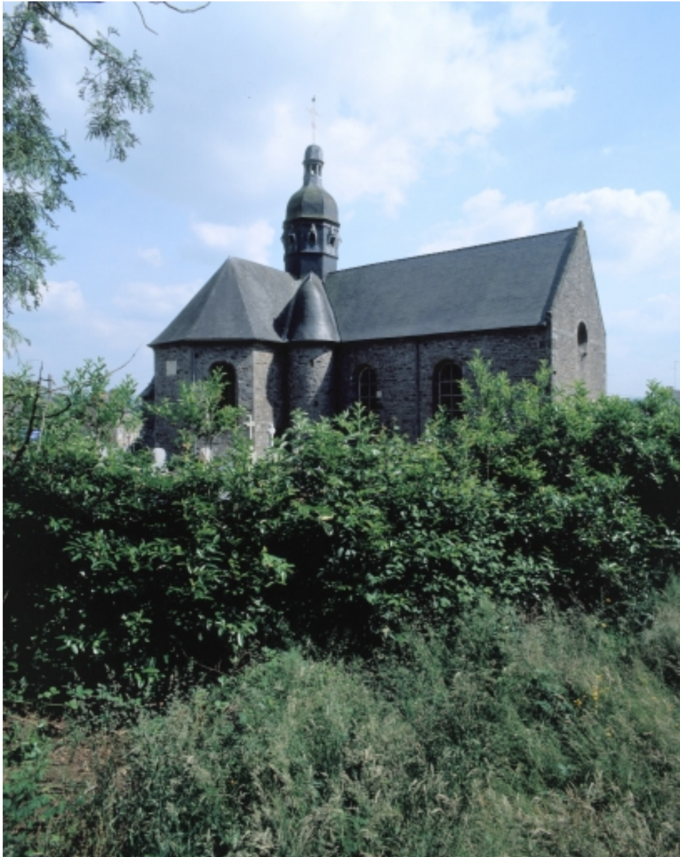
Elévation Nord, partie Est : vue générale
