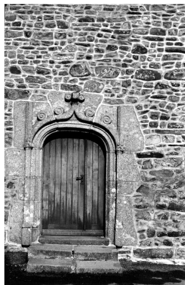
Porte latérale sud-ouest Phot. Service régional de l'Inventaire de Bretagne IVR53_20083508485Z
