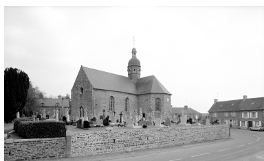
Elévation Sud-Ouest : vue générale Phot. Guy Artur, Phot. Norbert Lambart IVR53_19933500643X
