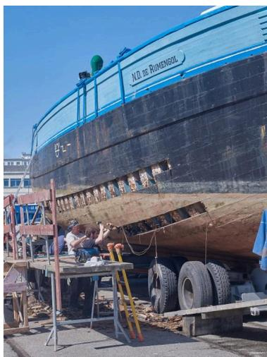
Changement des bordages de la coque par le chantier naval du Guip
