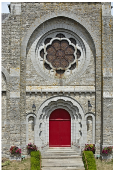
Détail de la façade sud Phot. Rozenn Turni IVR53_20113502019NUCA
