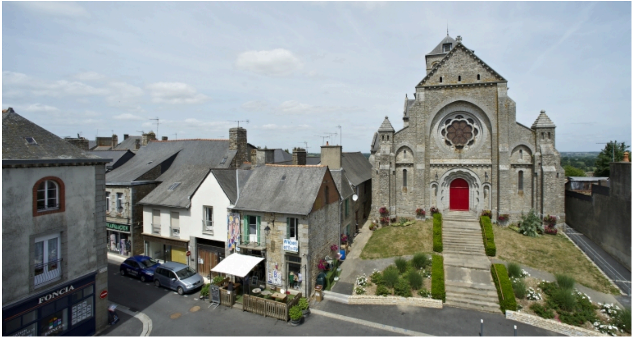
Vue générale sud
