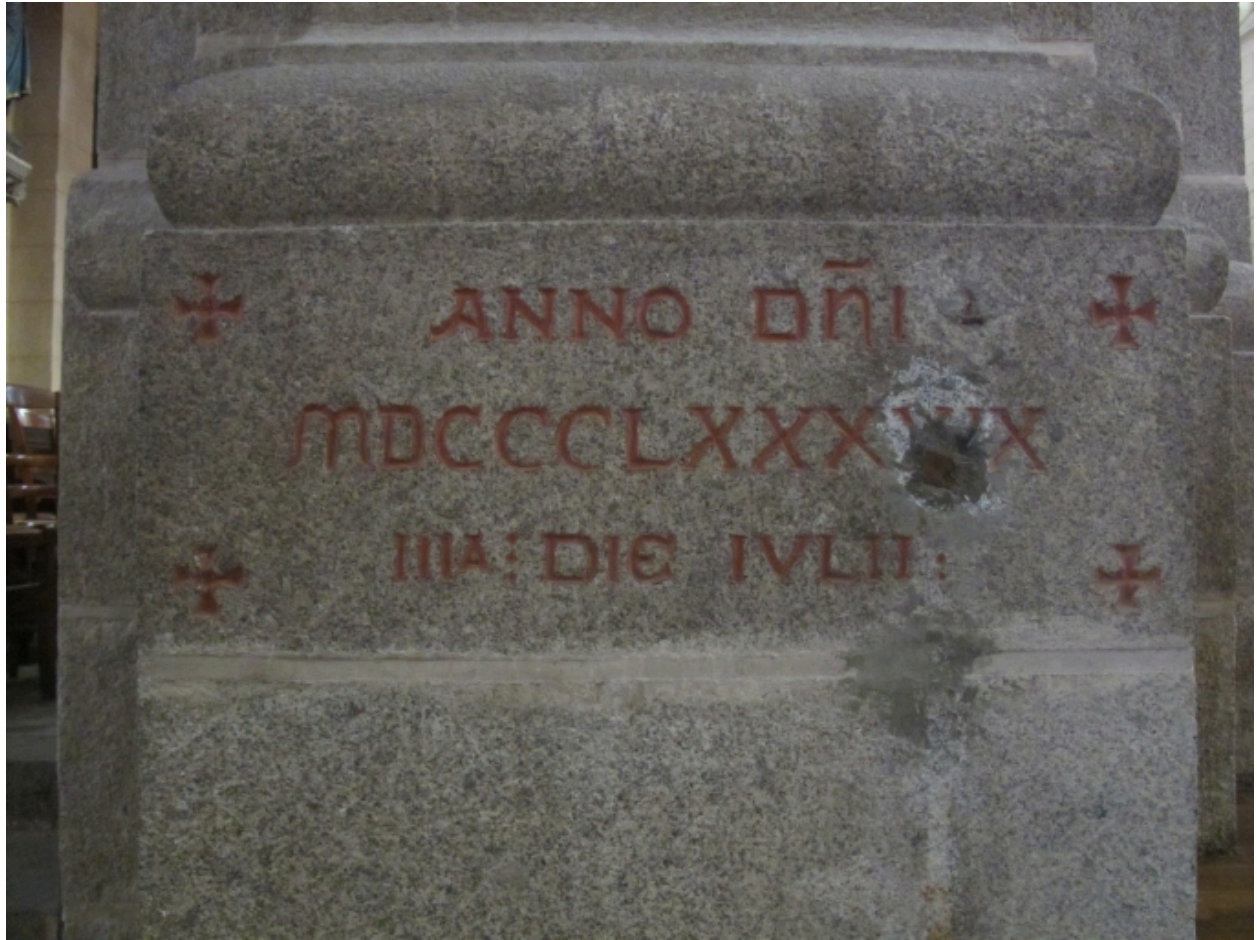
Inscription et date portées à l'intérieur de l'édifice
