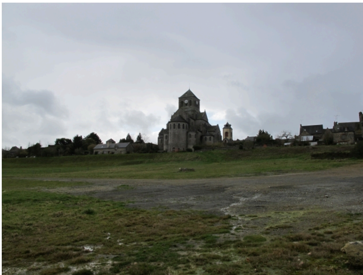
Vue générale nord
