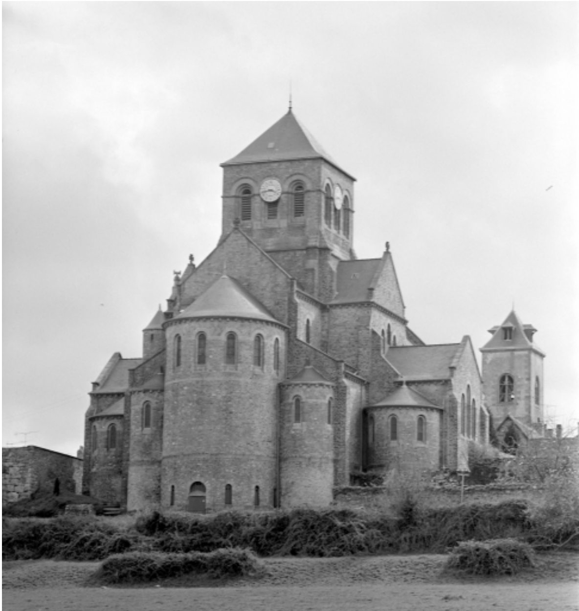
Elévation Nord : vue générale
