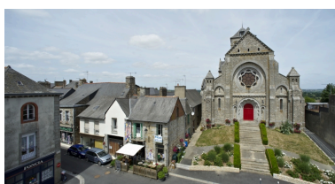
Vue générale sud Phot. Rozenn Turni IVR53_20113502299NUCA
