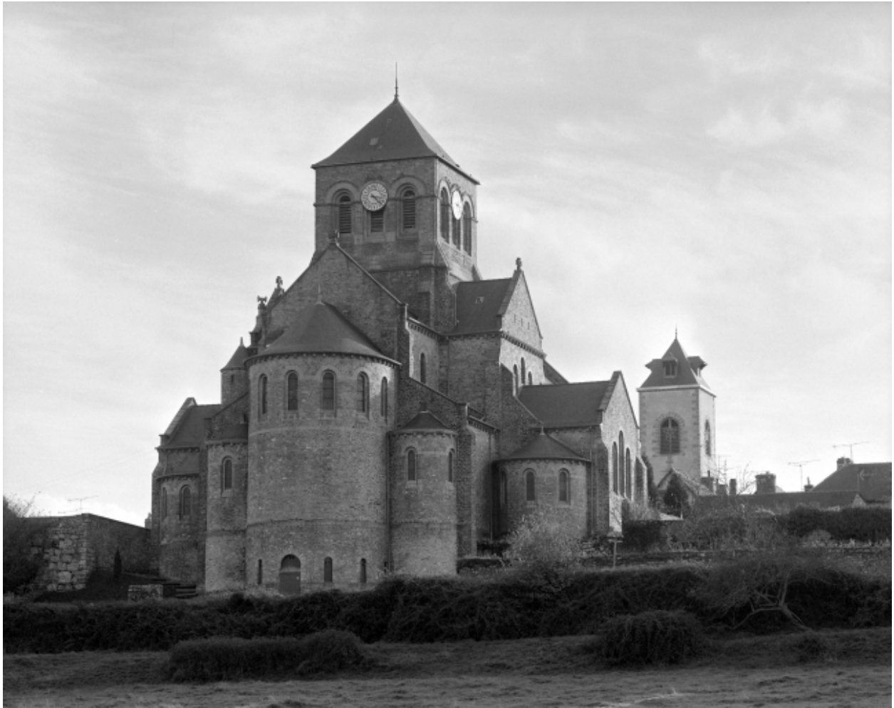
Elévation Nord : vue générale
