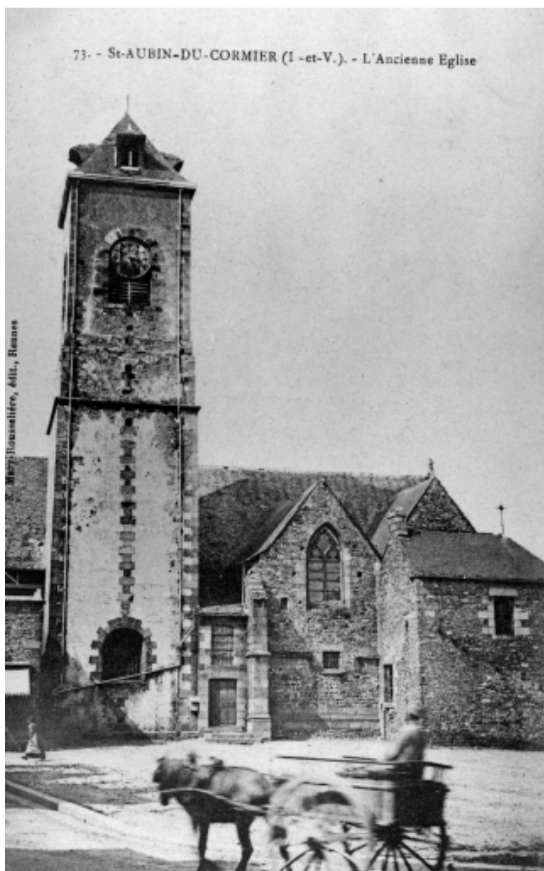
Ancienne église, partie Sud Est et tour (repro.carte postale ancienne)
