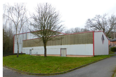
Vue générale prise de l'est Phot. Philippe Bonnet IVR53_20185605029NUCA
