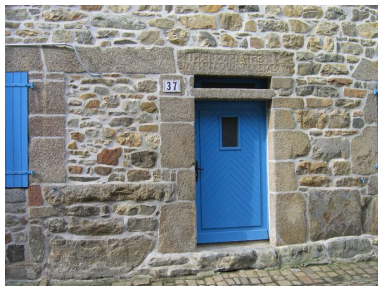
Elévation antérieure, détail de la porte avec seuil surélevé et linteau gravé
