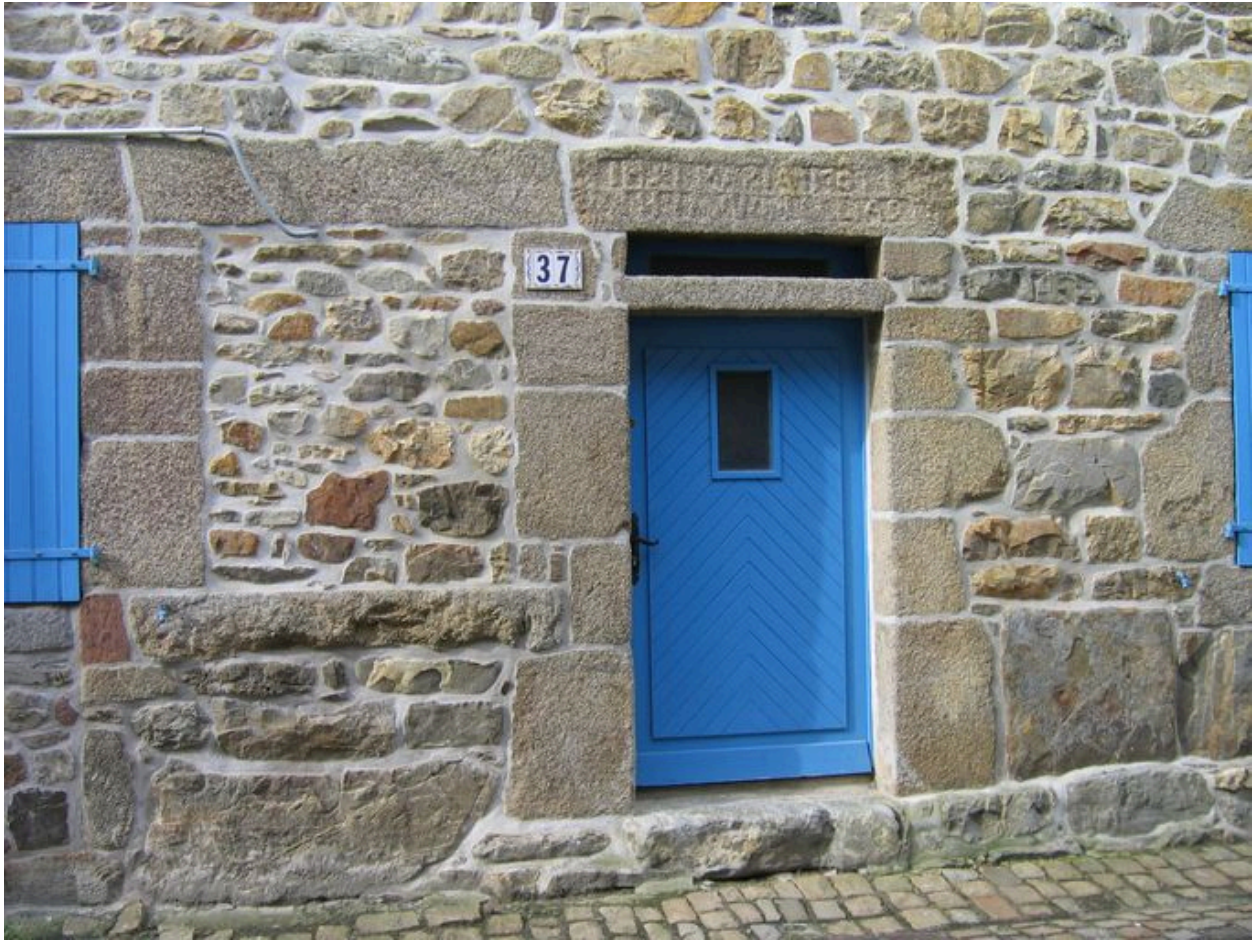
Élévation antérieure, détail de la porte avec seuil surélevé et linteau gravé
