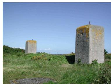
Vue générale des supports de radar Mammut (blocs verticaux comportant les 24 tubes de descente d'antenne)
