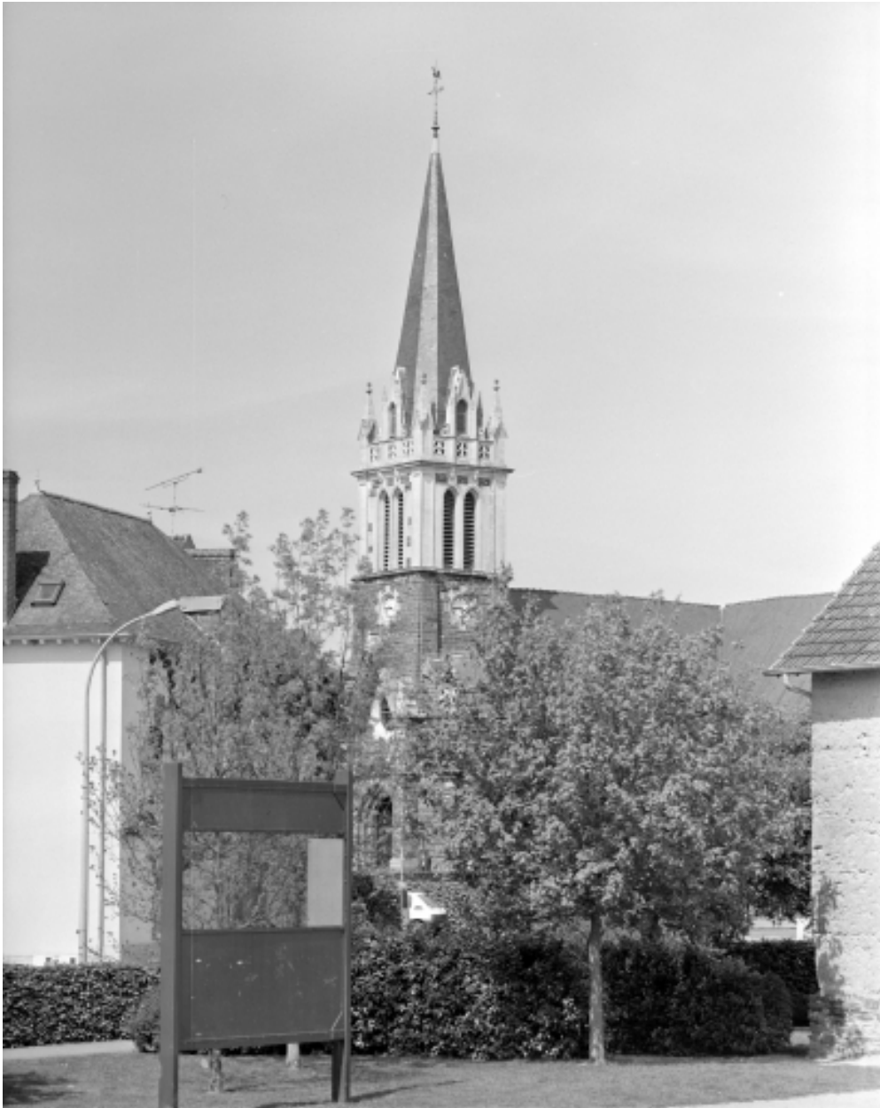
Elévation Sud-Ouest : vue générale
