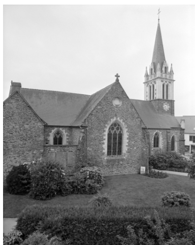
Elévation Nord : vue générale Phot. Guy Artur, Phot. Norbert Lambart IVR53_19943500878X
