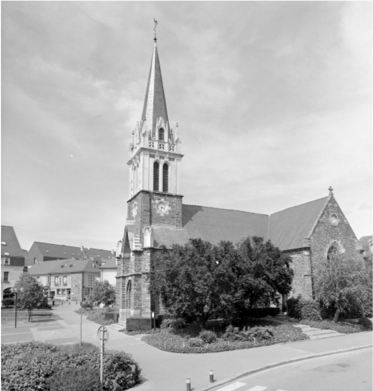
Elévation Sud-Ouest : vue générale
