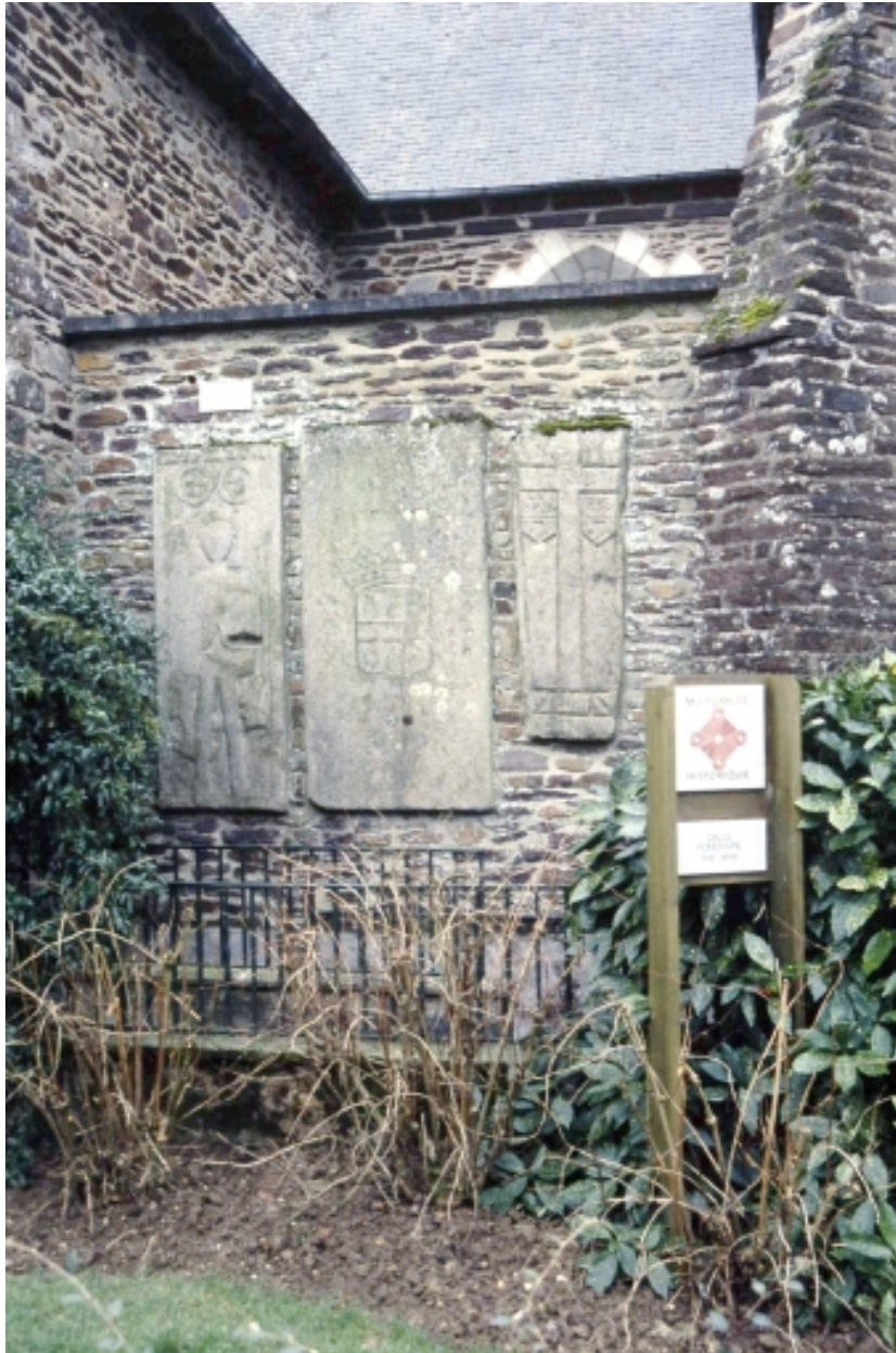
Pierres tombales sur la façade nord.
