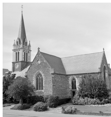
Elévation Sud-Est : vue générale Phot. Guy Artur, Phot. Norbert Lambart IVR53_19943500869X
