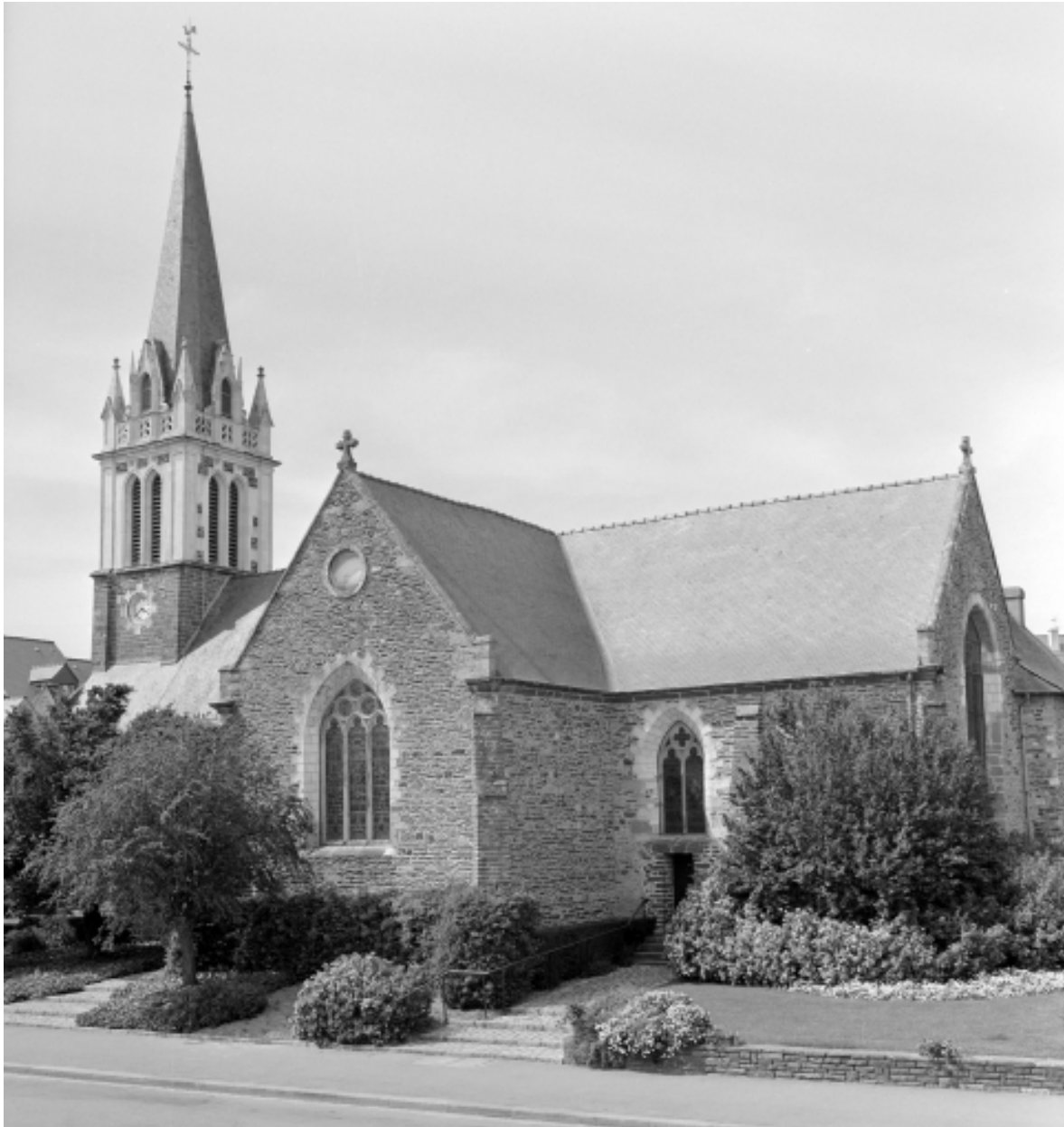
Elévation Sud-Est : vue générale
