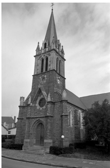
Eglise paroissiale - Vue générale ouest Phot. Sylvie Laffiché, Phot. Marie-Madeleine Tugores IVR53_19753506047Z
