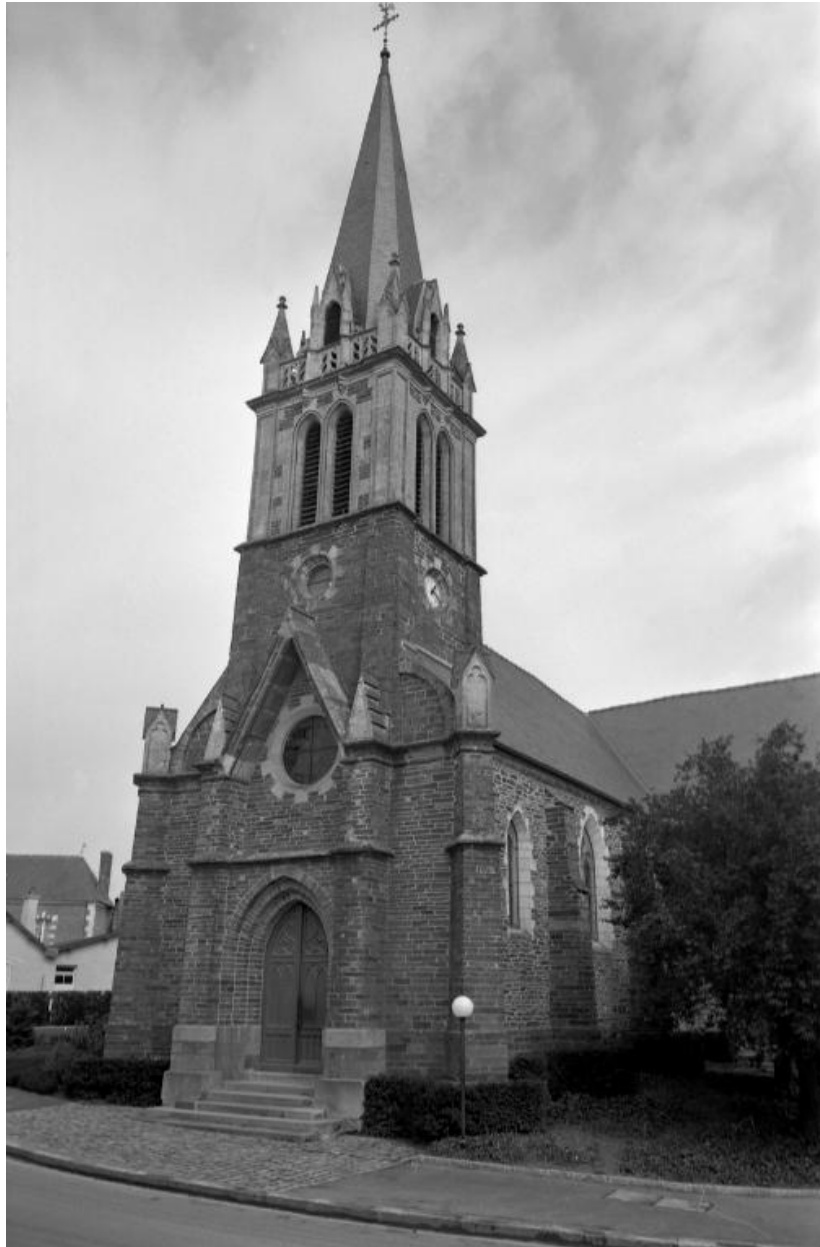
Eglise paroissiale - Vue générale ouest
