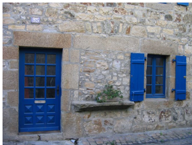
Elévation antérieure, détail de la tablette servant à la vente directe de sardines Phot. Guillaume Marie IVR53_20062908351NUCA
