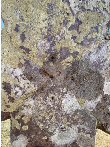
Face ouest, détail Phot. Baptiste Oligo IVR53_20255610906NUCA
