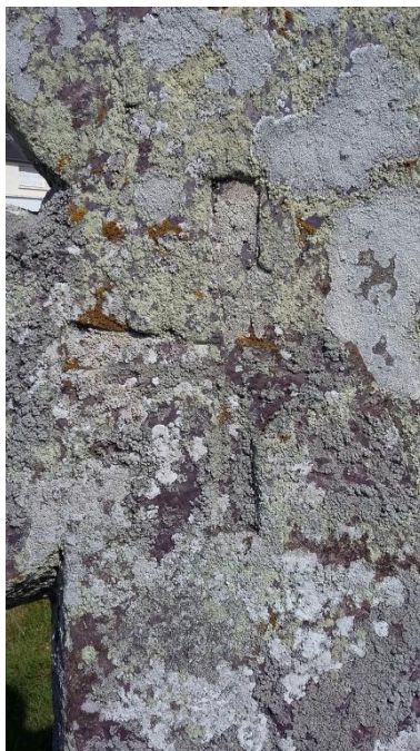
Détail face est Phot. Julien Huon IVR53_20165605447NUCA
