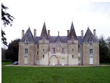
Façade principale : vue générale sud Phot. Xavier Gilbert IVR53_19993504734NUCA
