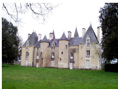
Façade postérieure donnant sur l'étang : vue générale nord-ouest Phot. Xavier Gilbert IVR53_19993504735NUCA
