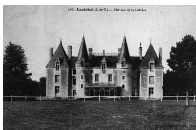
Le château, façade principale, sur une carte postale du début du 20e siècle : vue générale sud Repro. Guy Artur, Repro. Norbert Lambart IVR53_19993509568X
