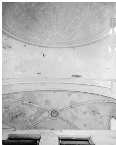
Intérieur, plafond : détail
