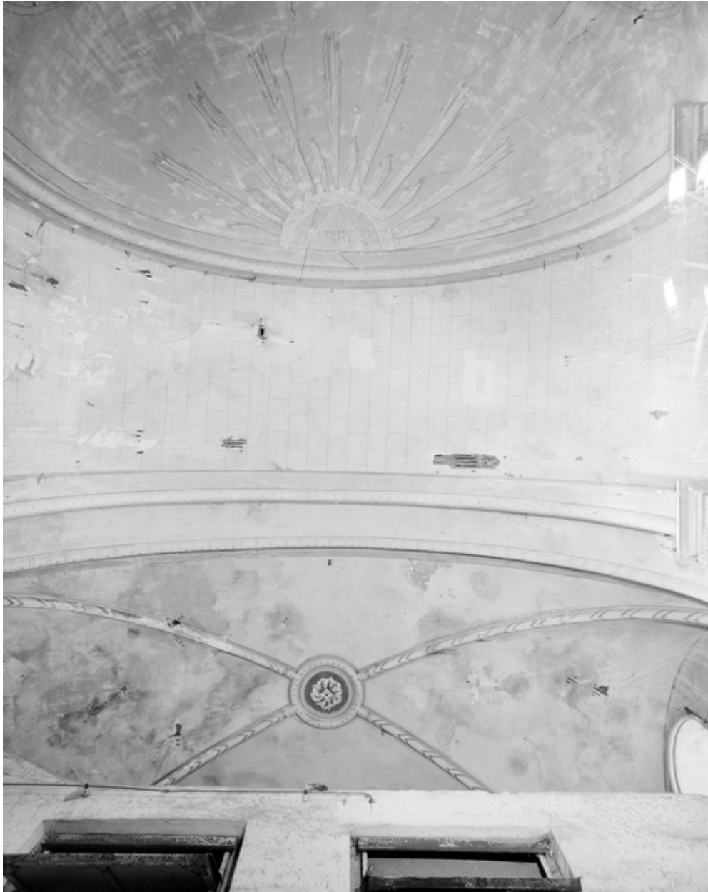
Intérieur, plafond : détail
