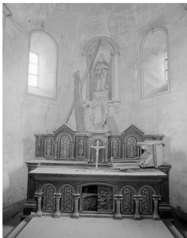
Intérieur, choeur : vue générale
